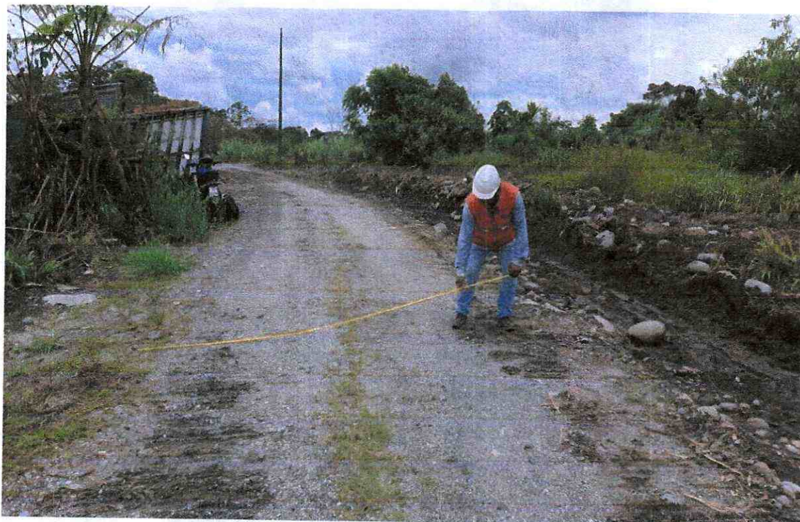
Imagen 5. Personal operativo con su respectivo EPP
