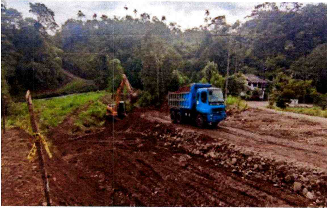
ANEXO 3: Área del proyecto de obra civil
