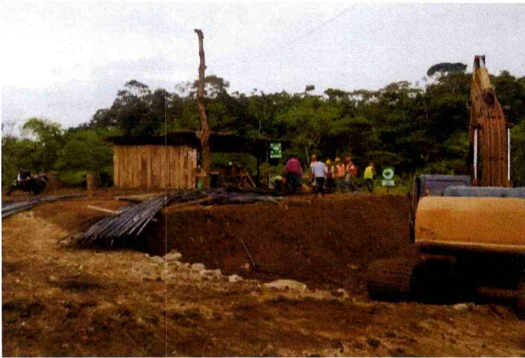
ANEXO 8: Registro y uso de EPP en actividades de construcción
