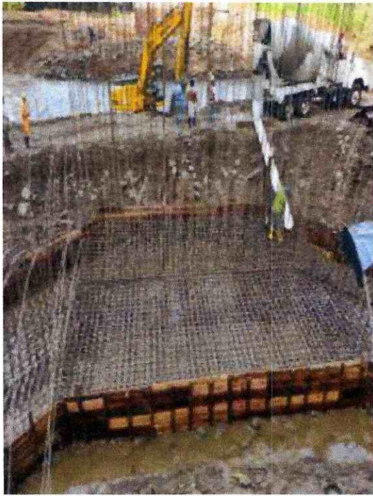
ANEXO 5: Distribución de hormigón mediante mixer
