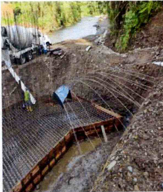
ANEXO 4: Transporte y distribución de hormigón mediante mixer.
