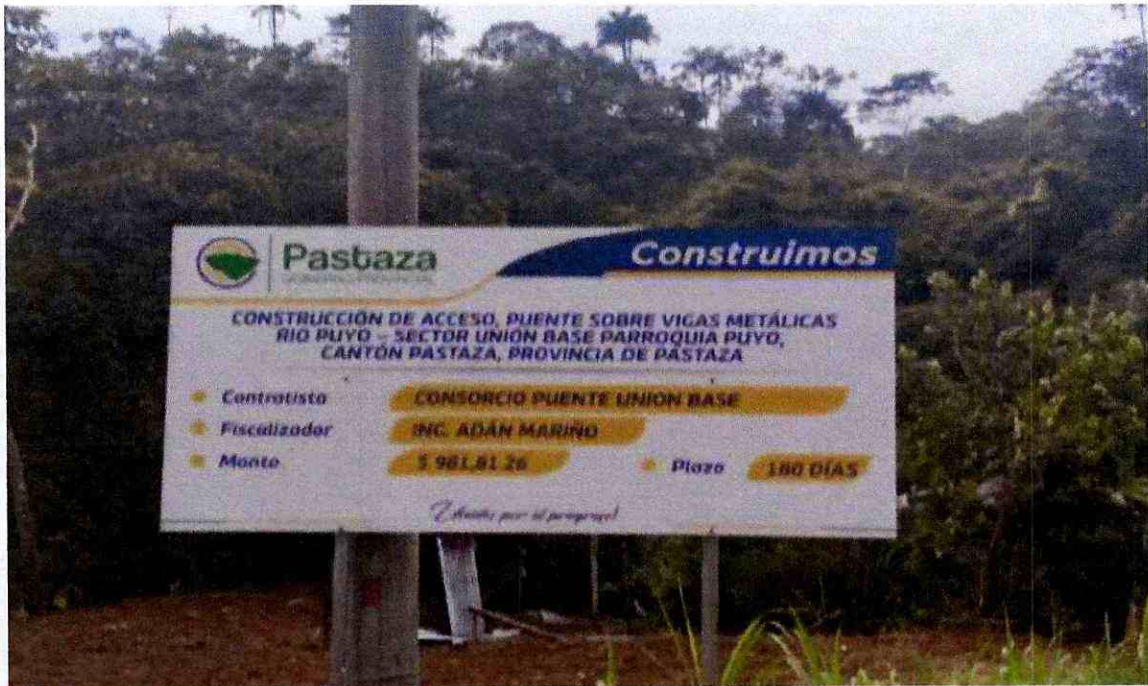
ANEXO 8: Señalización del área de intervención
