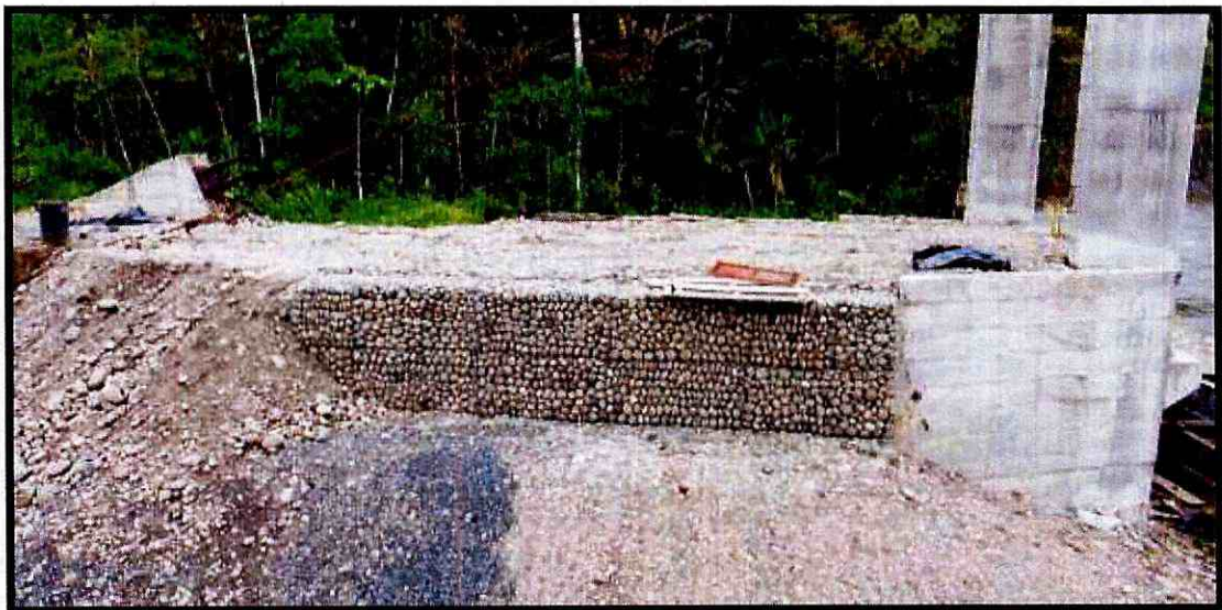
Fotografía 2. Muros de gaviones, margen izquierdo
