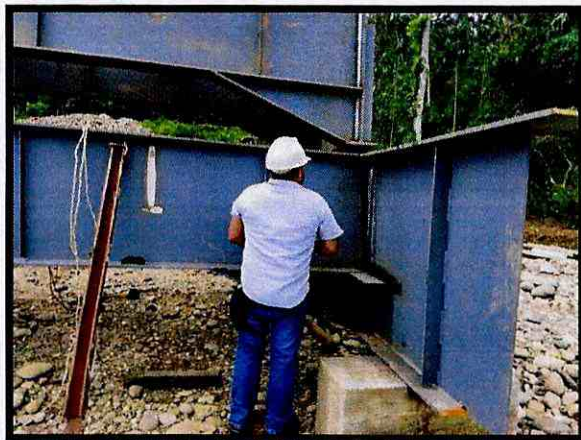
4.- Inspección visual de la soldadura
