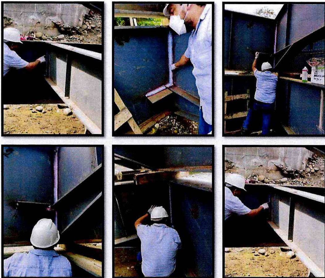
9.- Inspección del resultado del ensayo de tintas
