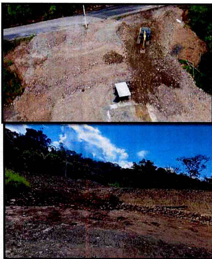
Fotografía 6. Construcción de accesos
