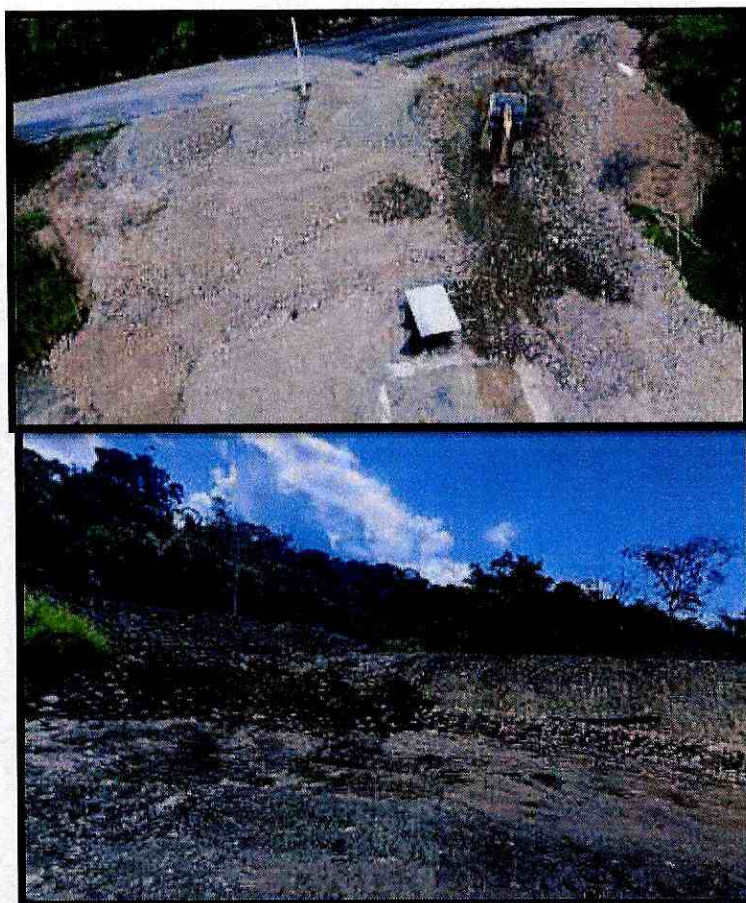
Fotografía 6. Construcción de accesos
