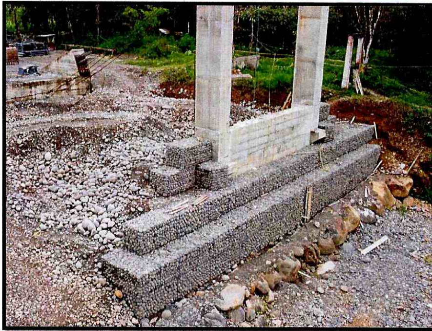
Fotografía 3. Muros de gaviones, margen derecho
