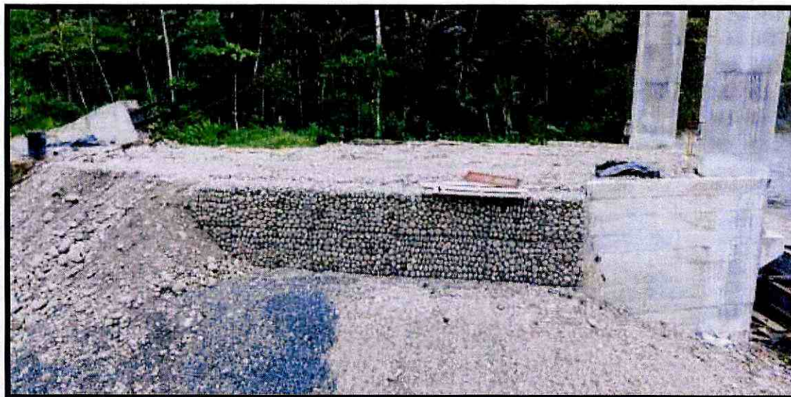
Fotografía 2. Muros de gaviones, margen izquierdo
