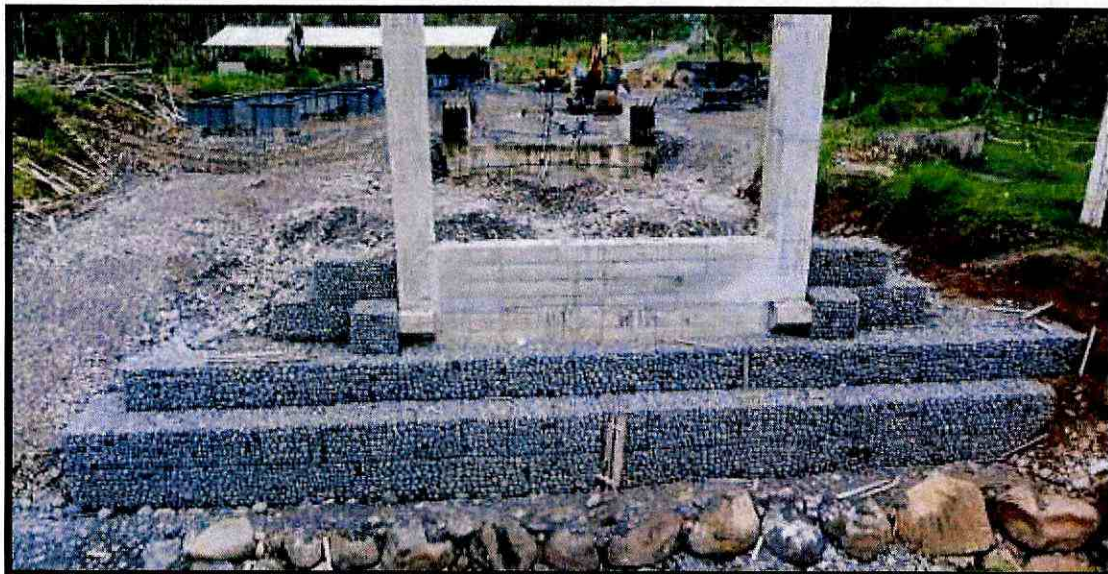
Fotografía 1. Muros de gaviones, margen derecho
