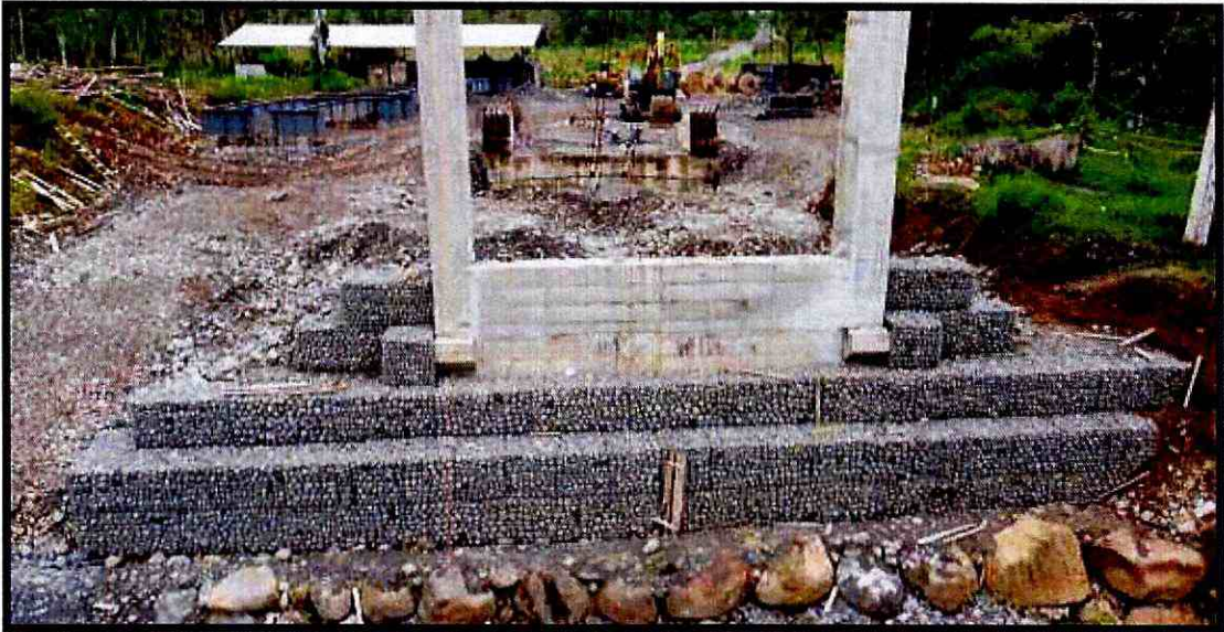
Fotografía 1. Muros de gaviones, margen derecho
