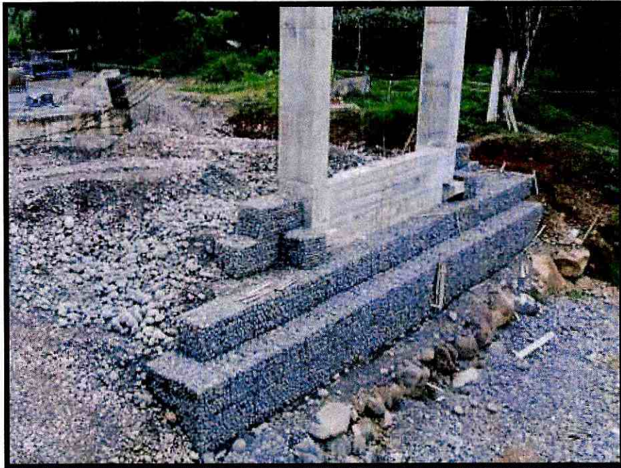
Fotografía 3. Muros de gaviones, margen derecho
