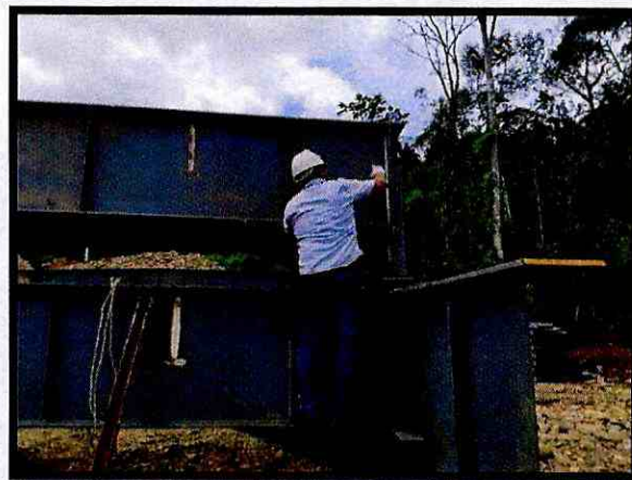
5.- Limpieza de los cordones de soldaduras seleccionados.
