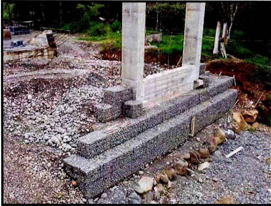
Fotografía 3. Muros de gaviones, margen derecho
