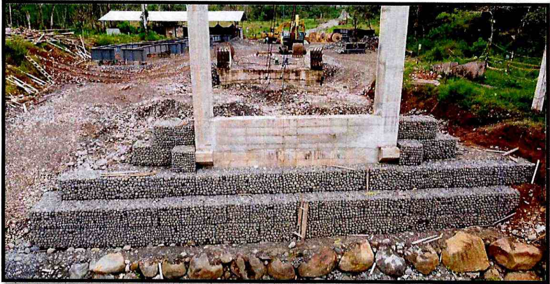
Fotografía 1. Muros de gaviones, margen derecho
