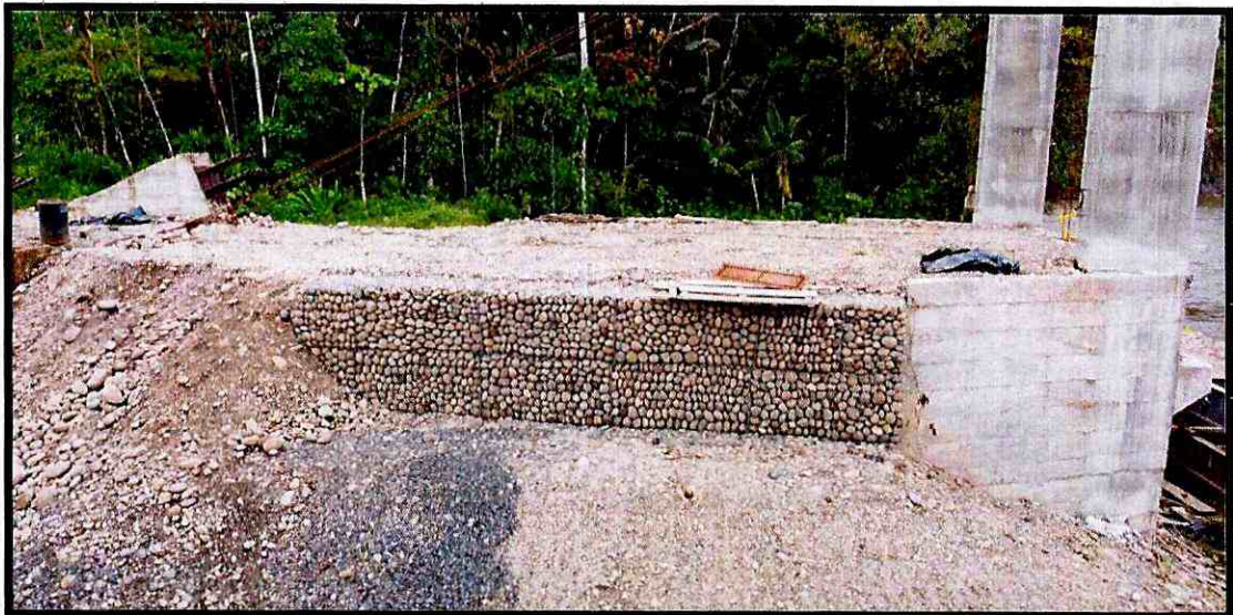
Fotografía 2. Muros de gaviones, margen izquierdo
