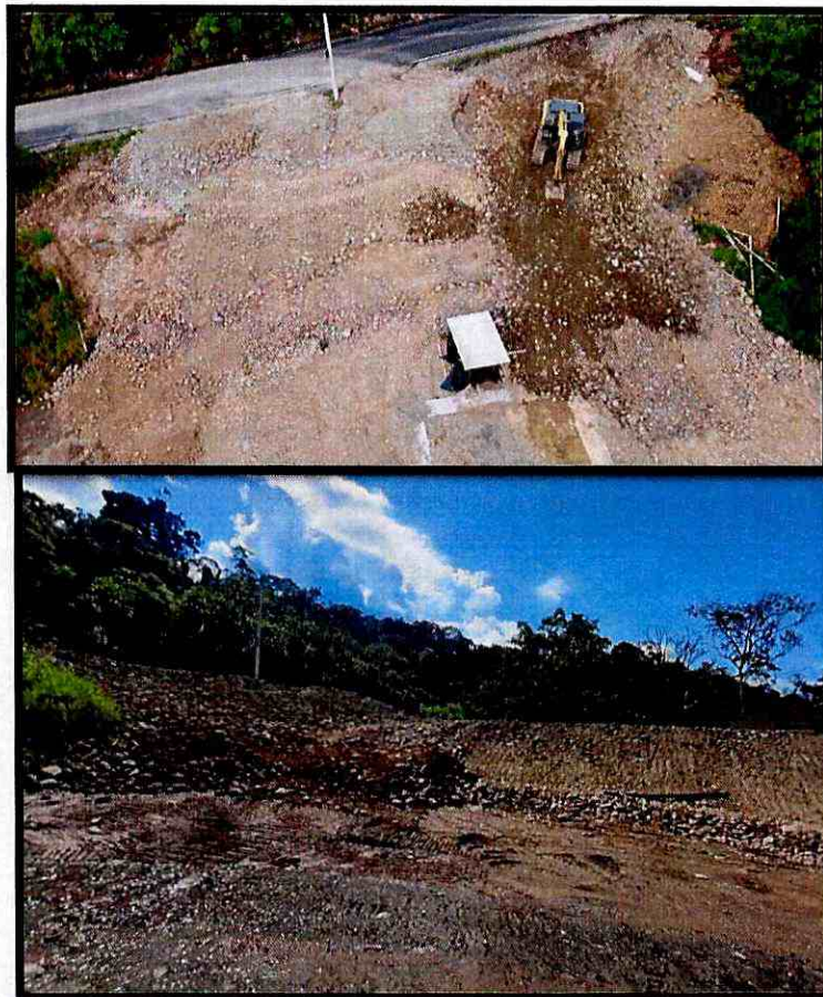
Fotografía 6. Construcción de accesos
