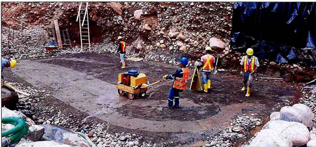
Fotografía 2: relleno compactado para cimentación de la torre derecha
