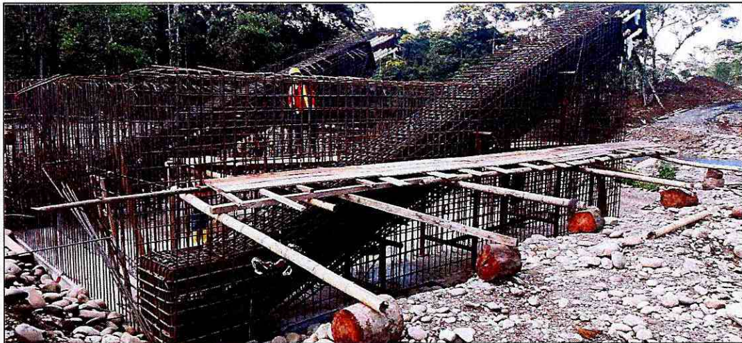
Fotografía 14: instalación y amarre de hierros de muros laterales del cajón de anclaje
