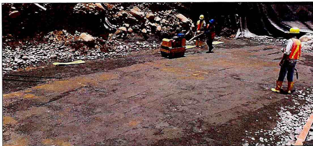
Fotografía 3: relleno compactado para cimentación de la torre derecha
