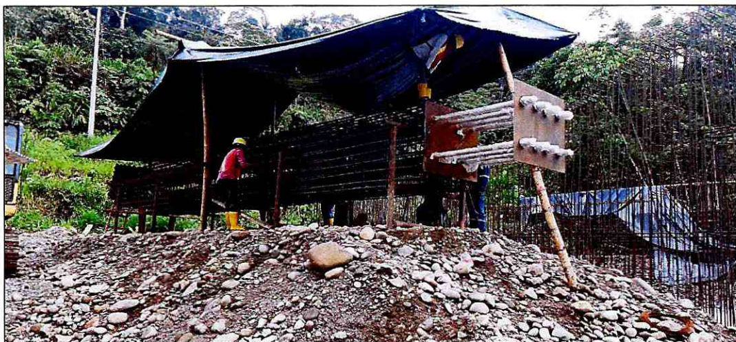
Fotografía 12: armado y amarre del hierro de la viga de anclaje
