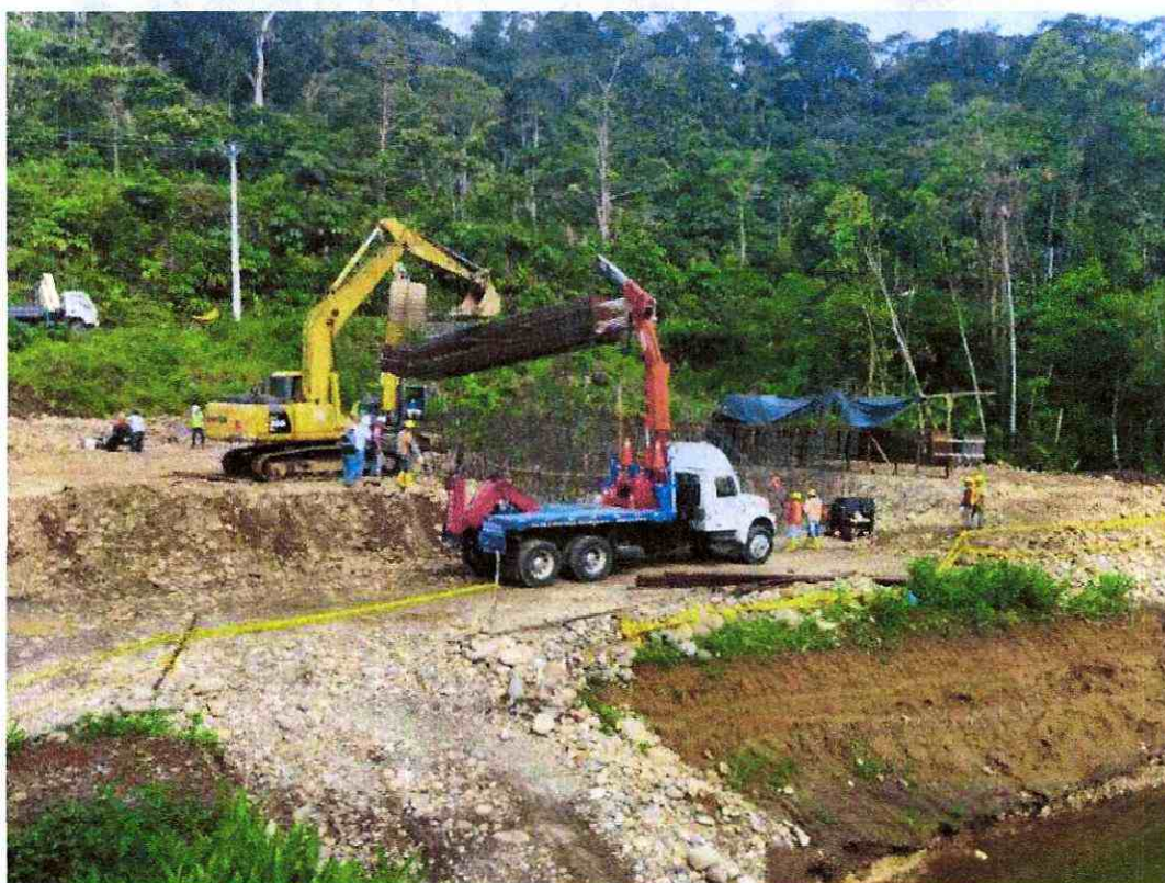
Fotografía 4. Proceso montaje de anclajes
