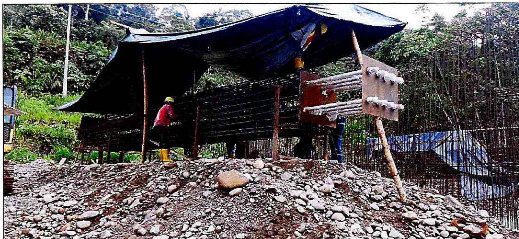
Fotografía 12: armado y amarre del hierro de la viga de anclaje
