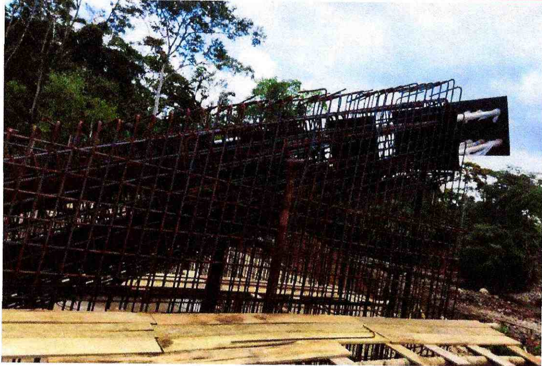
Fotografía 5. Montaje terminado de anclajes
