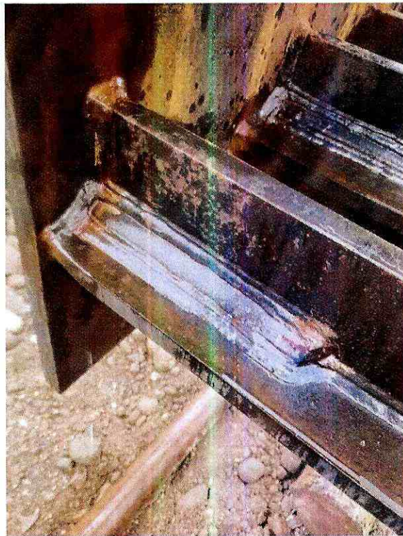
Fotografía 4. Soldadura placa guía (pos 86), placa (pos 84) y pernos (pos 87)
