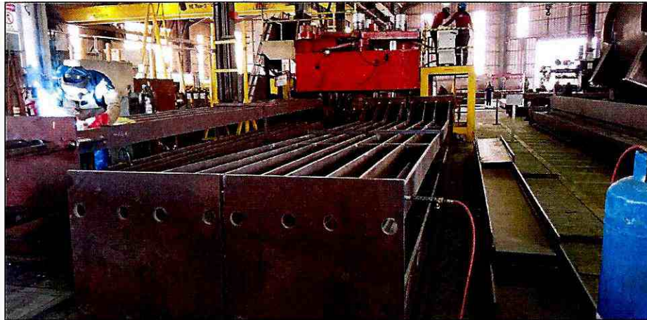
Fotografía 19: fabricación de acero A 588
