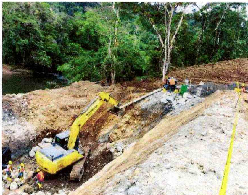
Fotografía 1. Excavación – relleno para cimentación margen derecho
