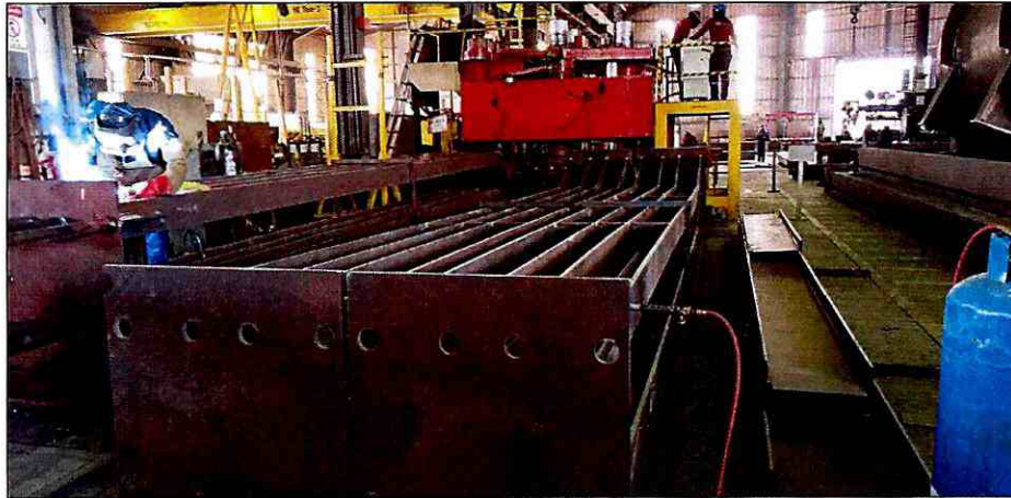
Fotografía 19: fabricación de acero A 588
