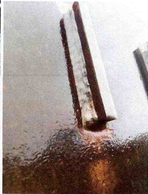
Fotografía 6. Soldadura de placa guía.
