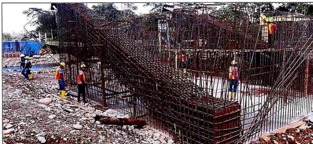
Fotografía 15: instalación y amarre de hierros de muros laterales del cajón de anclaje
