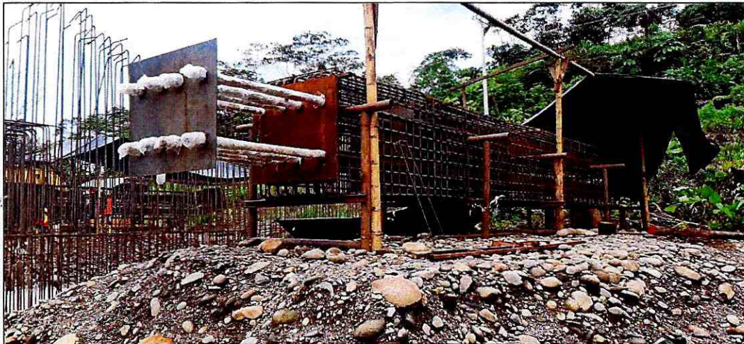
Fotografía 11: armado y amarre del hierro de la viga de anclaje
