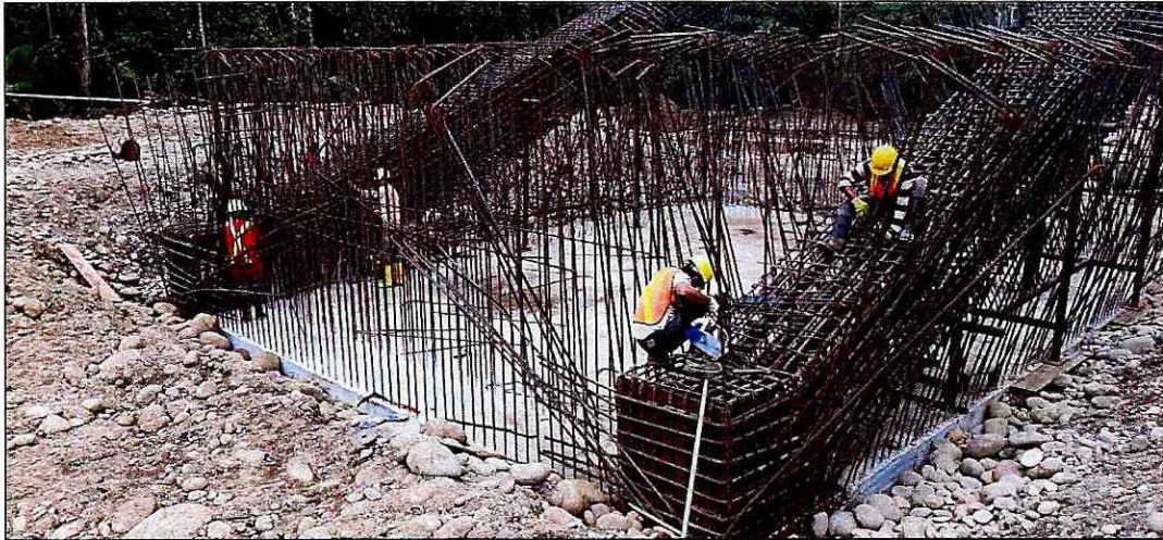
Fotografía 13: instalación y amarre de estribos de las vigas de anclaje
