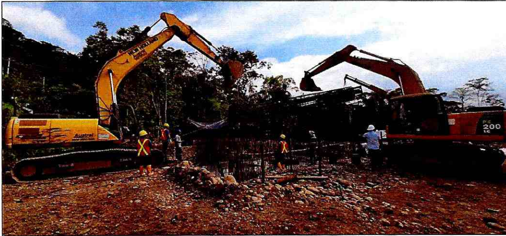
Fotografía 25: Montaje de tensores y vigas del anclaje izquierdo
