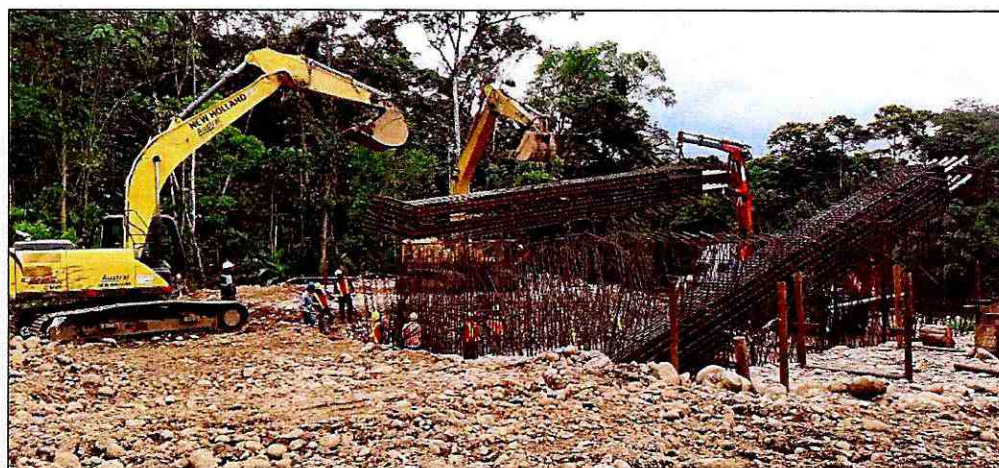
Fotografía 26: Montaje de tensores y vigas del anclaje izquierdo
