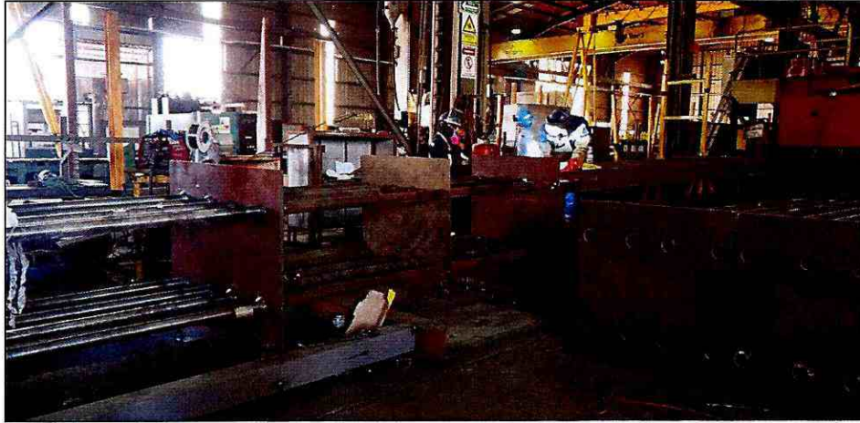
Fotografía 22: fabricación de acero AISI 4140
