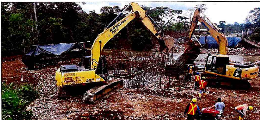
Fotografía 24: Montaje de tensores y vigas del anclaje izquierdo
