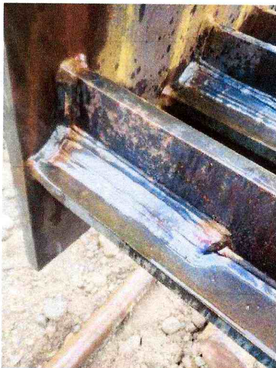
Fotografía 6. Soldadura de placa guía.
