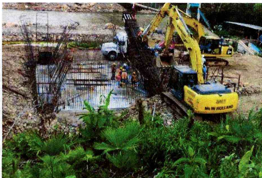
Fotografía 2. Montaje de anclajes – margen izquierdo
