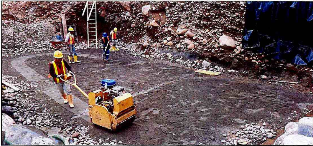
Fotografía 1: relleno compactado para cimentación de la torre derecha
