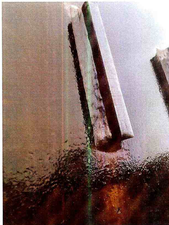
Fotografía 5. Cordón de soldadura de placa guía (pos 80)
