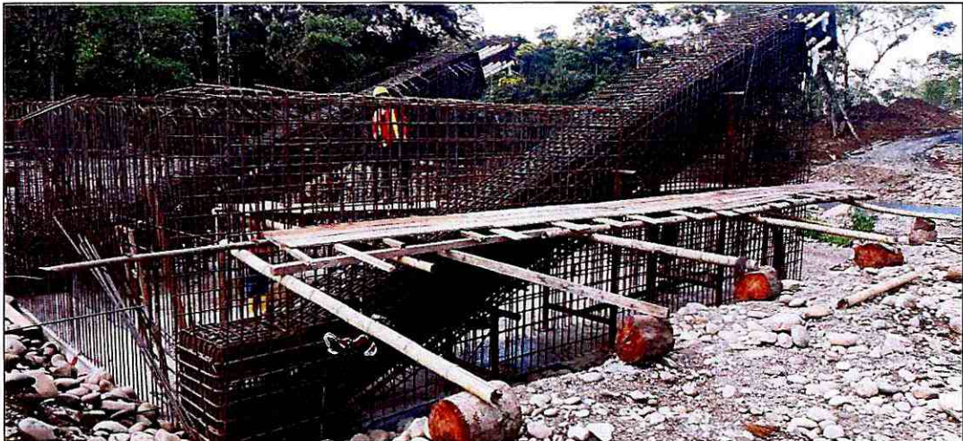
Fotografía 14: instalación y amarre de hierros de muros laterales del cajón de anclaje
