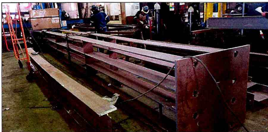
Fotografía 18: fabricación de acero A 588
