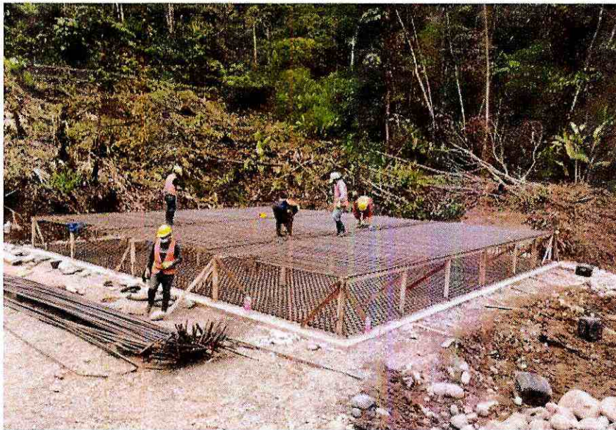
Fotografía 4. Armado de cimentación de anclaje – margen izquierdo
