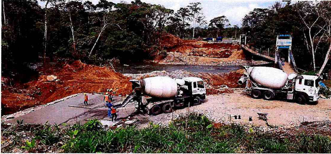
Fotografía 22: Fundido de replantillo
