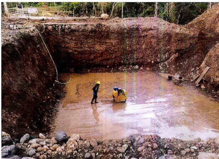
Fotografía 1. Preparación de sitio para fundir replantillo – margen derecho
