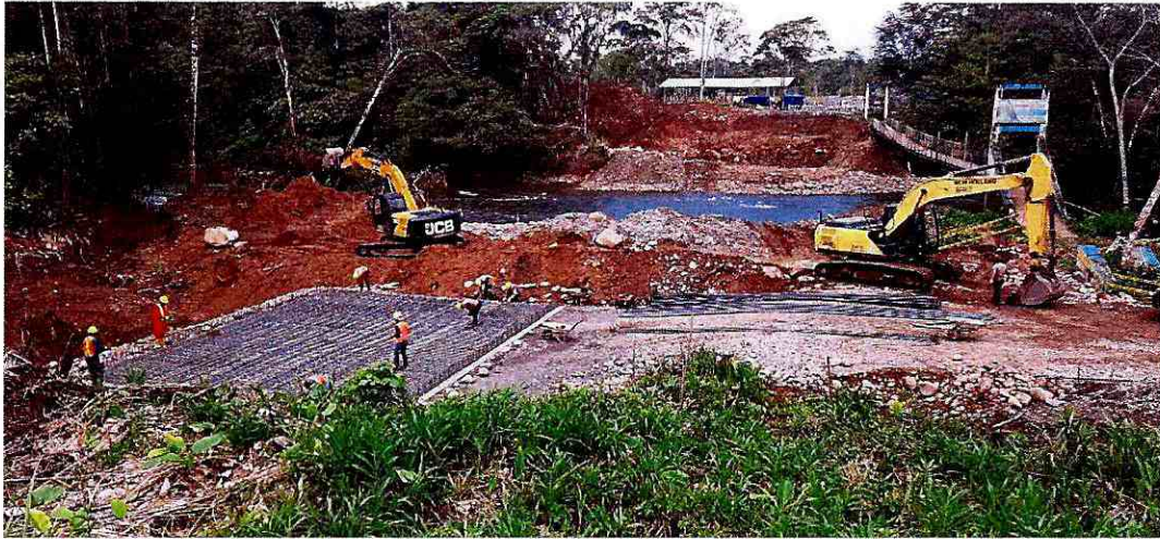
Fotografía 10: Armado de la parrilla inferior de la zapata
