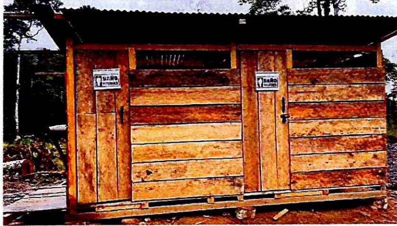
Fotografía 7. IMPLEMENTACIÓN DE BATERIAS SANITARIAS
