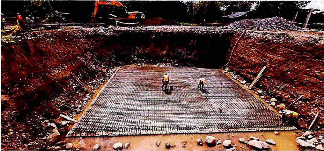
Fotografía 4: Armado de la parrilla inferior de la zapata
