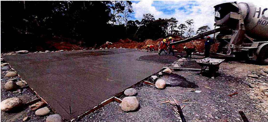
Fotografía 24: Fundido de replantillo
