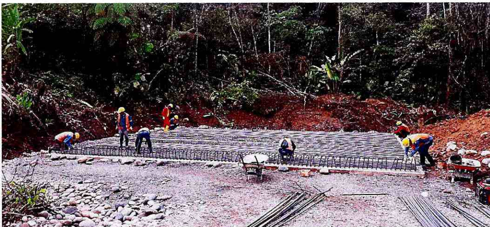
Fotografía 9: Armado de la parrilla inferior de la zapata
