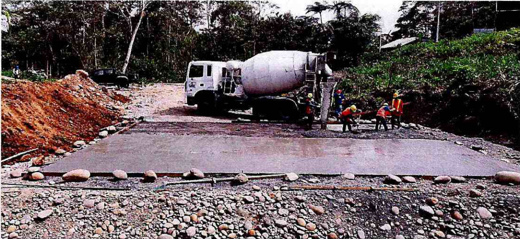
Fotografía 23: Fundido de replantillo
