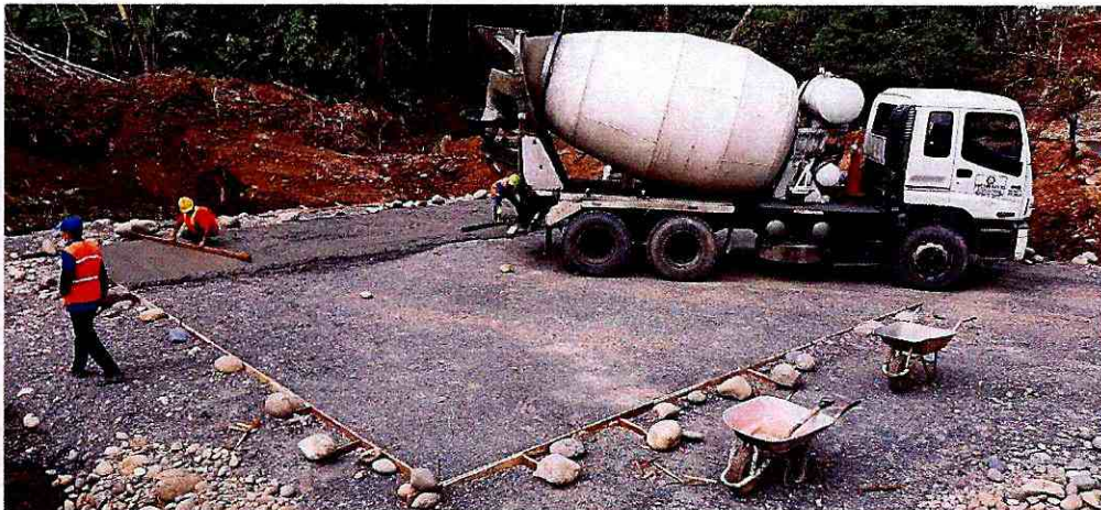
Fotografía 20: Fundido de replantillo
