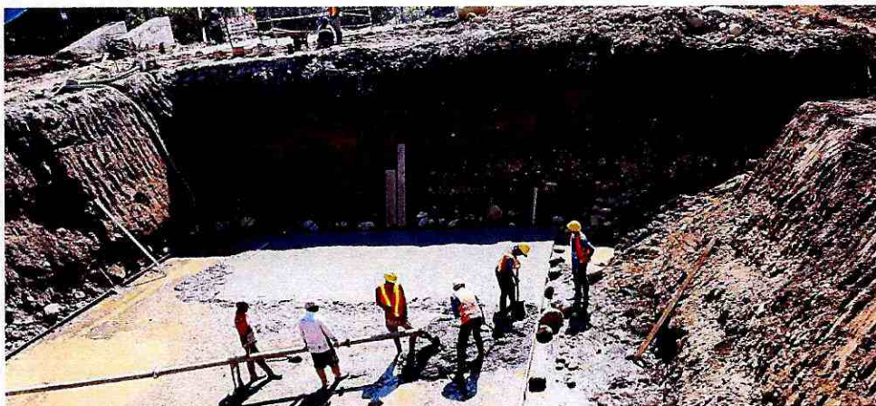
Fotografía 15: Fundido de replantillo
