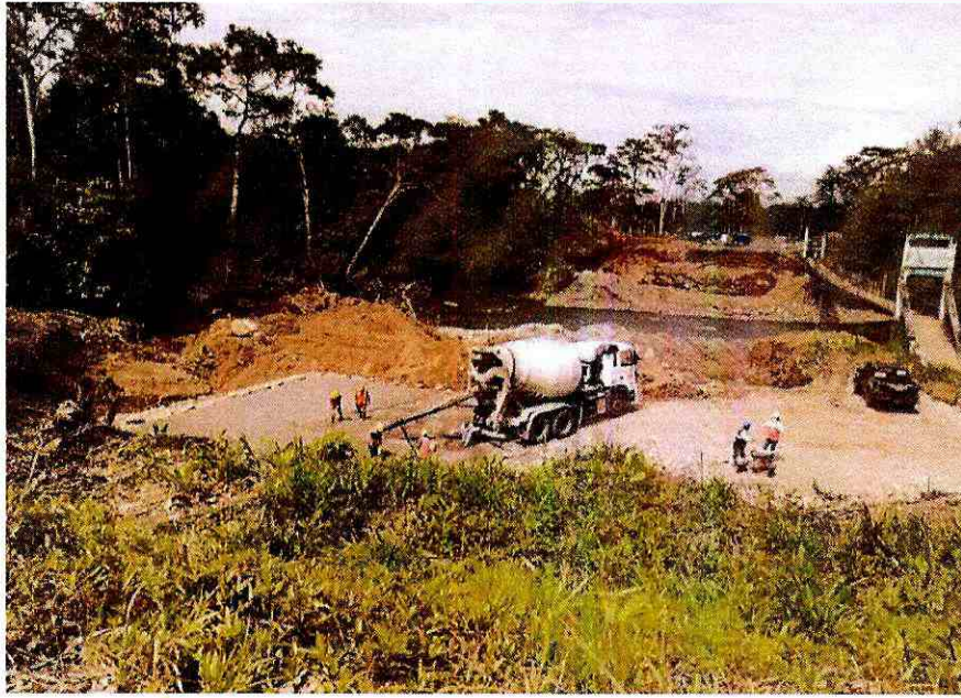
Fotografía 3. Fundido de replantillo de margen izquierdo
