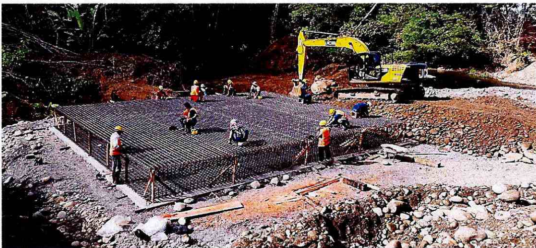
Fotografía 12: Armado de la parrilla superior de la zapata
