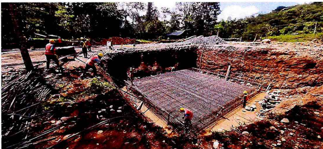
Fotografía 6: Armado de la parrilla superior de la zapata
