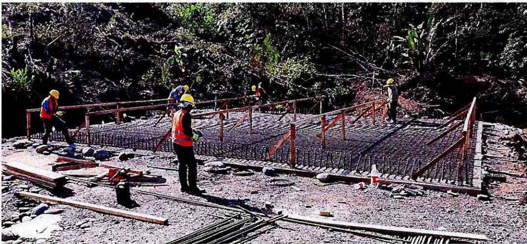
Fotografía 11: Armado de la parrilla inferior de la zapata
