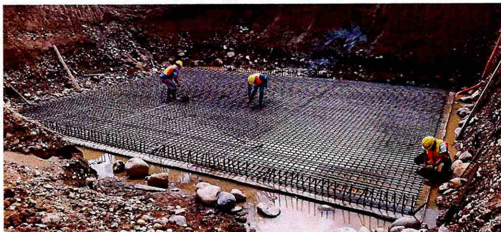
Fotografía 3: Armado de la parrilla inferior de la zapata
