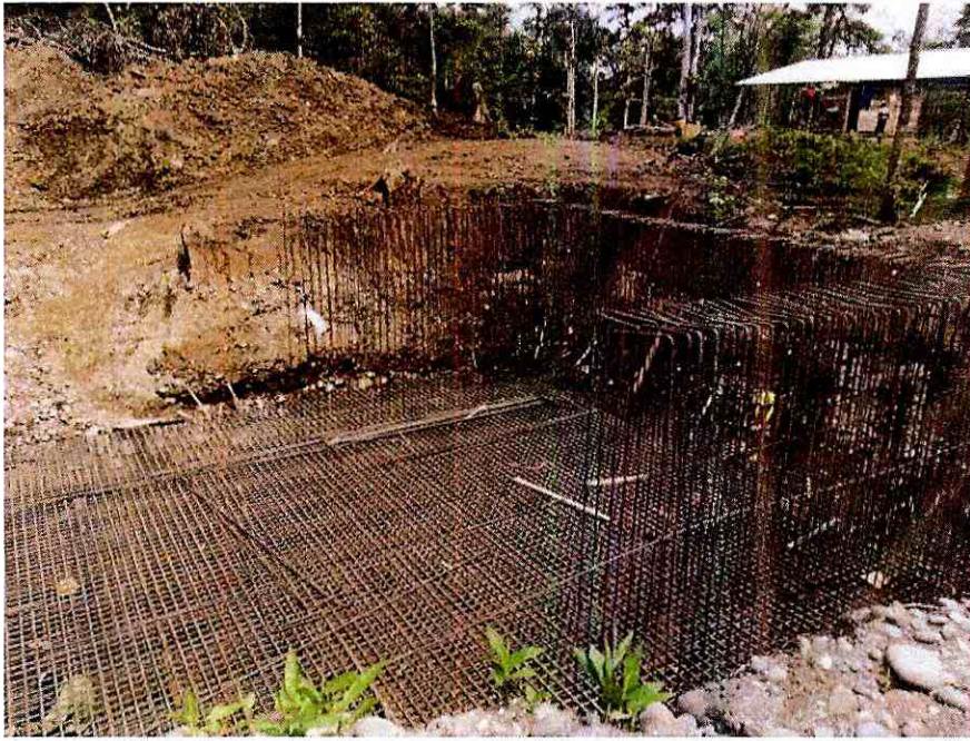
Fotografía 5. Armado de muros laterales y cimentaciones en anclaje derecho
