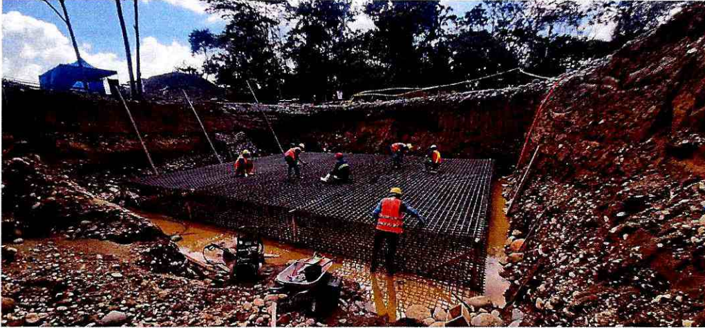
Fotografía 7: Armado de la parrilla superior de la zapata
