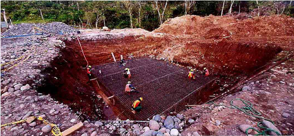
Fotografía 8: Armado de la parrilla superior de la zapata
