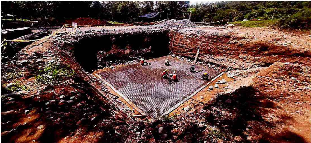
Fotografía 5: Armado de la parrilla inferior de la zapata
