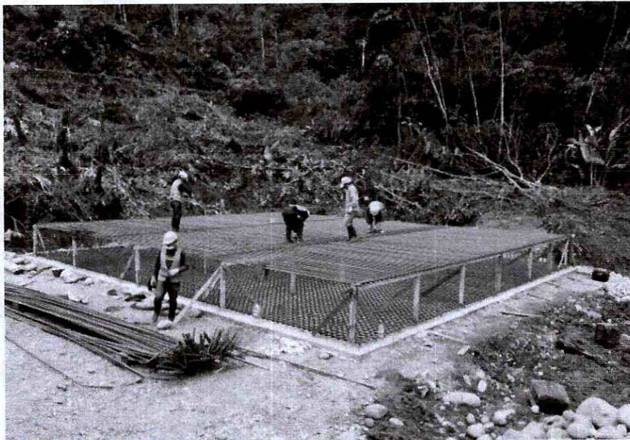
Fotografía 4. Armado de cimentación de anclaje – margen izquierdo
