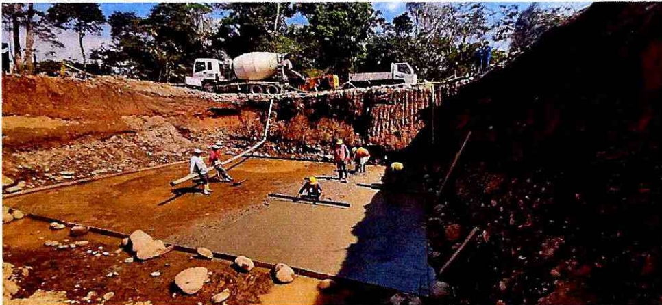
Fotografía 14: Fundido de replantillo
