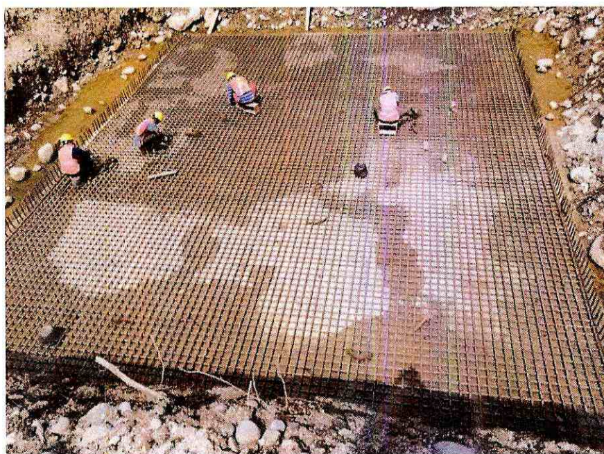
Fotografía 2. Replantillo margen derecho e inicio de armado de cimentación
