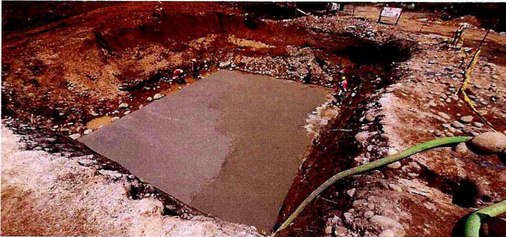
Fotografía 19: Fundido de replantillo
