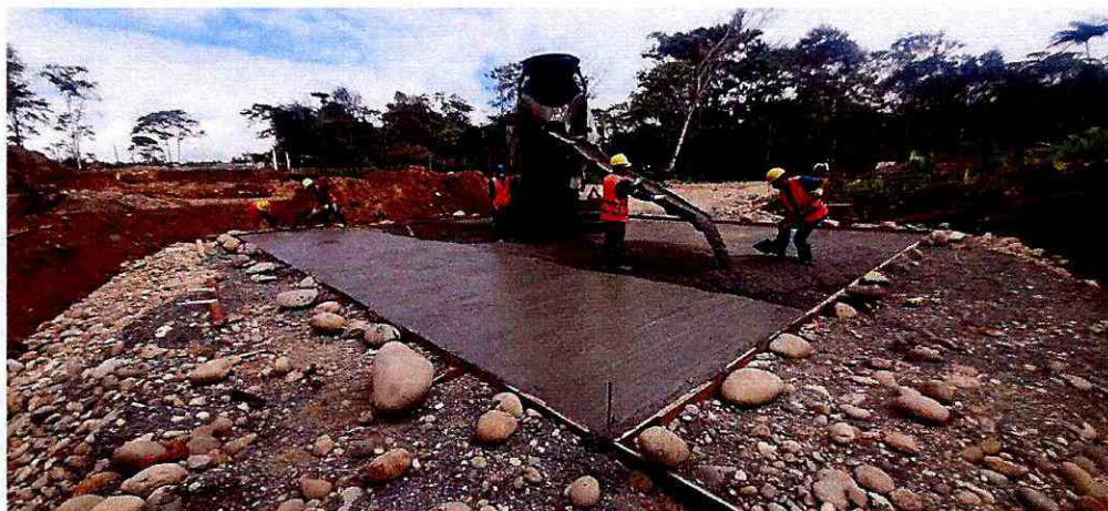
Fotografía 21: Fundido de replantillo
