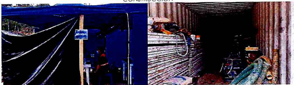
Fotografía 8. IMPLEMENTACIÓN DE BODEGA PARA ALMACENAMIENTO DE MATERIALES DE CONSTRUCCIÓN
