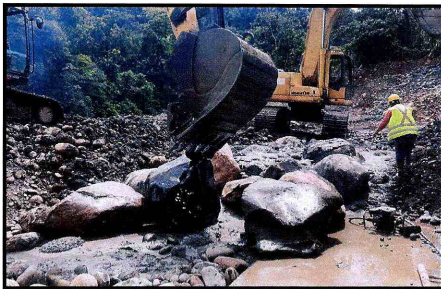
Fotografía 1. Enrocado margen derecho
