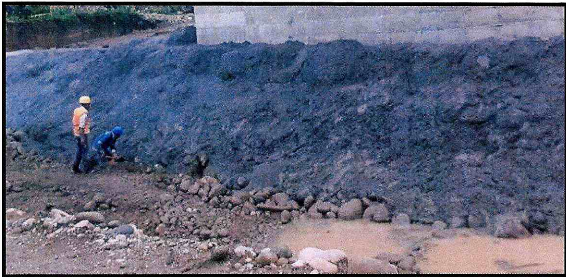
Fotografía 8. Enrocado – margen izquierdo
