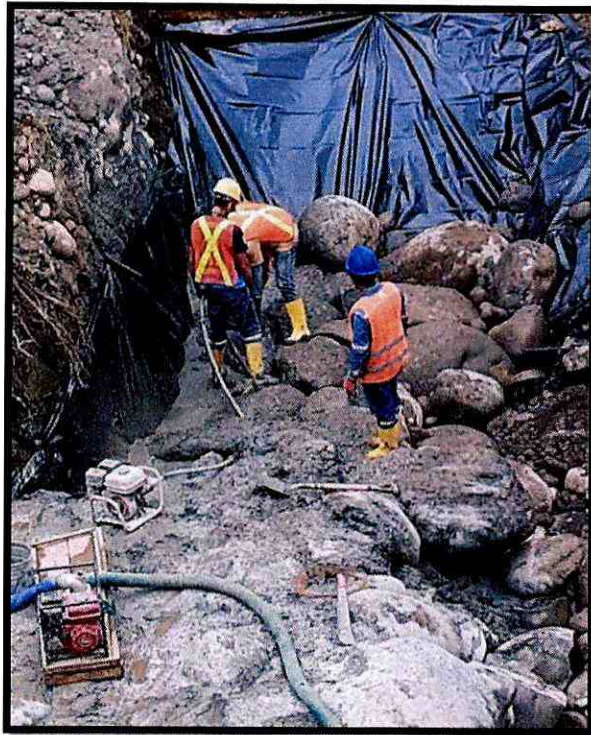
Fotografía 3. Geomembrana anclada y enrocado, margen derecho
