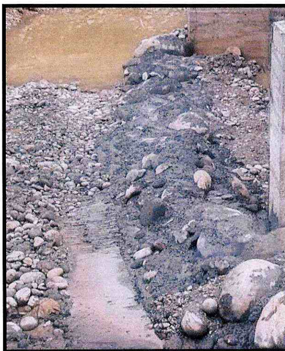
Fotografía 2. Enrocado posterior margen izquierdo
