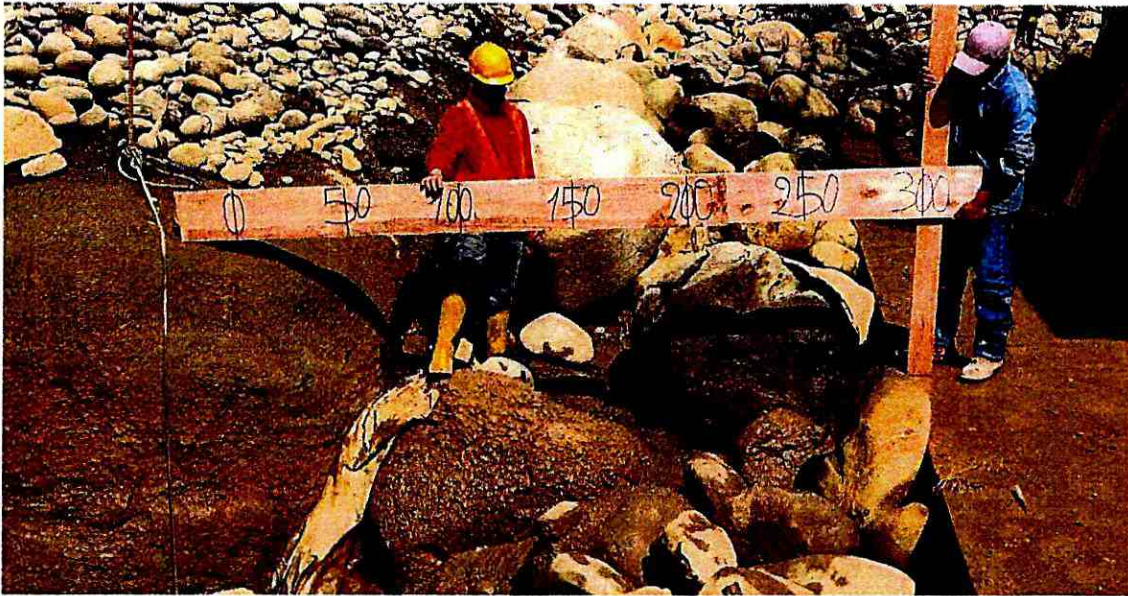
H. ESTRUCTURAL DE CEMENTO PORTLAND CLASE B F'c=240KG/CM2 (MUROS) MARGEN IZQUIERDO
