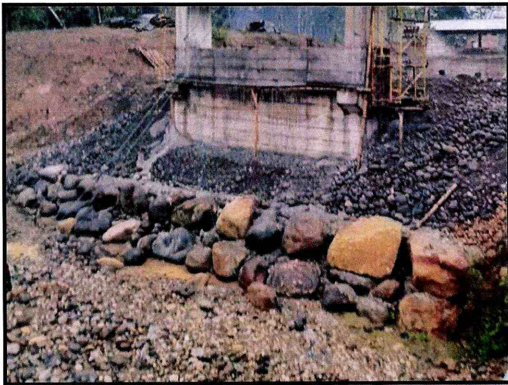
Fotografía 9. Enrocado – margen derecho
