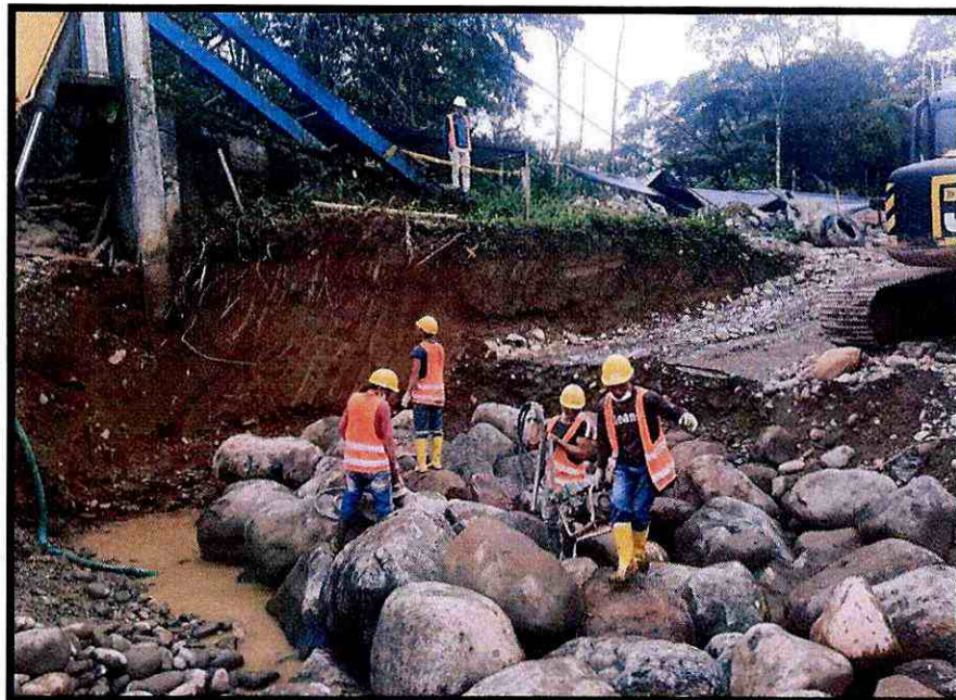
Fotografía 3. Enrocado, margen izquierdo
