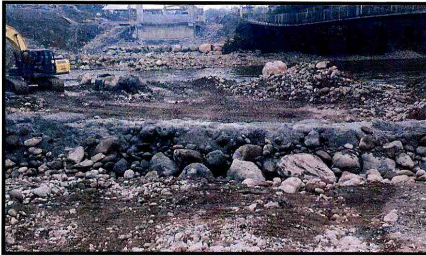
Fotografía 6. Hormigonado, margen izquierdo
