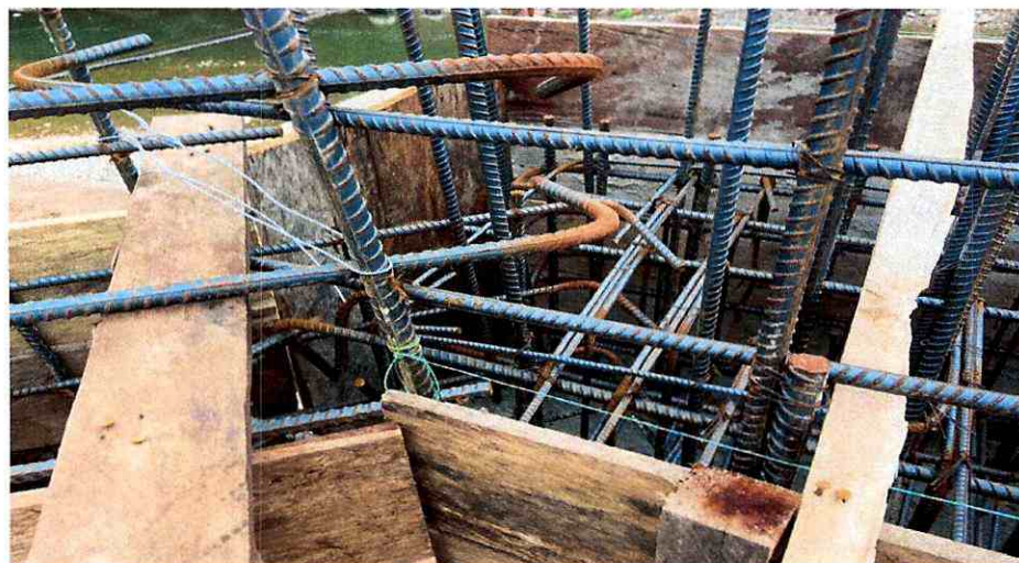
ARMADO ESTRUCTURAL DE VIGA SOPORTE SUPERIOR
