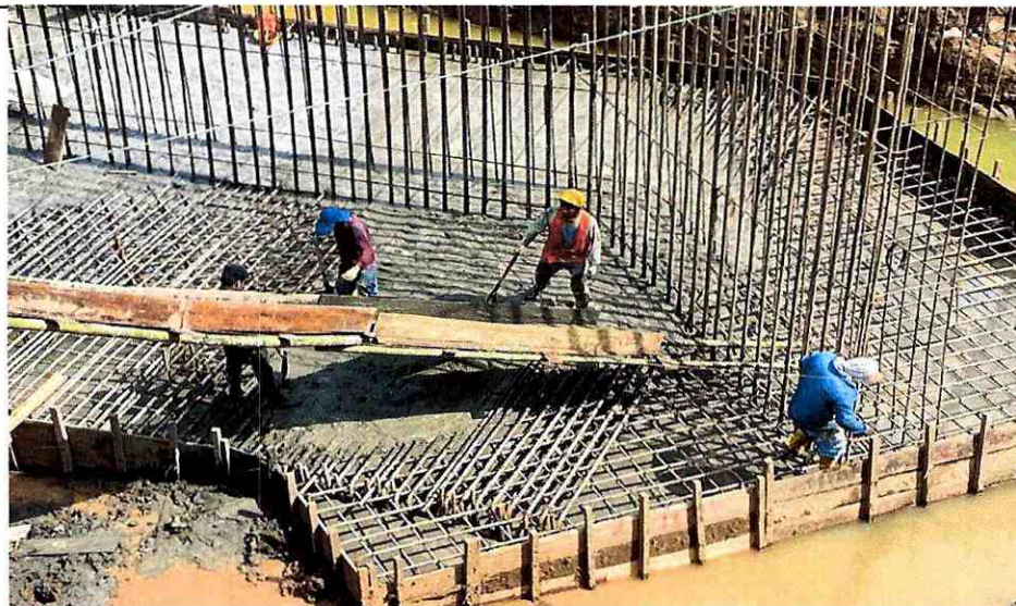
ARMADURA DE ACERO TRABA SISMICAS
