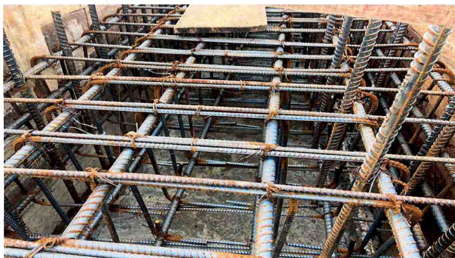
ARMADO ESTRUCTURAL DE VIGA SOPORTE SUPERIOR
