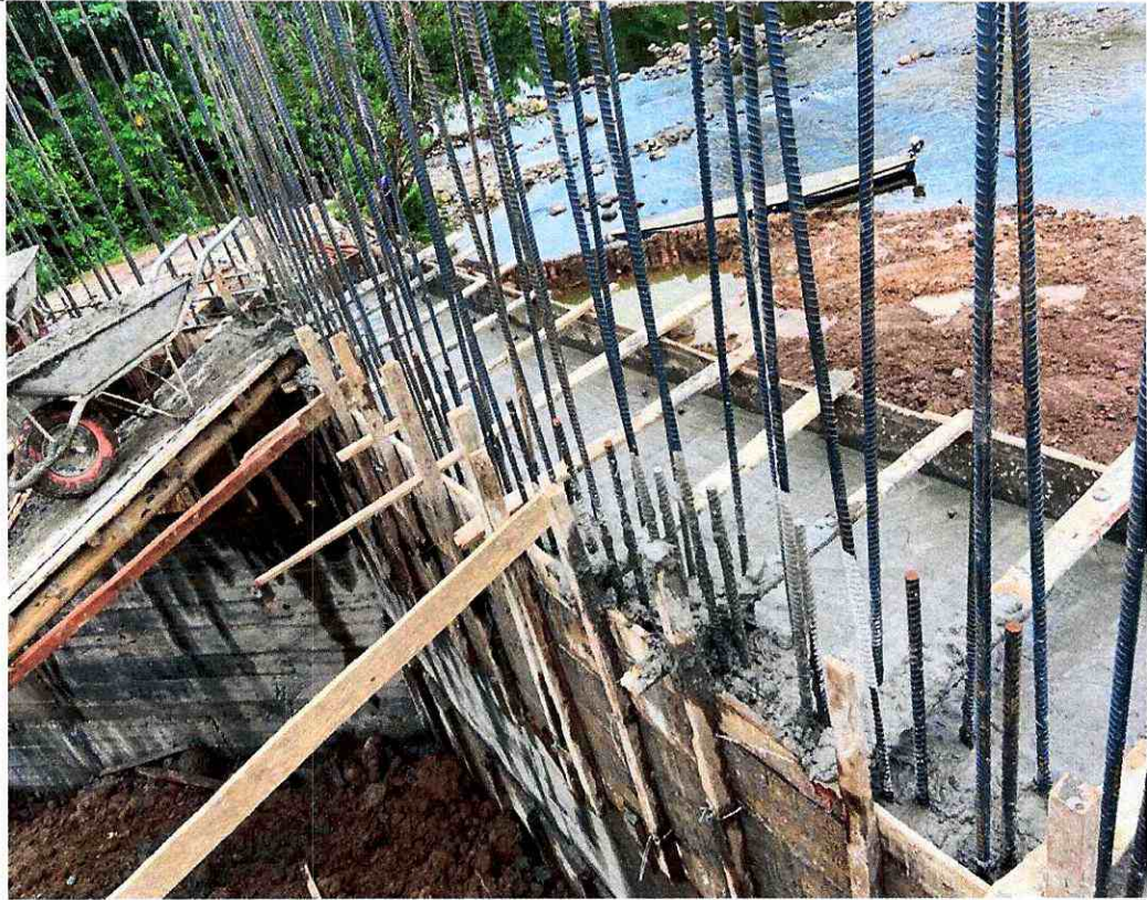
ENCOFRADOS TRAMOS DE ESTRIBOS Y ALAS
