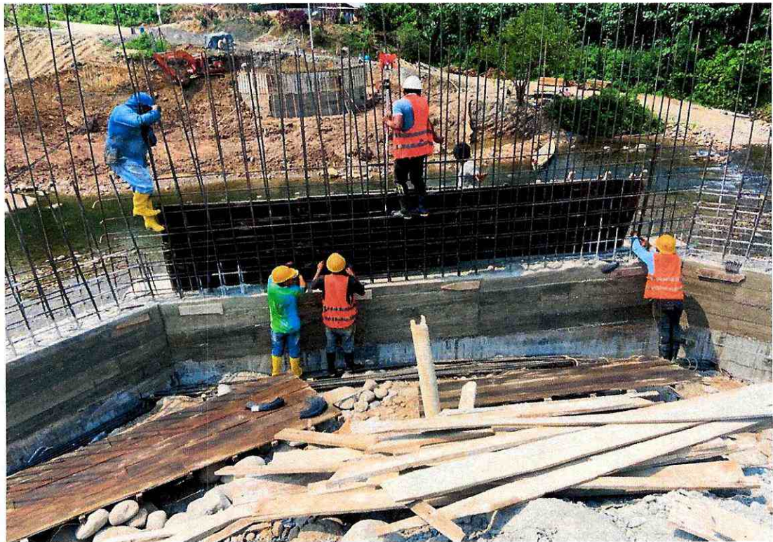
ENCOFRADOS TRAMOS DE ESTRIBOS Y ALAS
