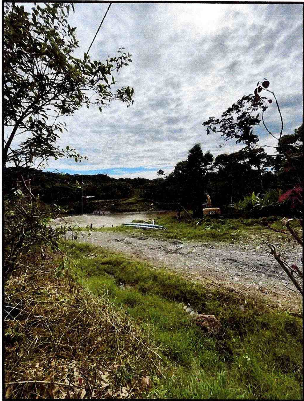
Desbroce en el Área del proyecto
