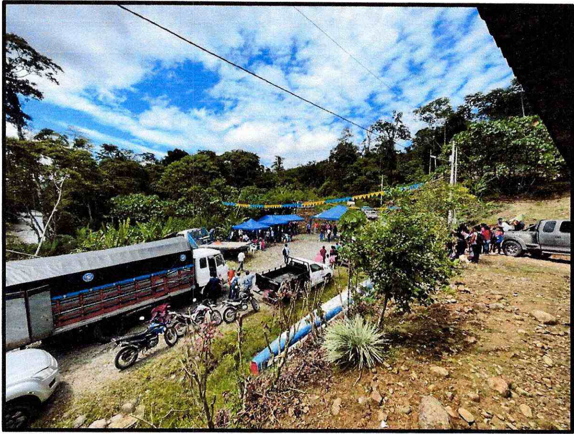
Socialización y colocación de la primera piedra
