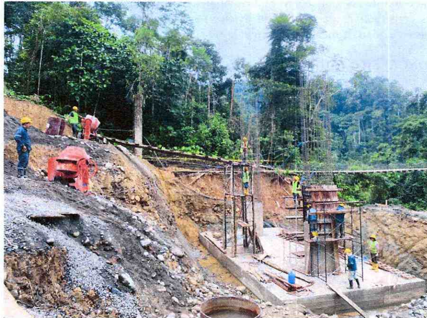
IMAGEN 2. Construcción de la Primera Torre del Puente
