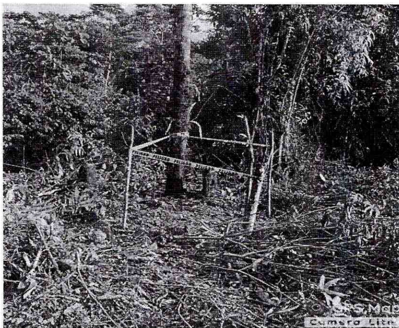
Habilitación de SS.HH
