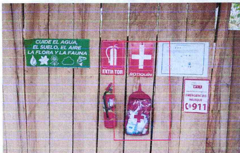
Anexo 20.- Botiquín de primeros auxilios al alcance de los trabajadores
