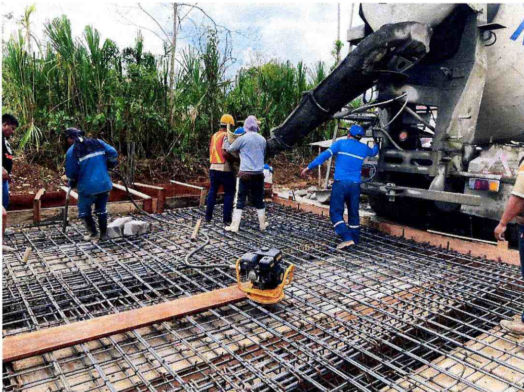
Anexo 14. Mixer en obra
