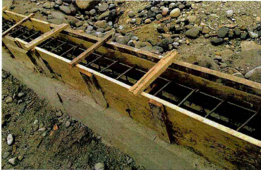
Encofrado de columnas
