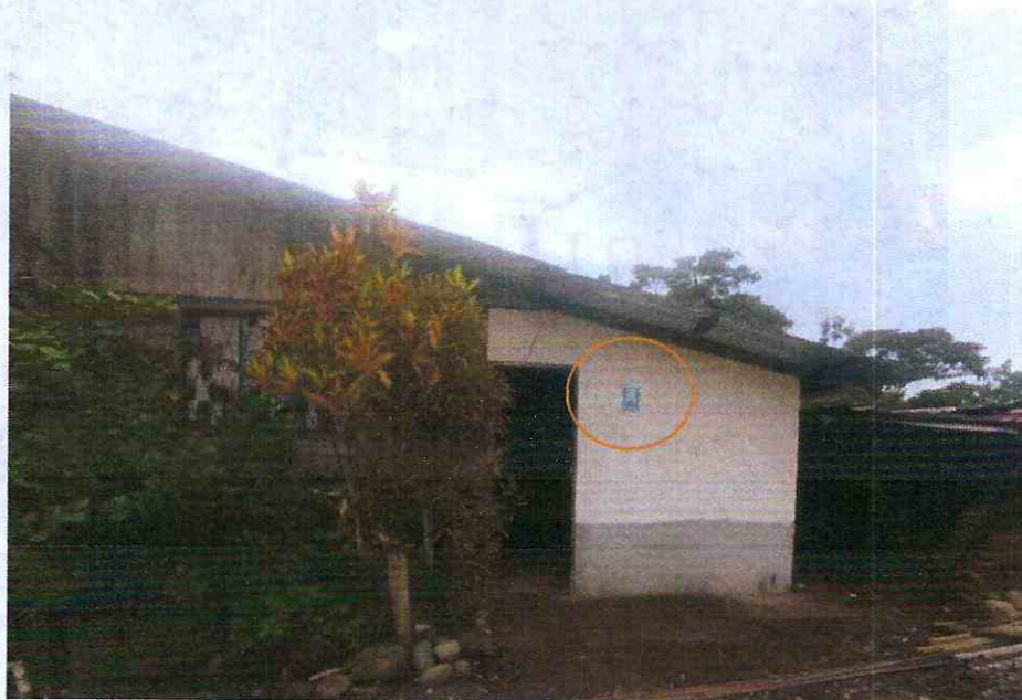
5.5.- Área de bodega
