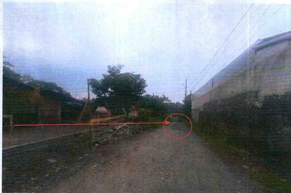
Anexo 6.- Aguas servidas conectadas al sistema de alcantarillado de la parroquia Tarquí
