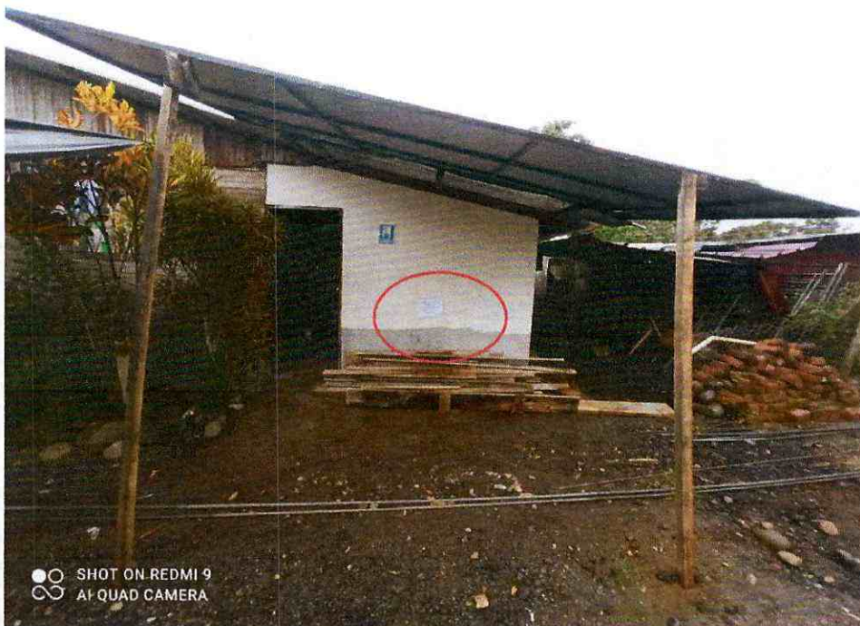
Anexo 13.- Almacenamiento temporal de residuos para su reutilización
