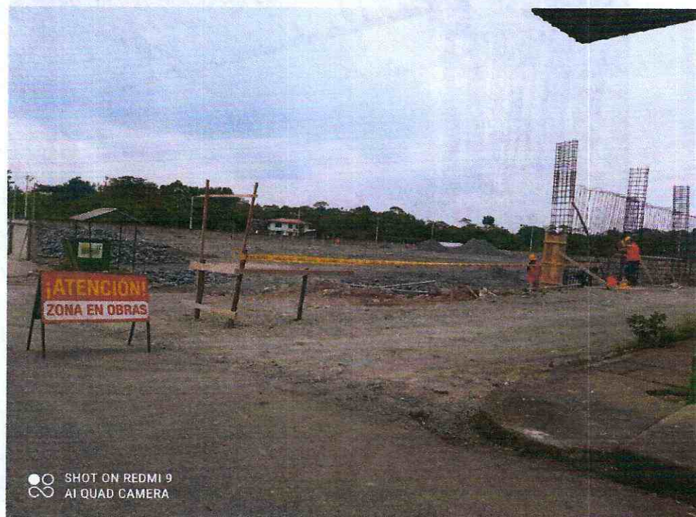
Anexo 10.- Uso del EPP con la debida señalética para precautelar su seguridad.
