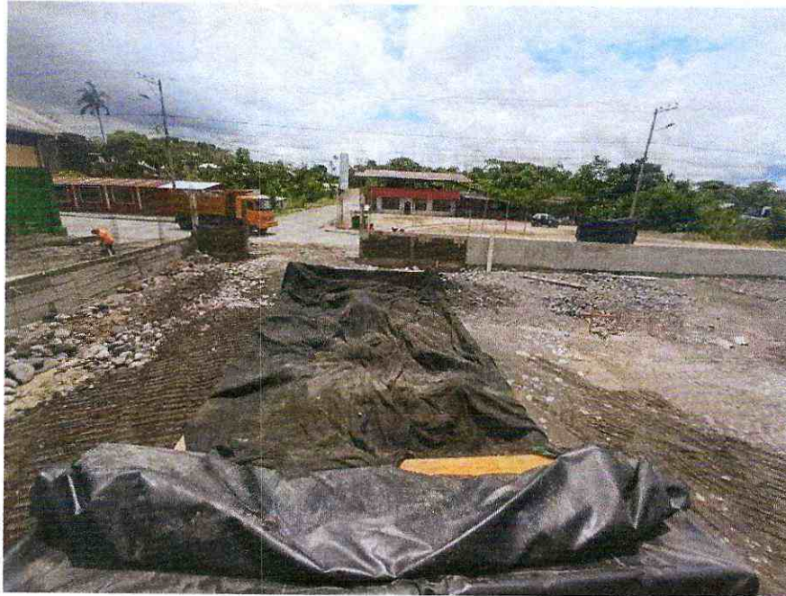
Anexo 12.- Lona sobre la volqueta transportando material pétreo
