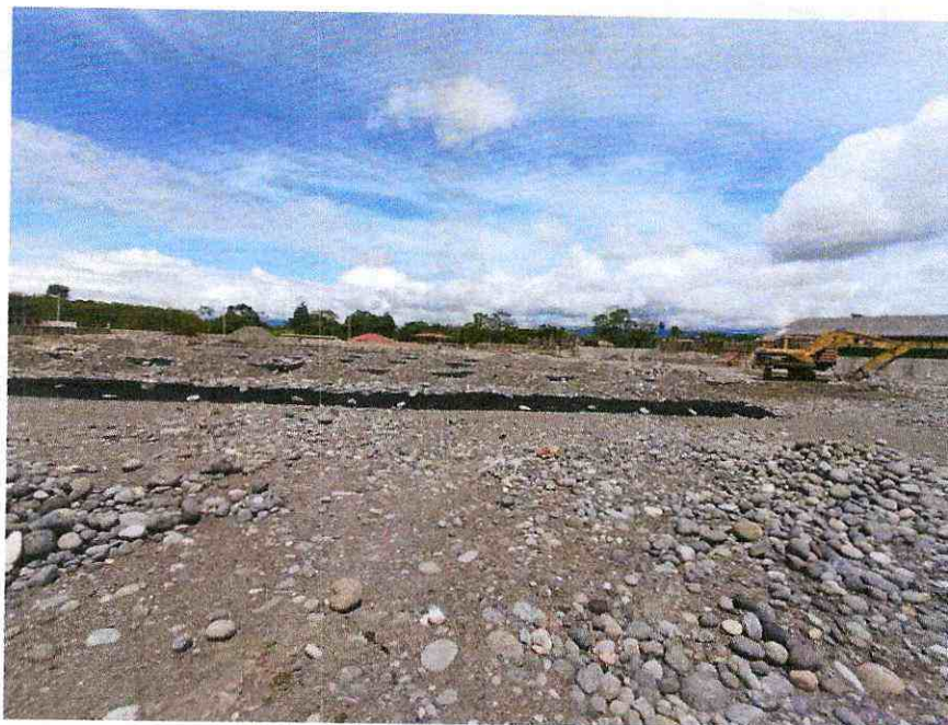
Anexo 20.- Área despejada para la movilización de la maquinaria.
