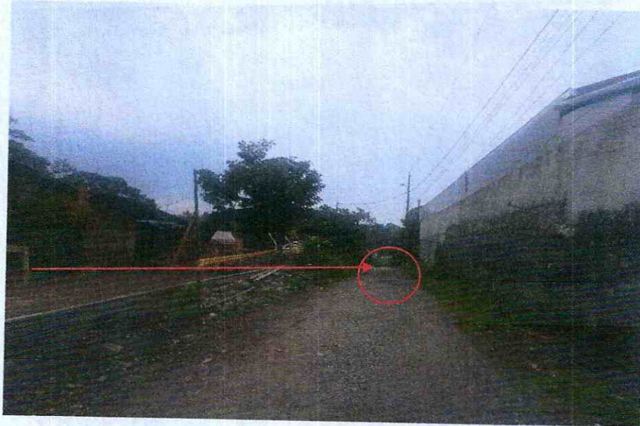
Anexo 6.- Aguas servidas conectadas al sistema de alcantarillado de la parroquia Tarqui
