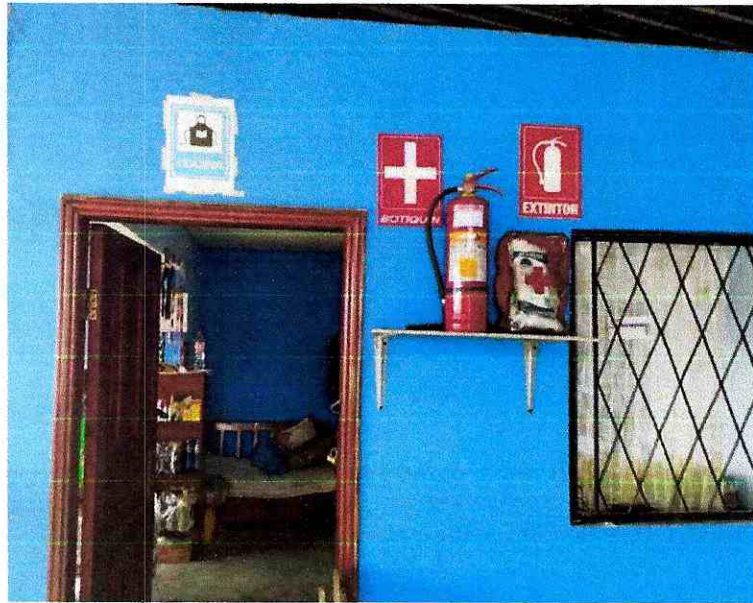
Anexo 7.- Extintor y botiquín al alcance de los trabajadores
