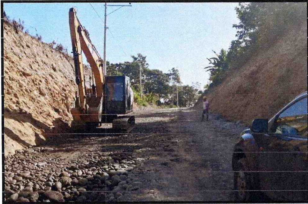
Rubro 04. Limpieza de derrumbes.
