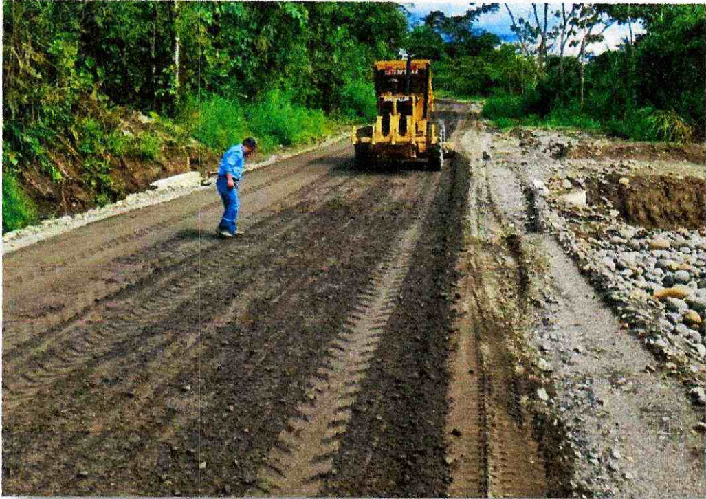
Rubro 8—Material de base granular de agregados (minada, cargada, regada)
