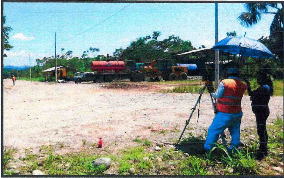
Rubro 01. Replanteo y nivelación a nivel de asfalto
