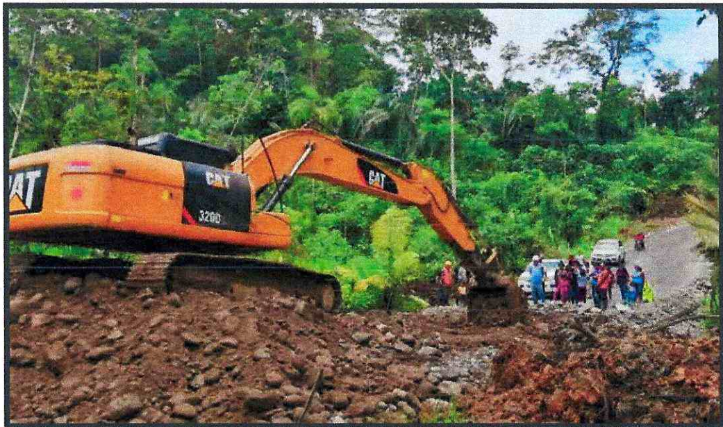
Rubro 02. Excavación sin clasificar (Mov. De Tierra).
