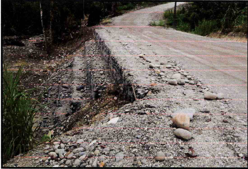
Rubro 01. Muro de Gaviones Calibre N°12.
