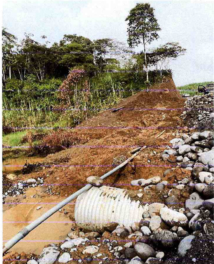
COLOCACION DE ALCANTARILLAS
