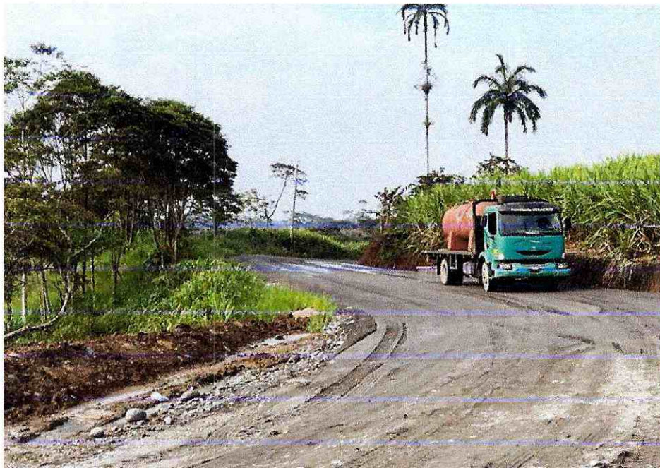
TENDIDO DE BASE Y SUB BASE
