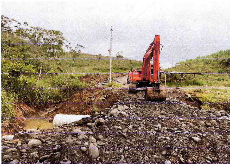
EXCAVACION Y RELLENO DE ESTRUCTURAS MENORES
