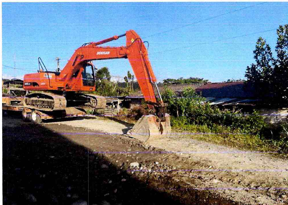
INGRESO DE MAQUINARIA AL SITIO
