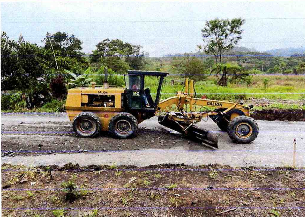
TENDIDO DE BASE Y SUB BASE
