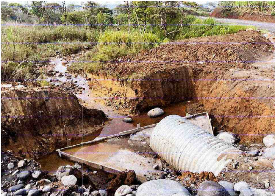
ARMADO Y HORMIGONADO DE CABEZALES Y REPLANTILLOS
