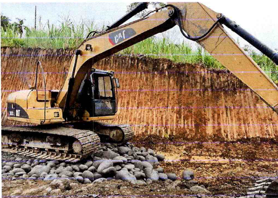
MATERIAL DE MEJORAMIENTO
