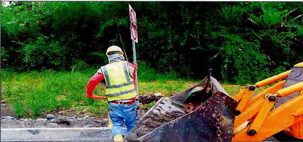
Colocación de Señalética Vertical Reglamentaria
