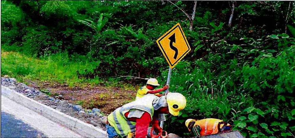
Colocación de Señalética Vertical Preventiva
