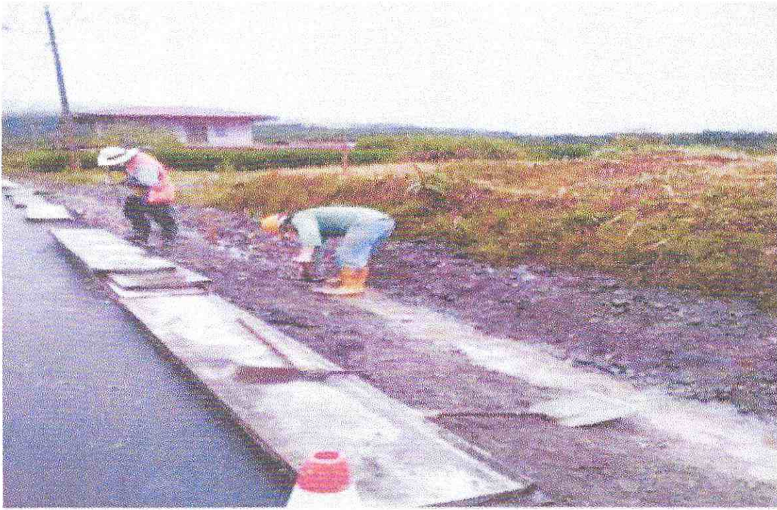
13. CUNETAS LATERALES PARA ESCORRENTÍAS DE AGUA LLUVIA.
