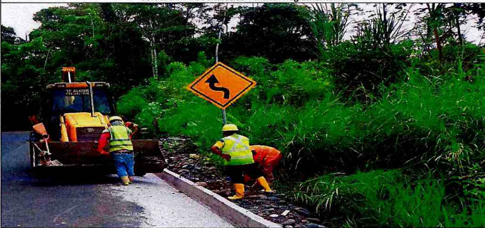
Colocación de Señalética Vertical Preventiva
