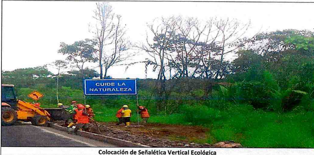
Colocación de Señalética Vertical Ecológica
