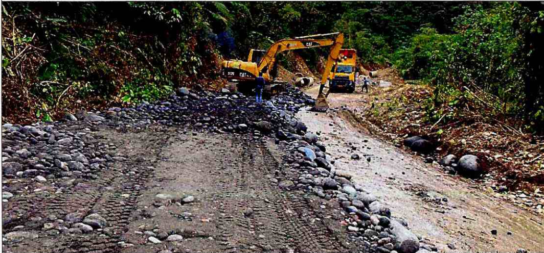
Transporte de material pétreo de mejoramiento
