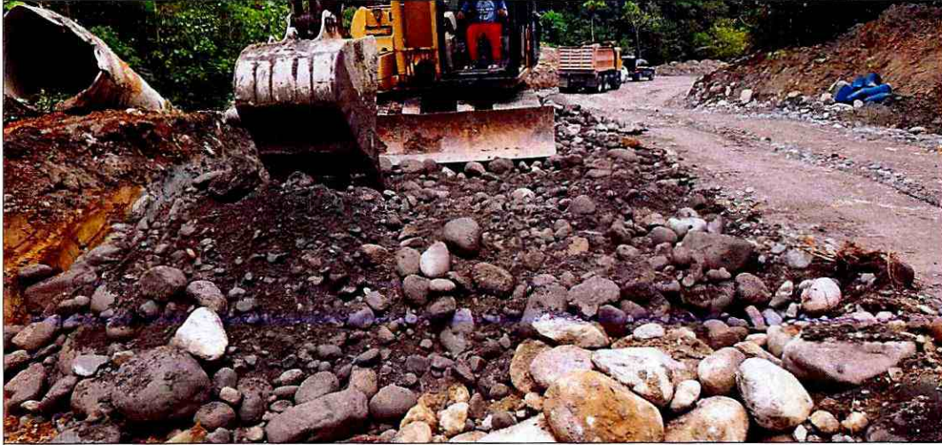
Relleno con material pétreo de mejoramiento
