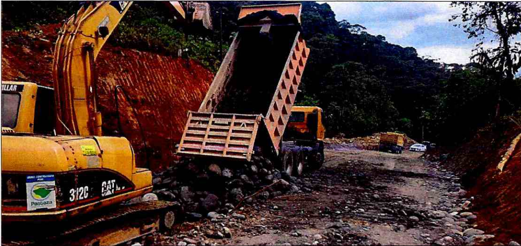
Transporte de material pétreo de mejoramiento
