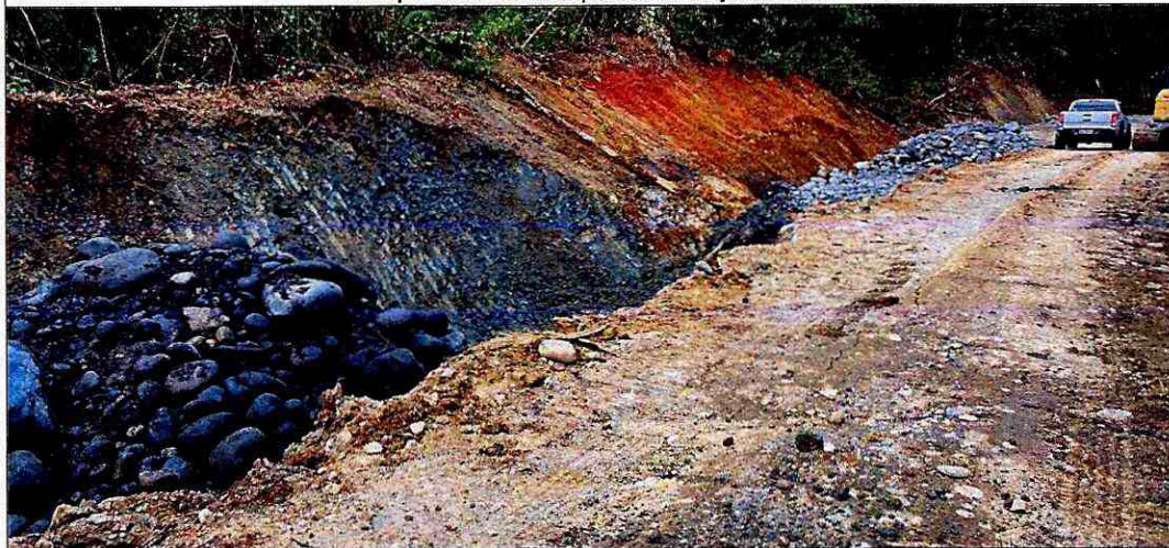
Relleno con material pétreo de mejoramiento
