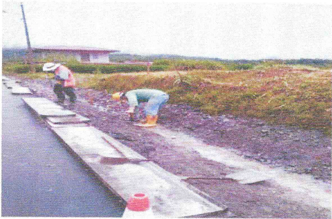
13. CUNETAS LATERALES PARA ESCORRENTÍAS DE AGUA LLUVIA.
