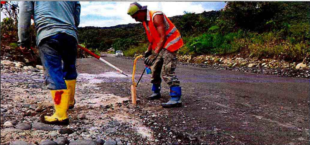
Nivelación y replanteo a nivel de base
