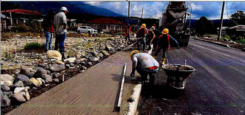
Vertido de hormigón en aceras
