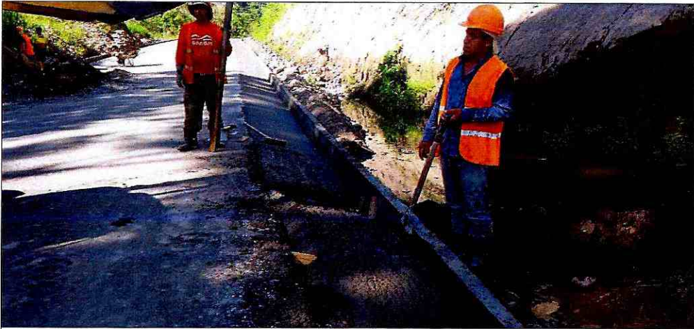
Hormigonado de cunetas
