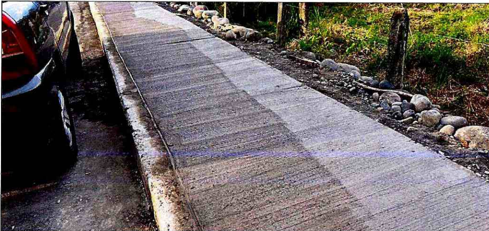
Escobillado en aceras
