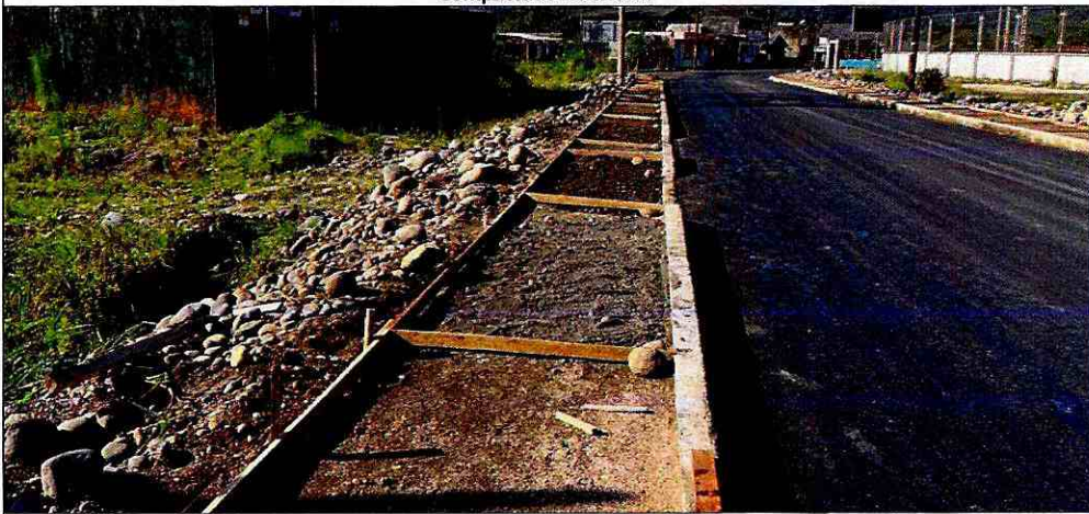
Encofrado de aceras
