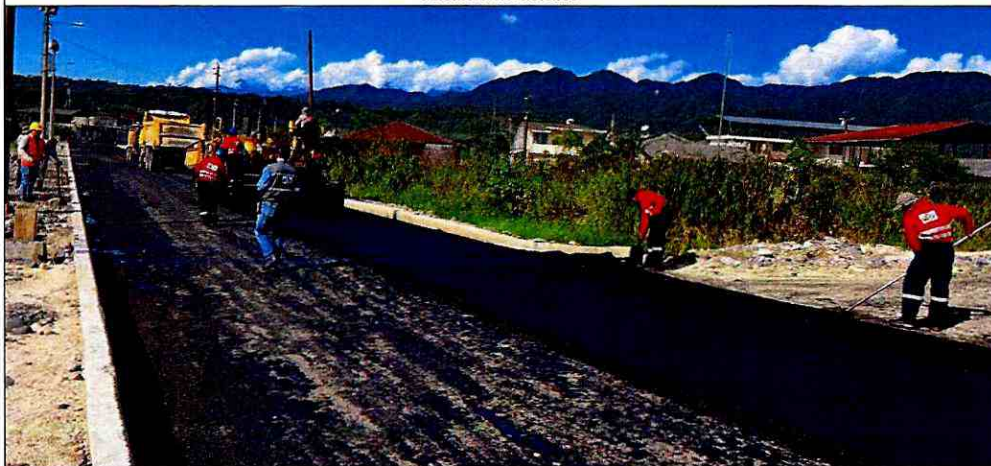
Colocación de carpeta asfáltica
