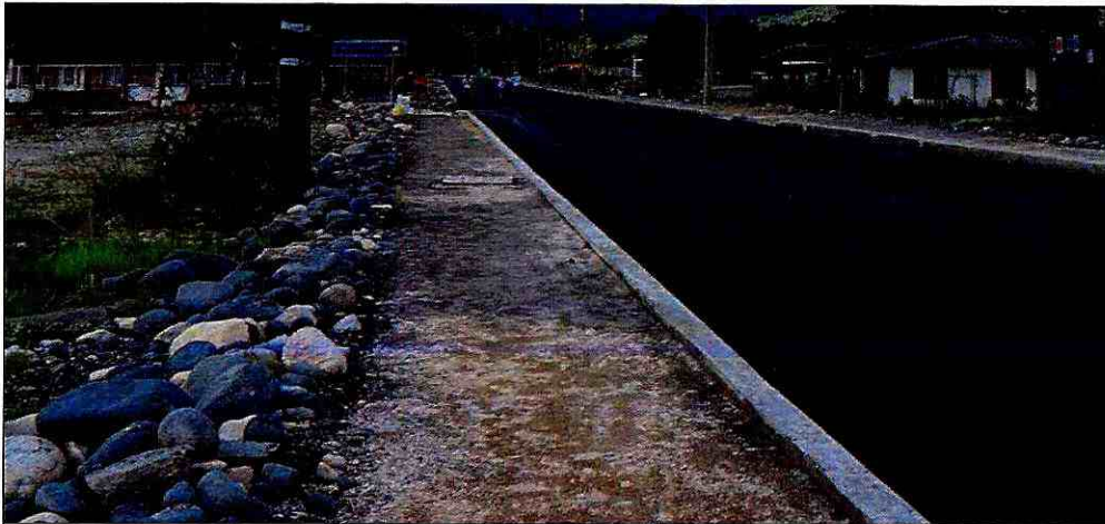
Nivelación de aceras
