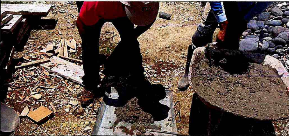
Verificación de asentamiento con Cono de Abrams
