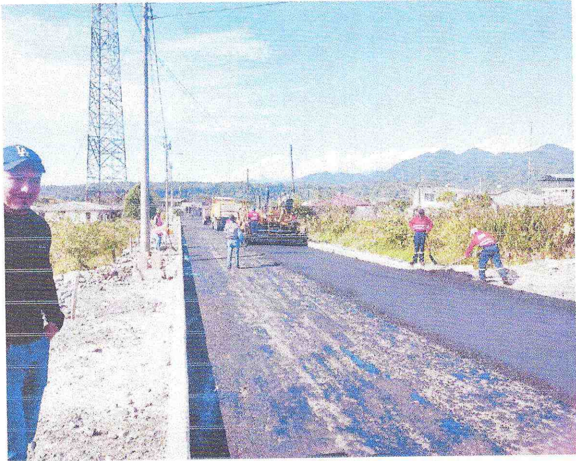
13. ASFALTO RC-250, PARA IMPRIMACIÓN.
