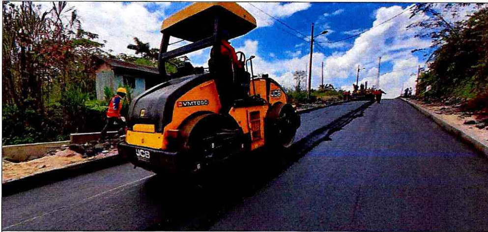
Compactado de asfalto
