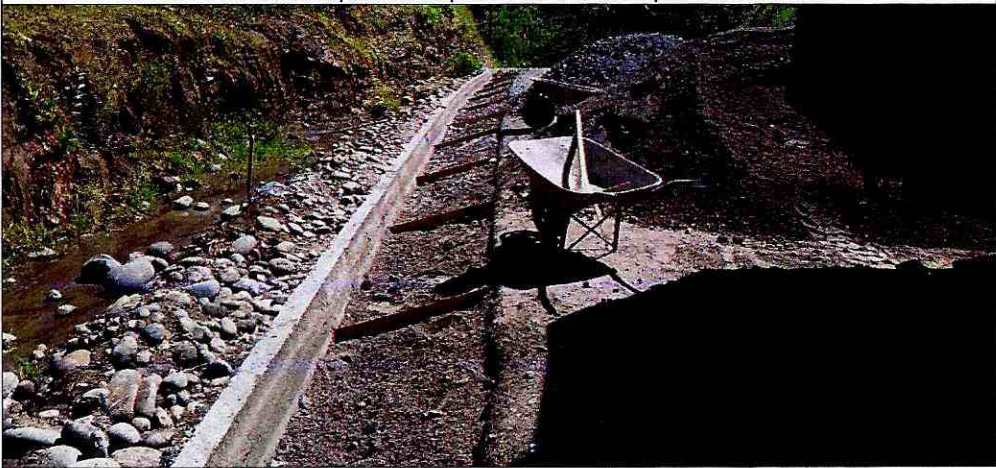
Encofrado para cunetas
