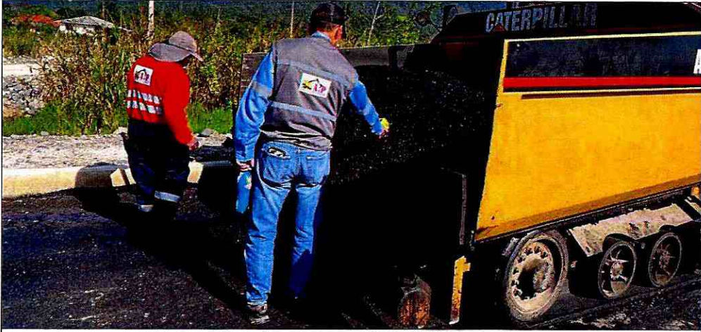
Toma de temperatura en tolva de finisher
