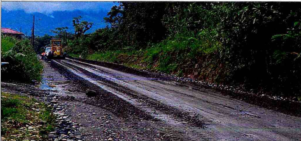
Tendido de base
