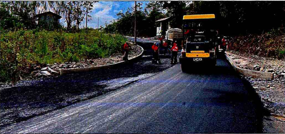
Tendido de asfalto
