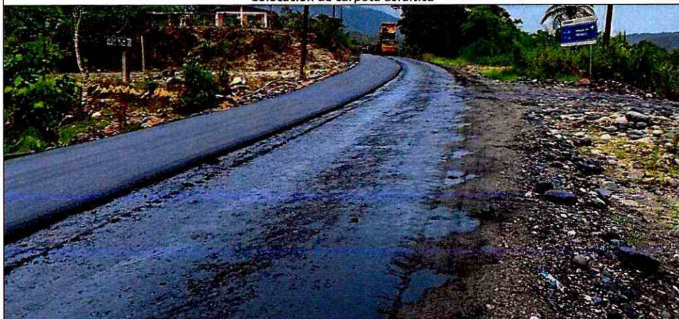
Colocación de carpeta asfáltica
