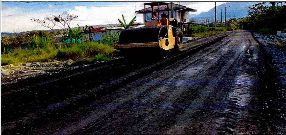
Compactado de base
