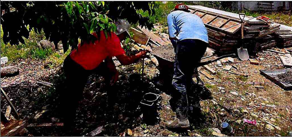
Toma de muestras de hormigón para ensayo de compresión
