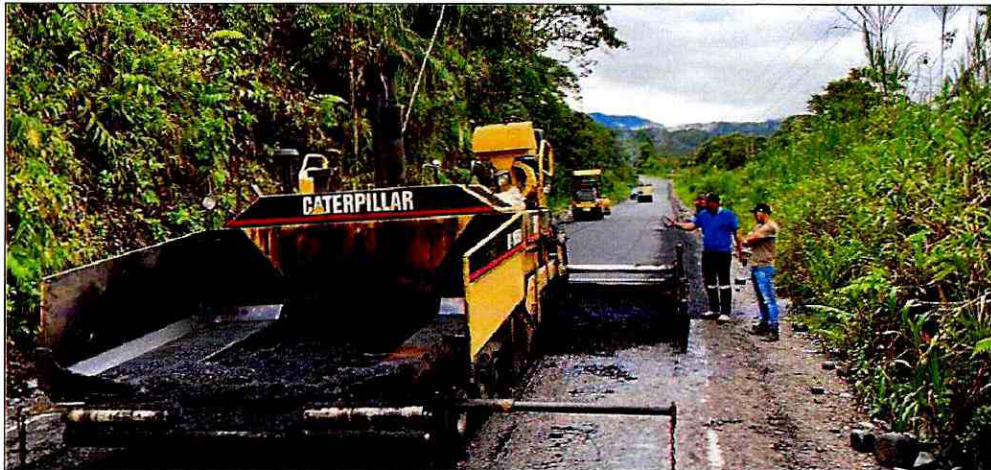
Tendido de asfalto
