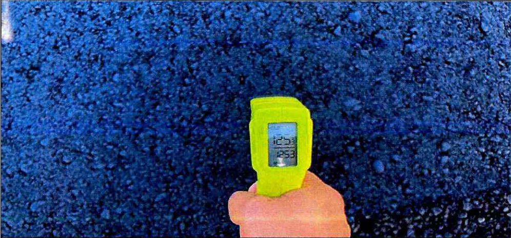
Toma de temperatura después del tendido de carpeta asfáltica
