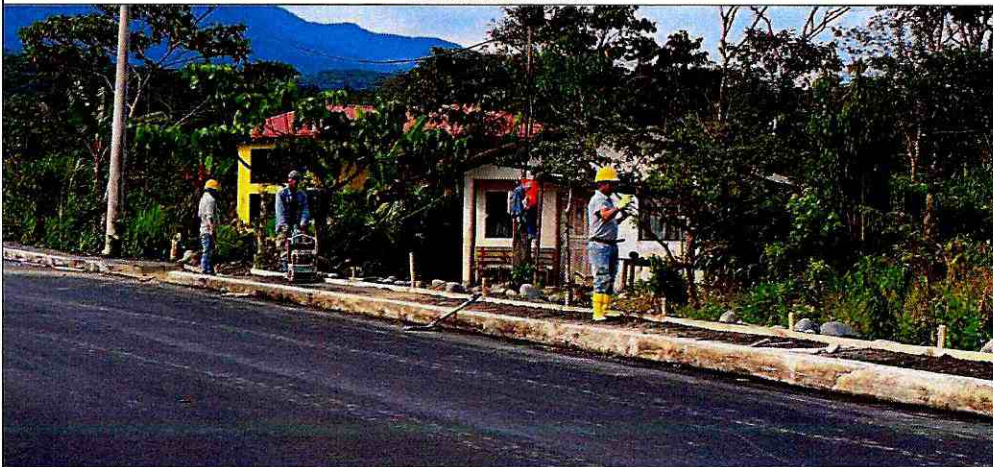
Compactado de aceras
