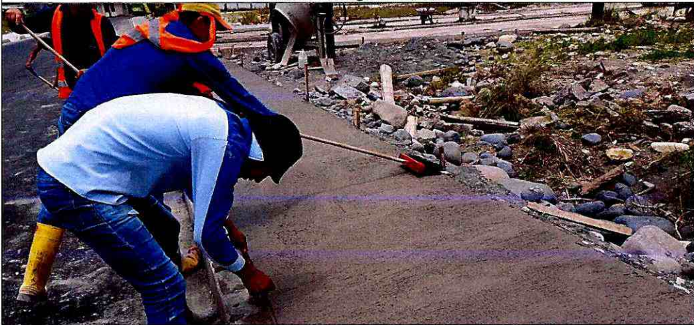
Escobillado en aceras
