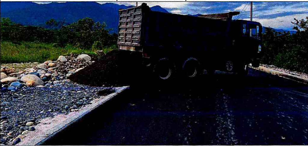
Nivelación de aceras
