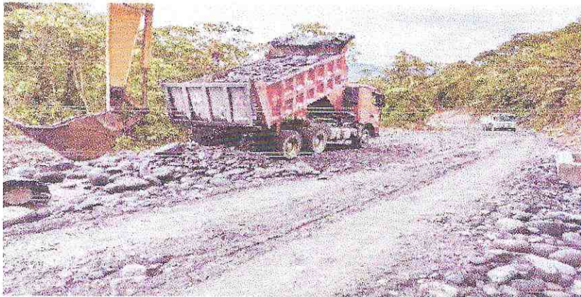
Anexo1. Señalización en el area de trabajo.
