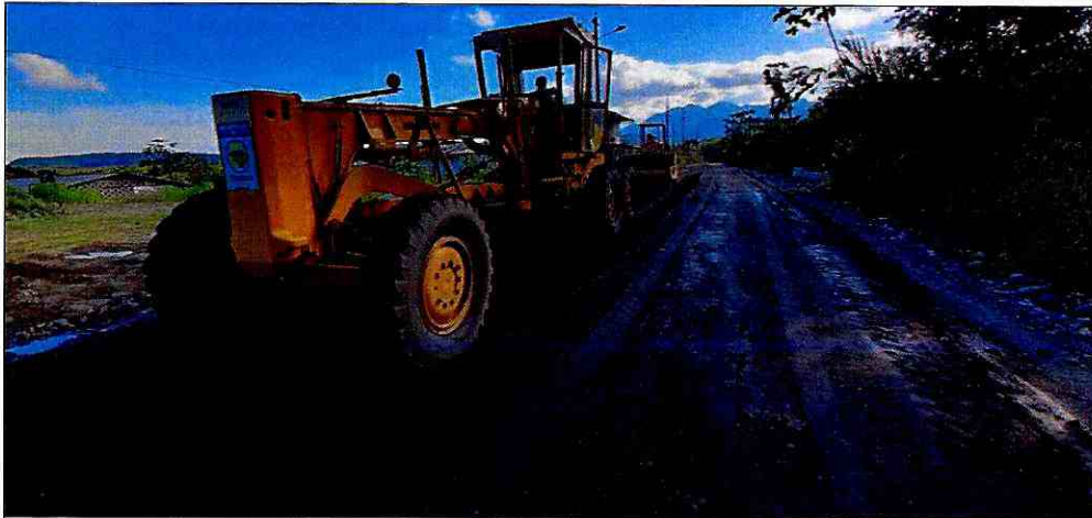
Tendido de base
