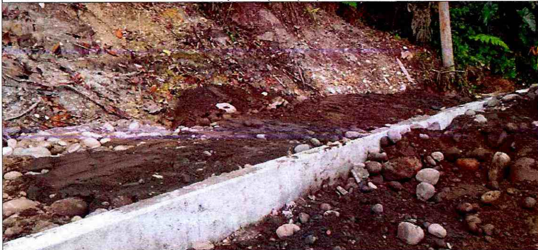
Relleno compactado por capas para aceras
