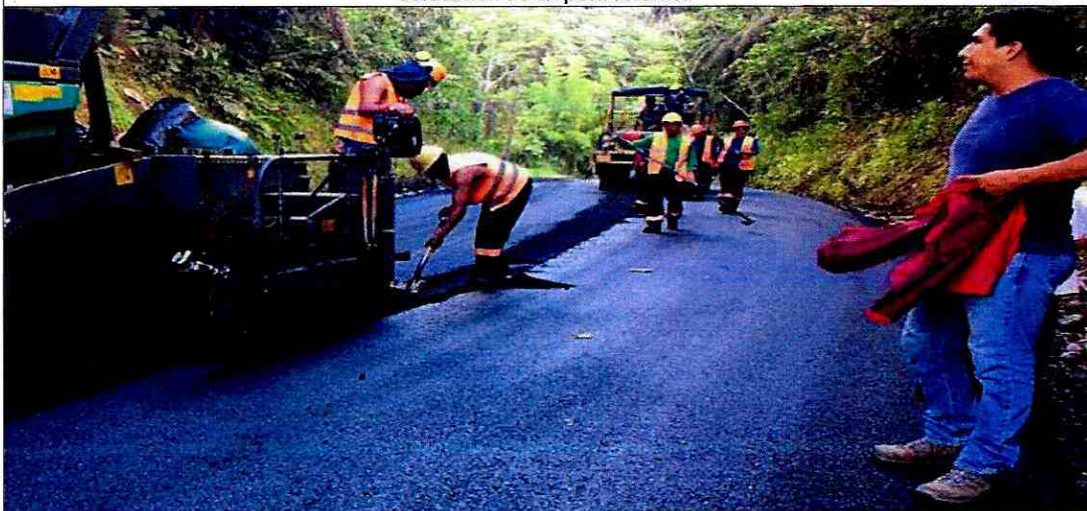
Colocación de carpeta asfáltica
