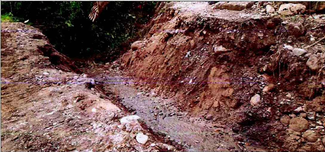
Excavación para colocación de tubería metálica
