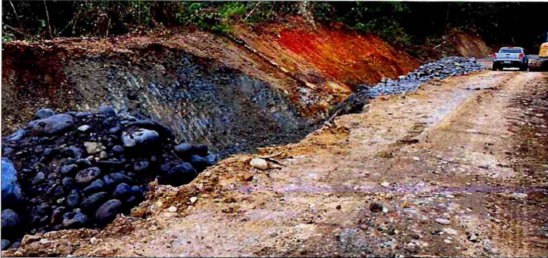
Relleno con material pétreo de mejoramiento
