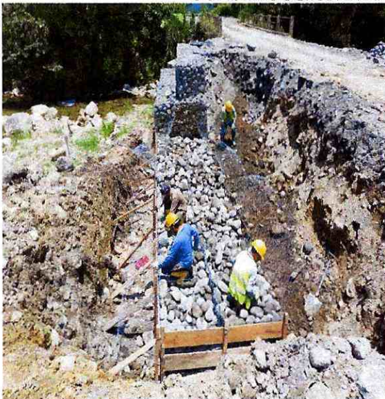
CONSTRUCCION DE MUROS DE GAVIONES
