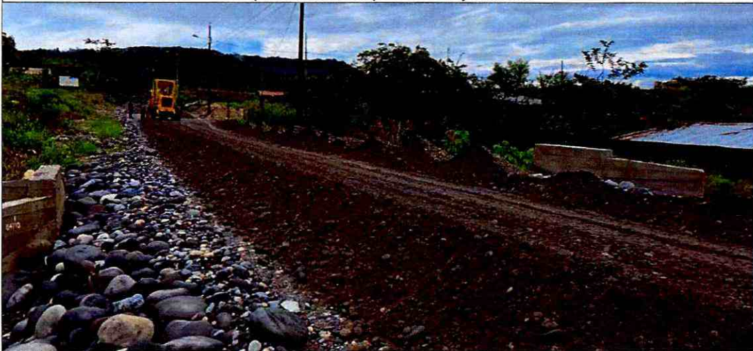
Tendido y Regado de sub base
