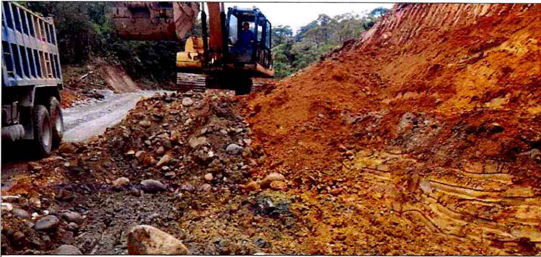
Excavación y desalojo
