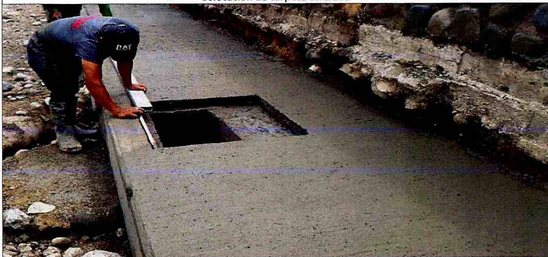
Hormigonado de aceras
