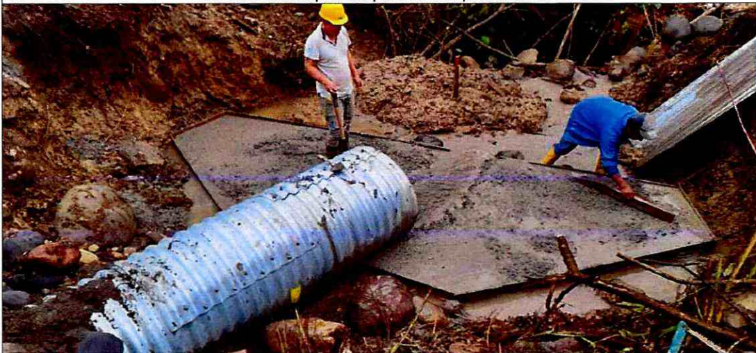
Hormigonado de replantillo para muros tipo Cabezal
