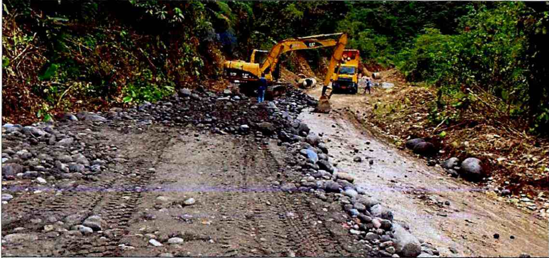
Transporte de material pétreo de mejoramiento
