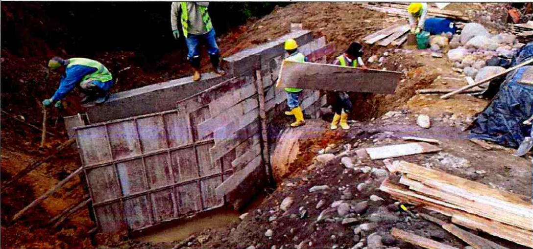
Desencofrado de muro tipo Cabezal
