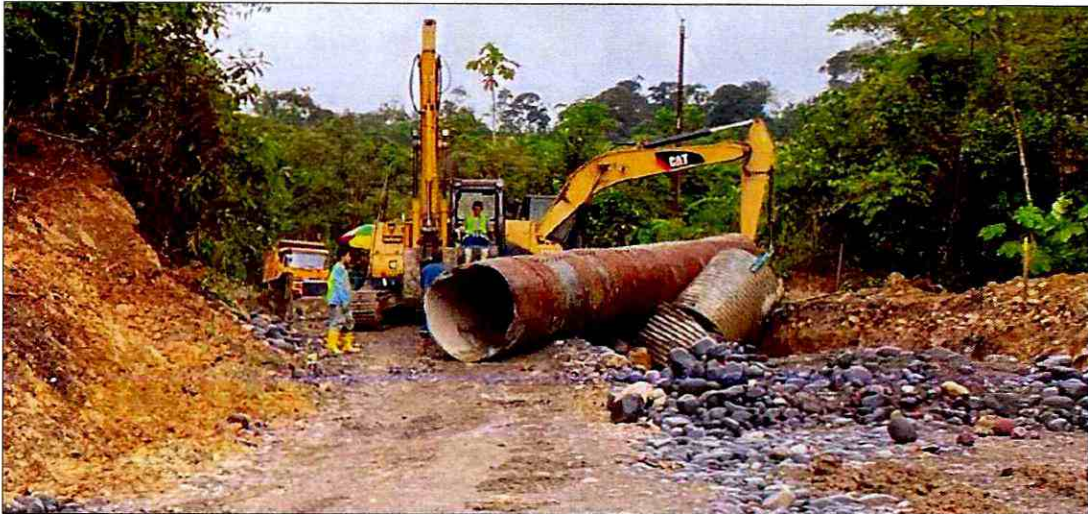
Remoción de alcantarillas
