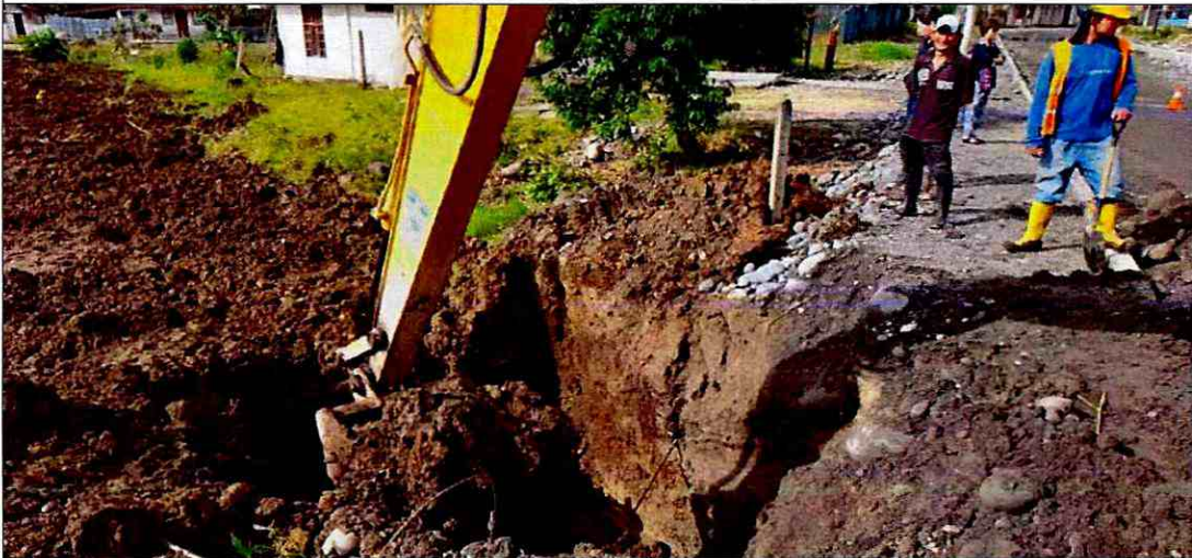
Relleno con material de desalojo en tubería P.V.C D=700
