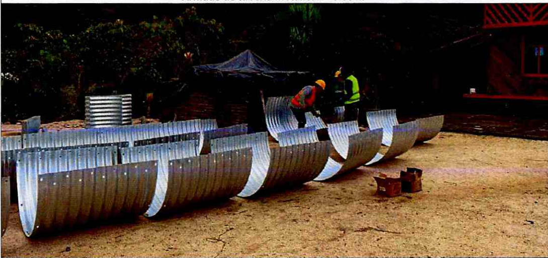
Armado de tubería metálica D=2.20 m
