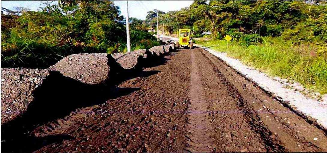
Tendido de Base
