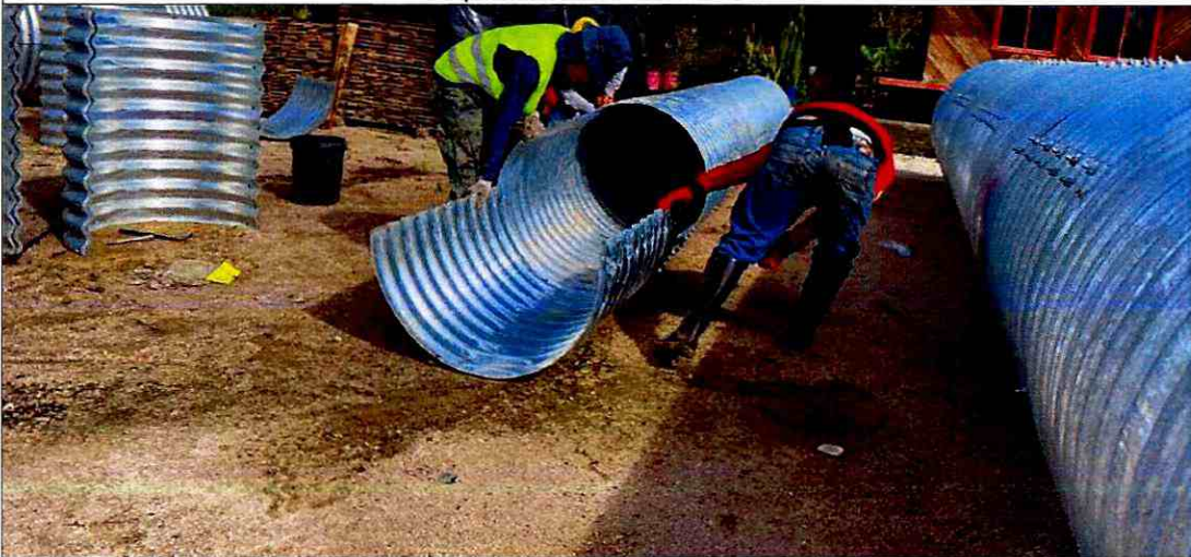
Armado de tubería metálica D=0.80 m
