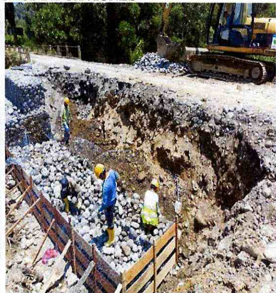
CONSTRUCCION DE MUROS DE GAVIONES
