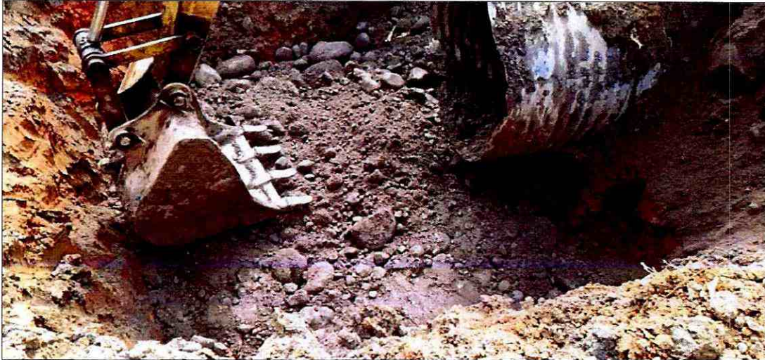
Relleno de estructuras menores.
