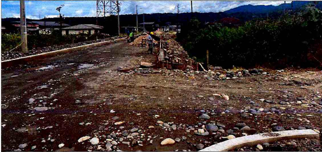
Encofrado y hormigonado de bordillos
