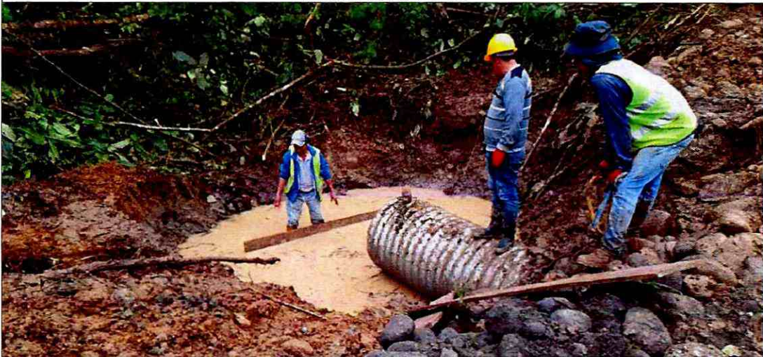
Encofrado de replantillo para muros tipo cabezales
