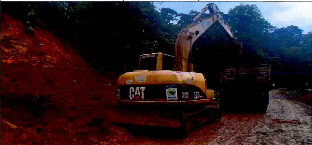
Transporte de material de desalojo
