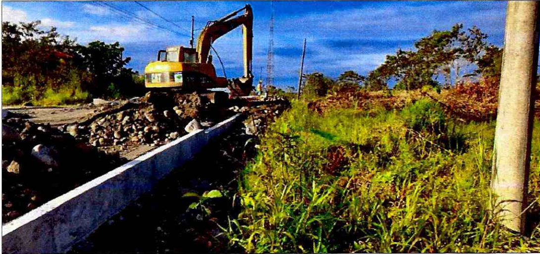
Relleno compactado por capas para aceras
