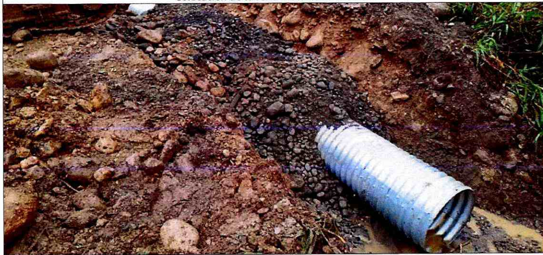
Relleno de estructuras menores.
