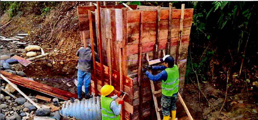
Encofrado de caja para muros tipo Cabezal
