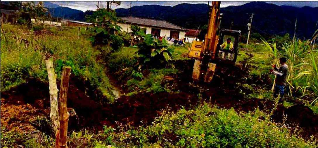
Excavación para colocación de tubería P.V.C D=700
