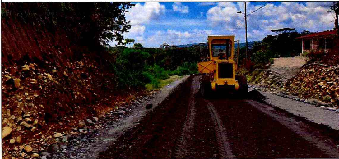
Tendido de Base
