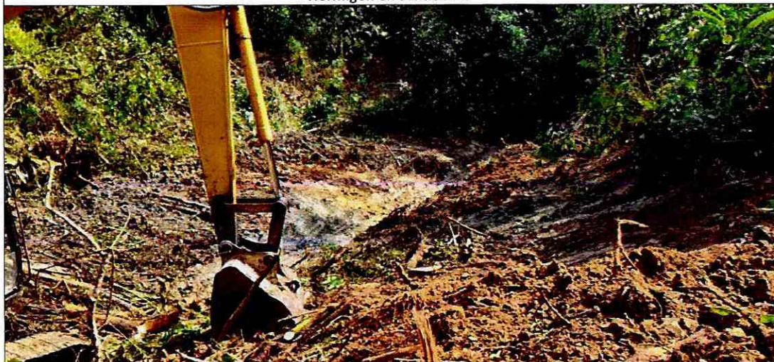
Excavación para cunetas y encauzamiento en abscisa 3+400
