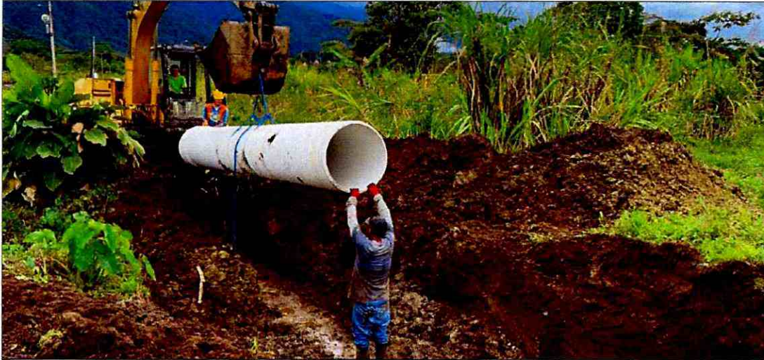
Colocación de tubería P.V.C D=700
