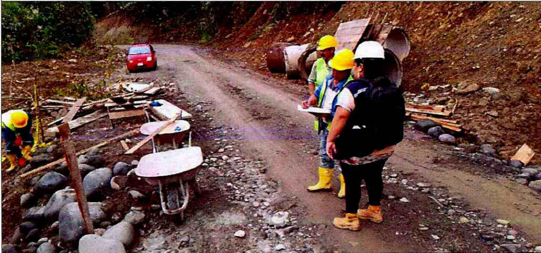
Control de utilización de EPP por parte de Técnico Ambiental
