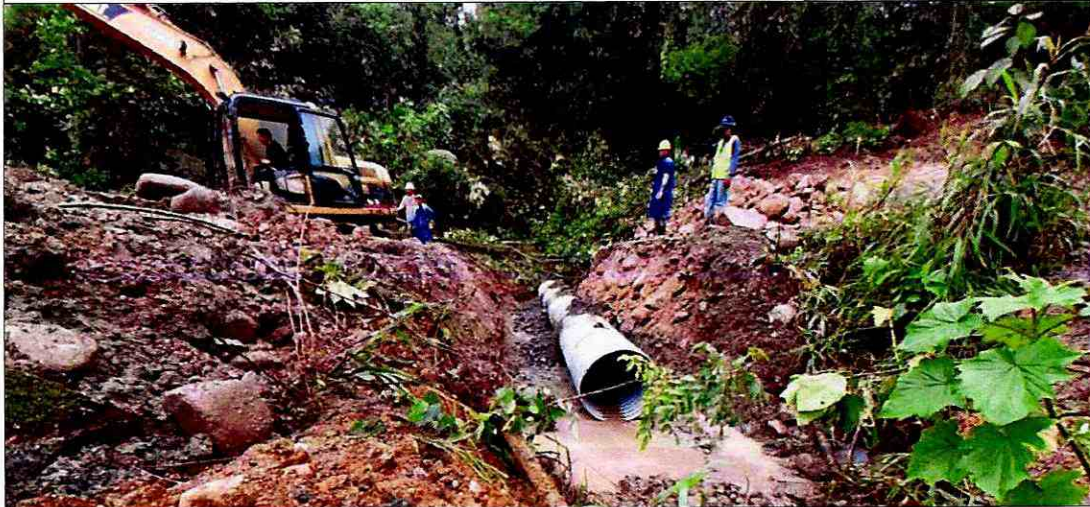
Colocación de tubería metálica D=0.80 m
