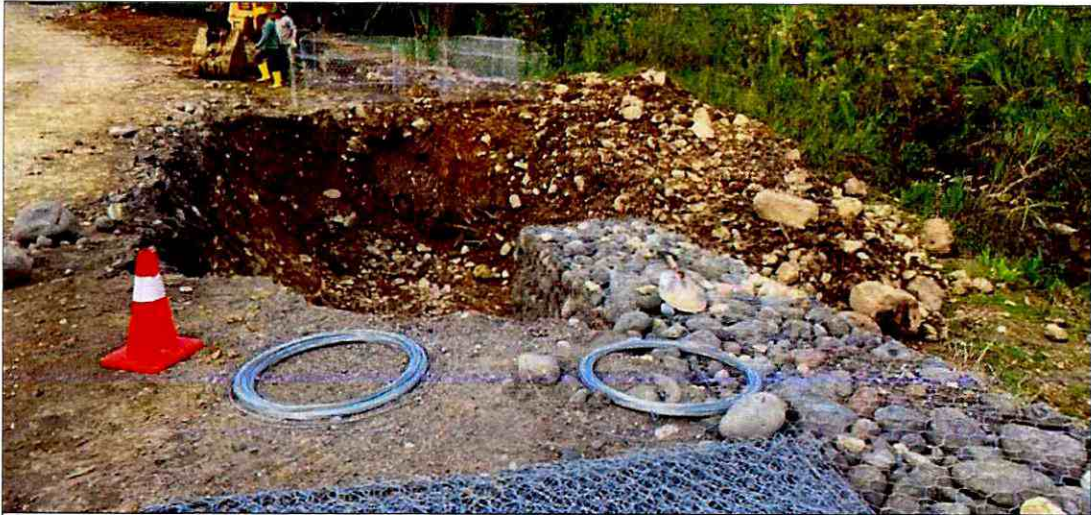
Armado de Gaviones
