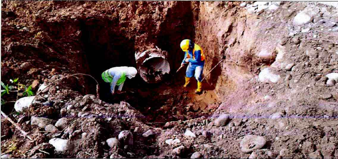
Limpieza de tubería P.V.C D=700
