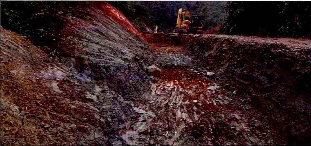
Excavación en zanja para cajonera margen izquierdo
