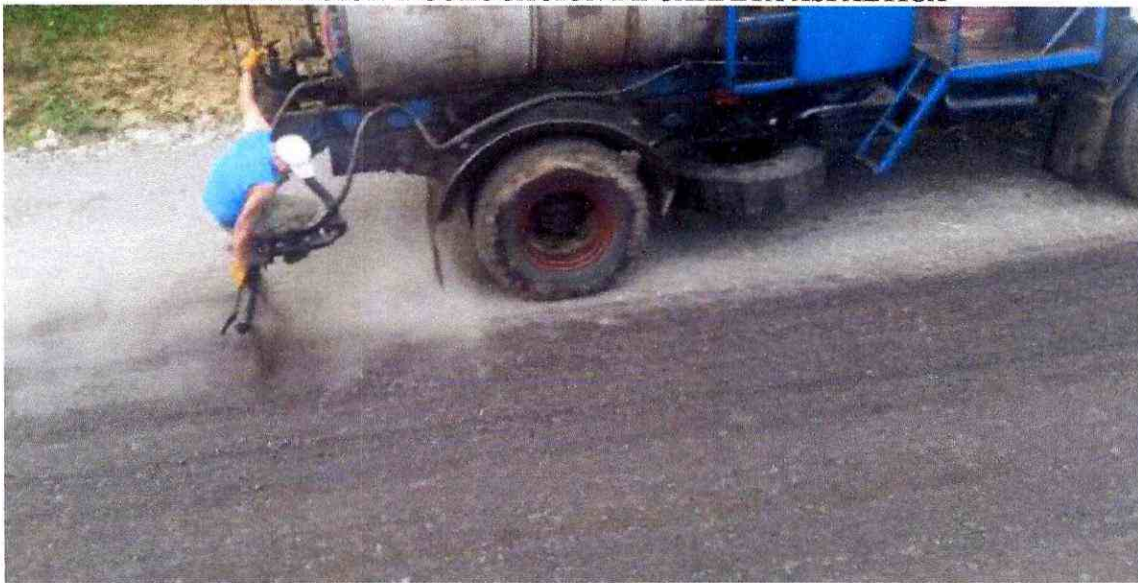
IMPRIMACIÓN Y COLOCACIÓN DE CARPETA ASFALTICA
