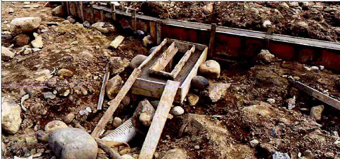
Hormigón en sumideros
