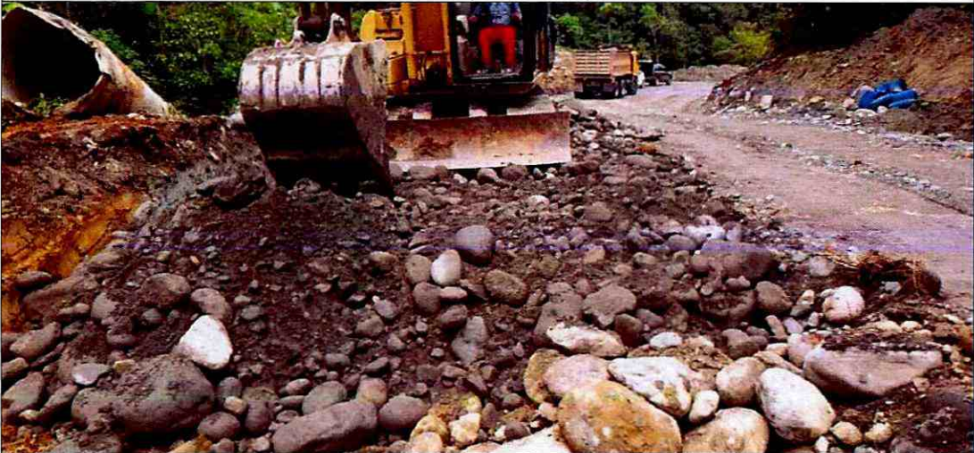
Relleno con material pétreo de mejoramiento
