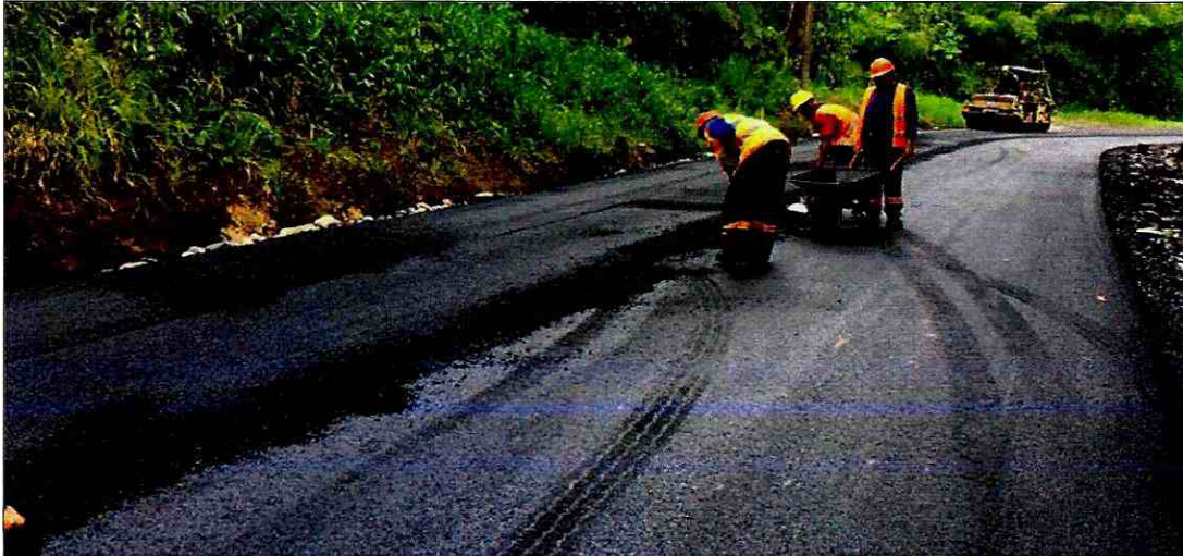
Colocación de carpeta asfáltica
