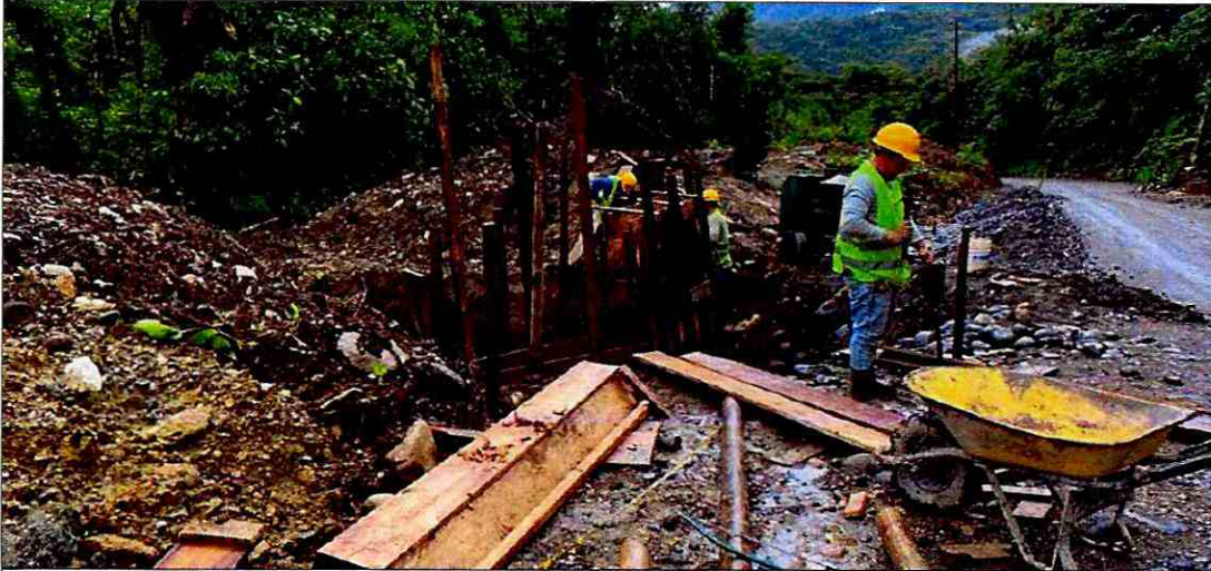
Encofrado de muro tipo Cabezal
