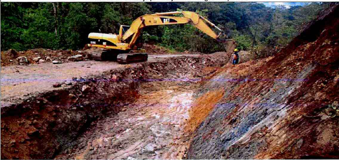
Excavación en zanja para cajonera margen izquierdo
