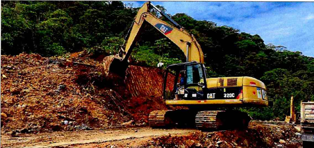
Excavación y desalojo margen derecho
