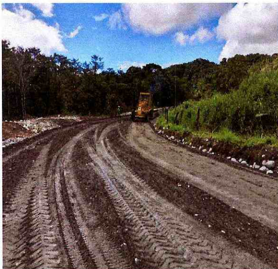
TENDIDO Y COMPACTADO DE MATERIAL DE BASE
