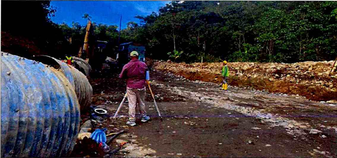
Replanteo y nivelación a nivel de subbase clase 3
