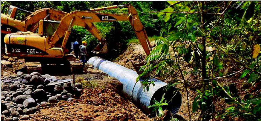
Colocación de tubería metálica D=2.20 m en abscisa
