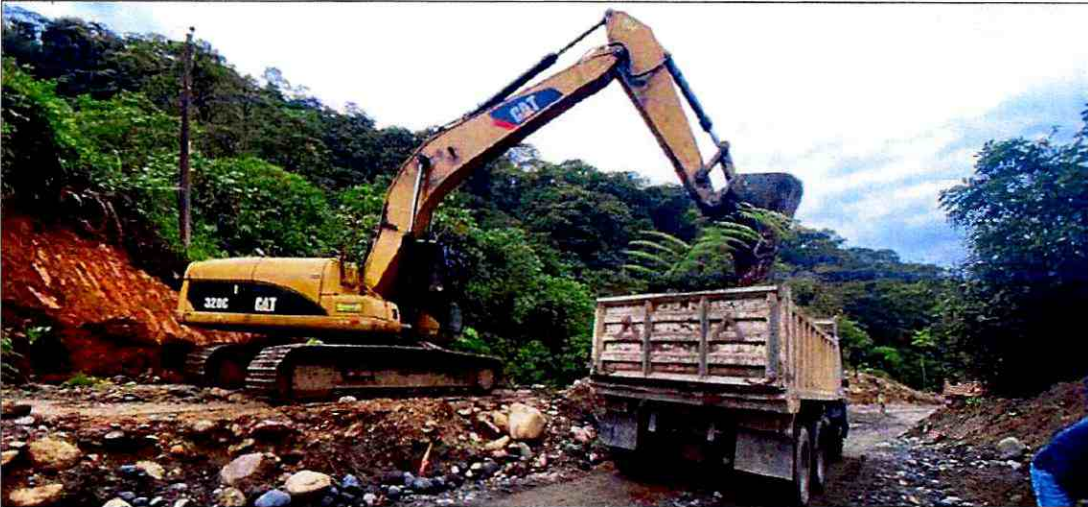
Transporte de material de desalojo
