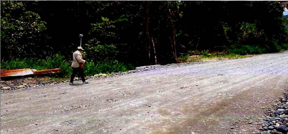
Replanteo y nivelación a nivel de base
