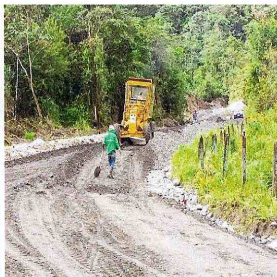
TENDIDO Y COMPACTADO DE MATERIAL DE BASE
