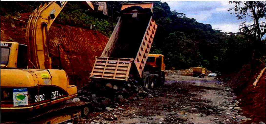
Transporte de material pétreo de mejoramiento
