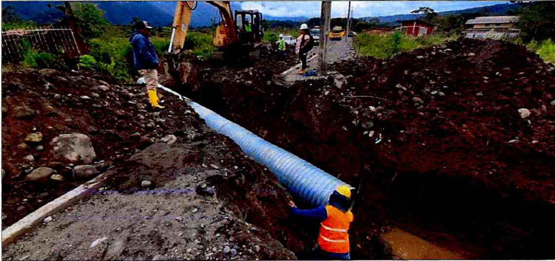
Colocación de tubería metálica D=0.80 en abscisa
