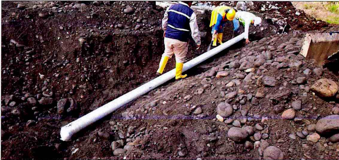
Colocación de acometidas sanitarias en abscisa 0+200
