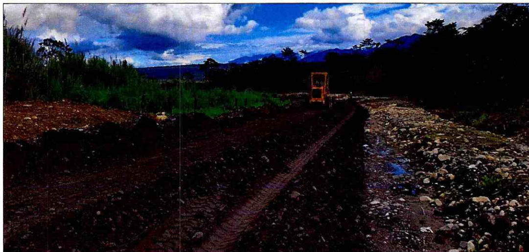
Tendido de material de agregados
