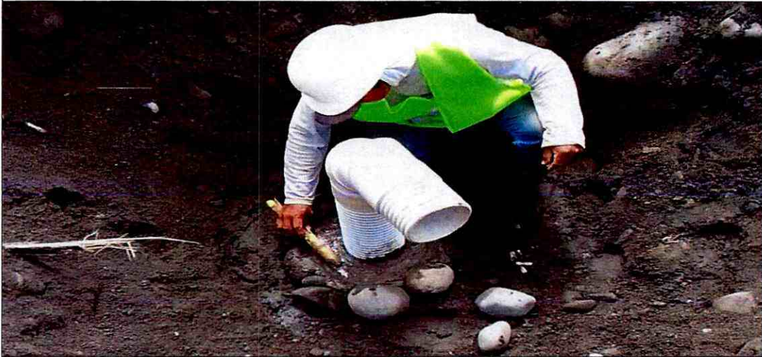
Colocación de acometidas sanitarias en abscisa 0+200
