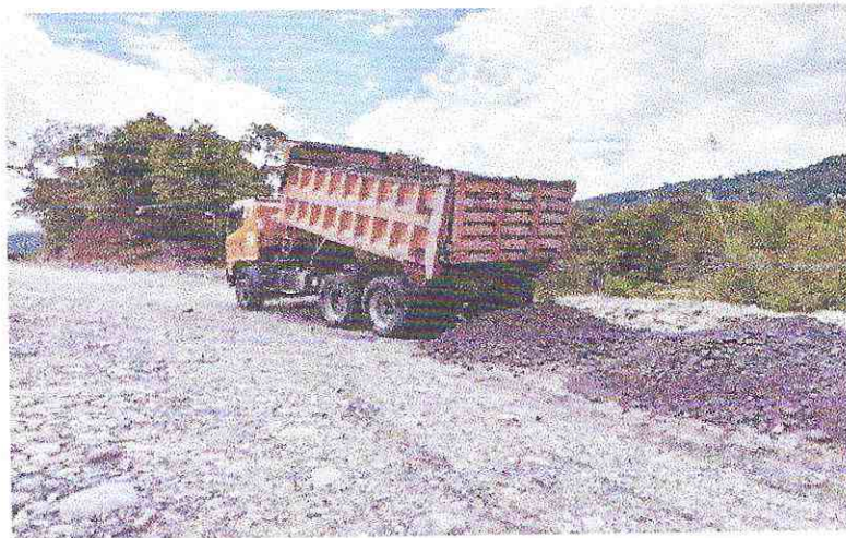
Anexo 5. Transporte de Material de base granular de agregados
