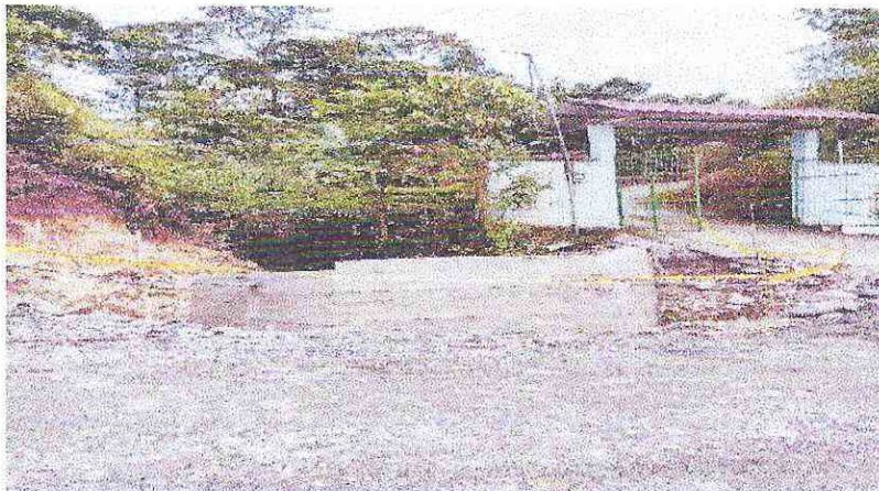
Anexo1. Señalización en el area de construccion de cabezales.
