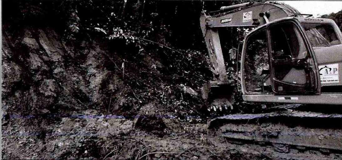
Desbroce y limpieza de márgenes de la vía con máquina.
