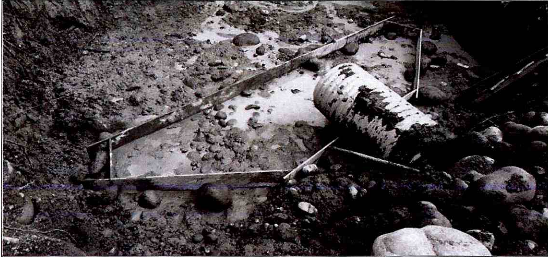
Encofrado para base de cabezal
