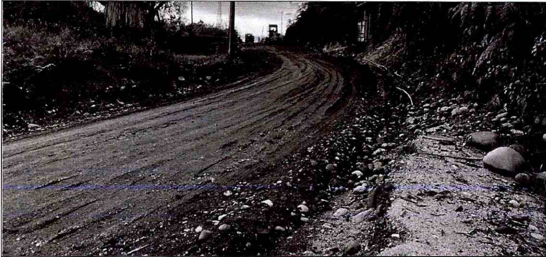
Regado de material de subbase clase 3.
