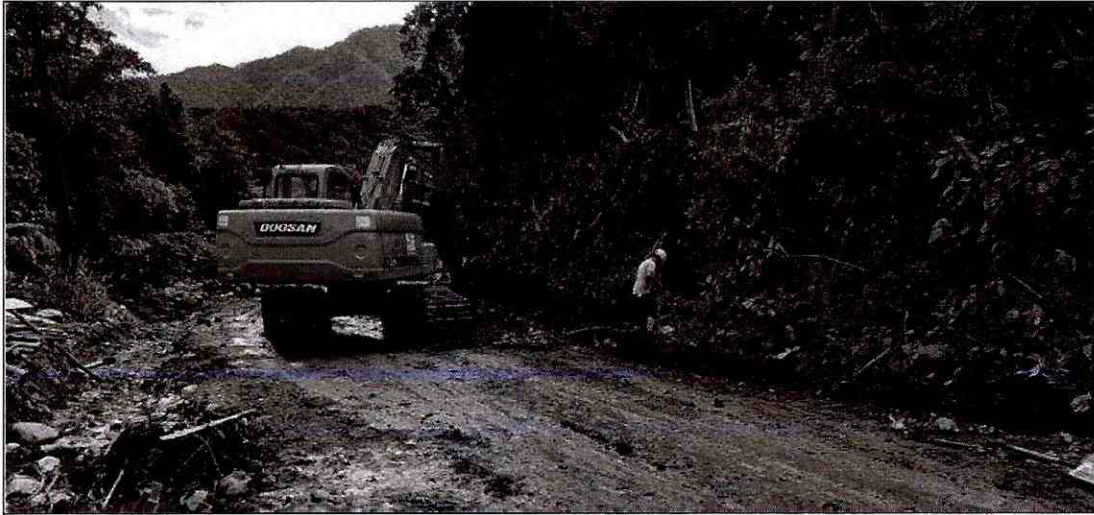
Excavación de suelo natural margen izquierdo.
