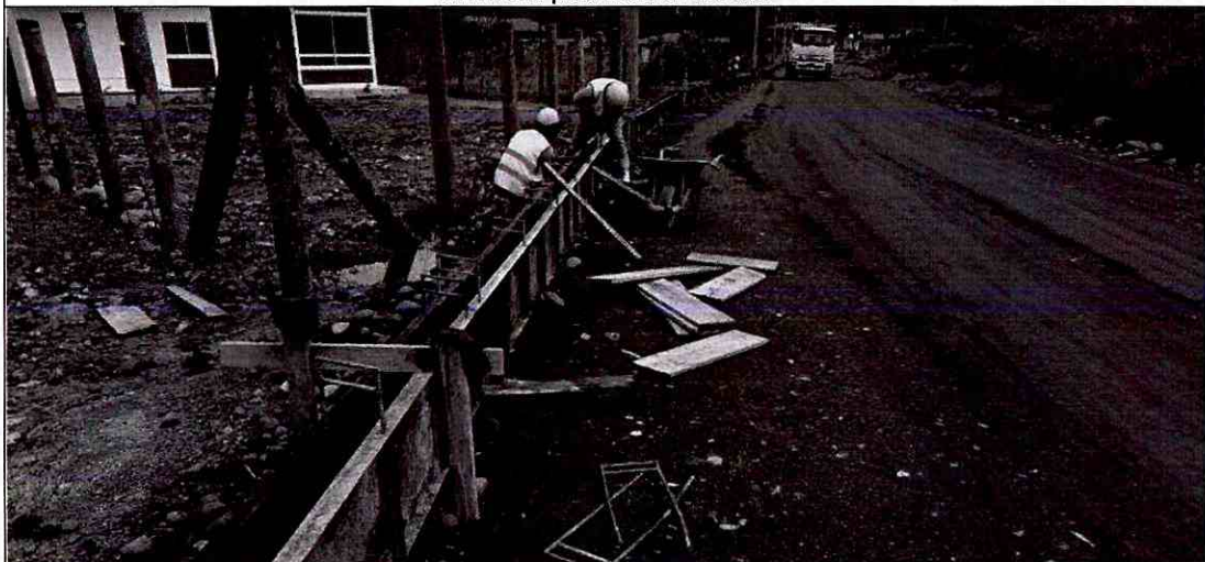
Encofrado de bordillo de h.s.f'c=210 kg/cm 2 - 0,14x0,40) margen derecho.
