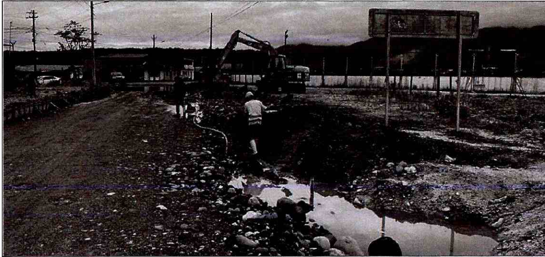
Excavación para bypass de tubería de agua potable municipal existente
