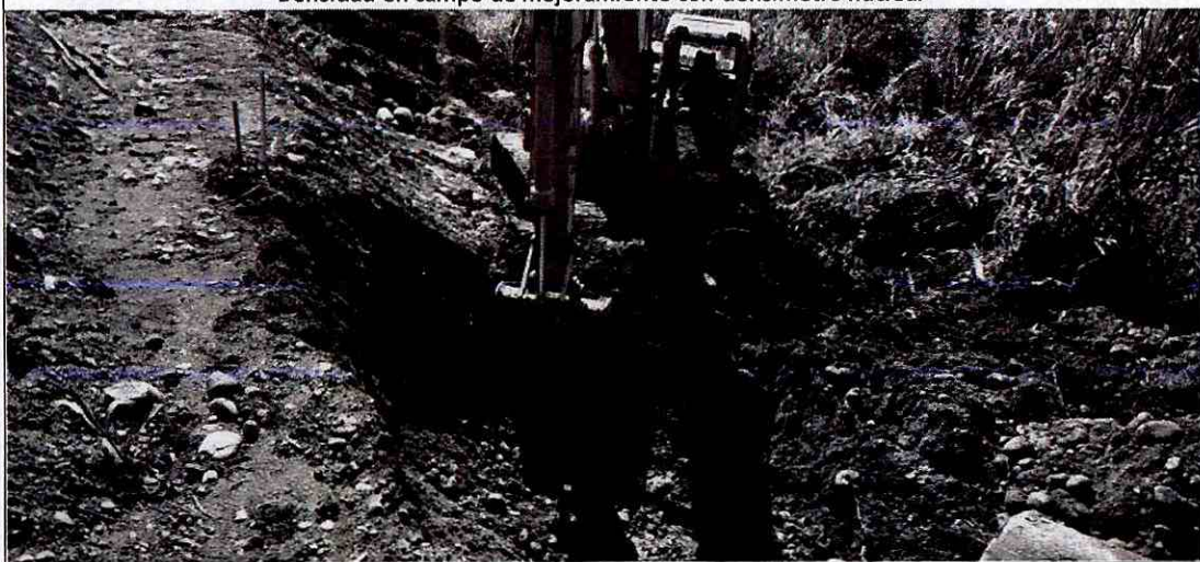
Excavación para armado de muro de gaviones margen derecho.
