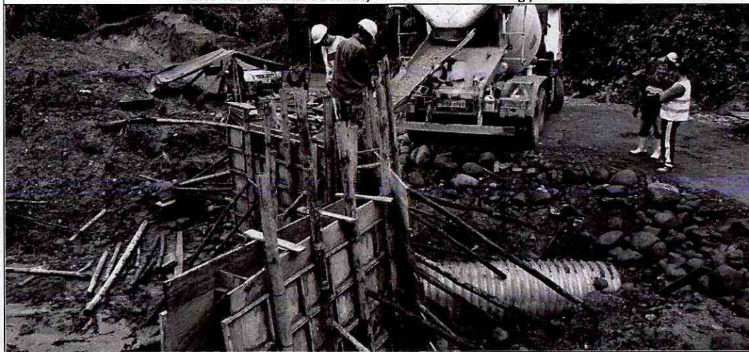
Hormigonado cabezal de salida muro h.s h.s. f'c=180\text{kg./cm}^2 .
