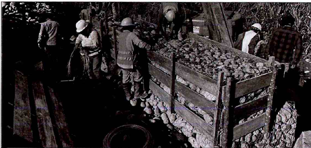
Armado de muro de Gaviones - calibre n° 12 margen derecho.
