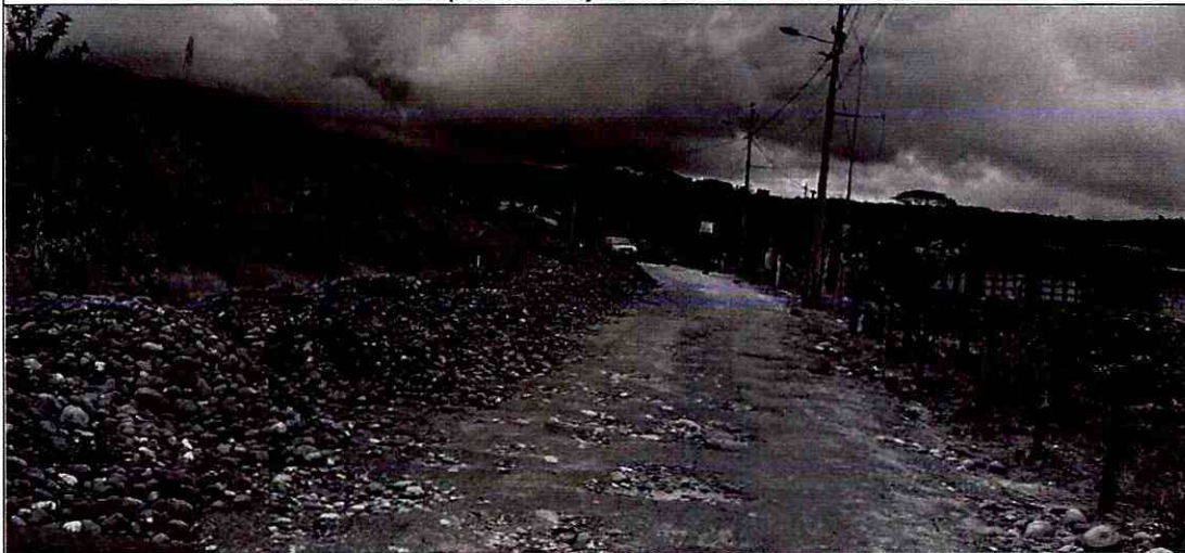
Transporte de material de sub base.
