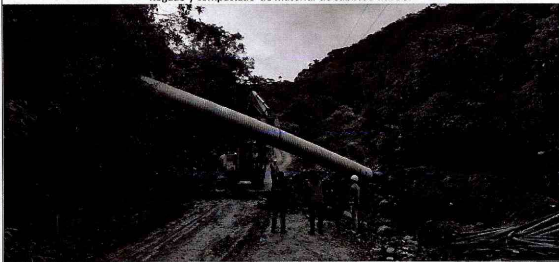
Colocación de tubería de acero corrugado D=0.80 M.
