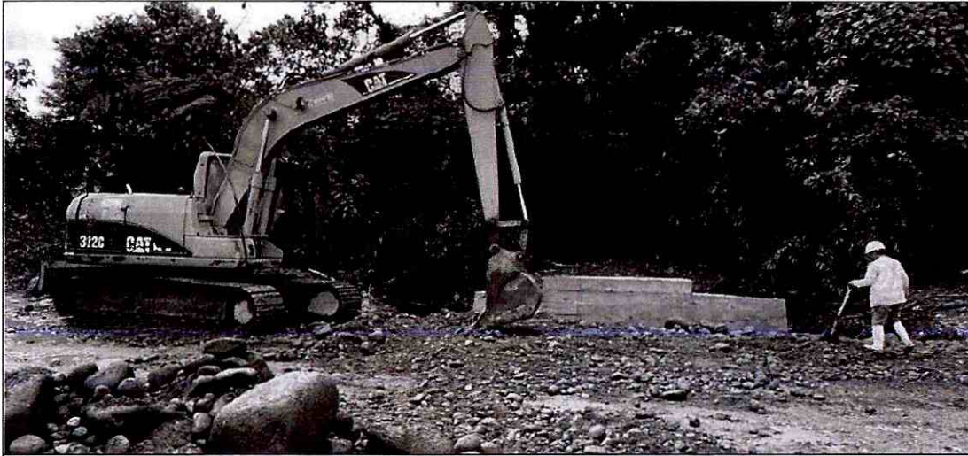
Relleno con material pétreo de mejoramiento en estructuras menores.
