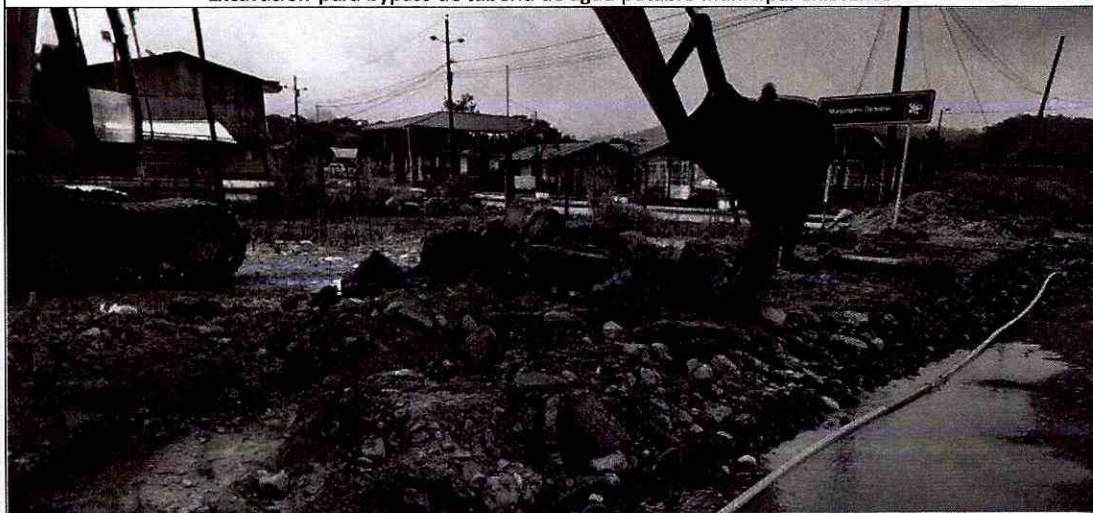
Derrocamiento de acera existente
