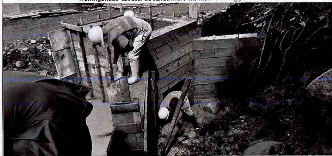
Desencofrado de muro de h.s. f'c=180\text{kg./cm}^2 , cabezal de entrada
