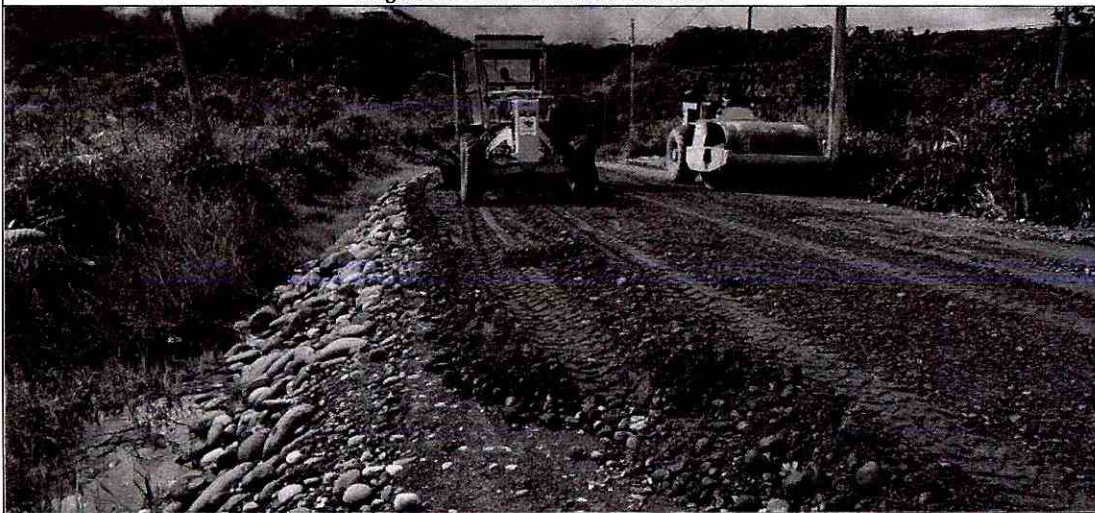
Regado y compactado de material de subbase clase 3.
