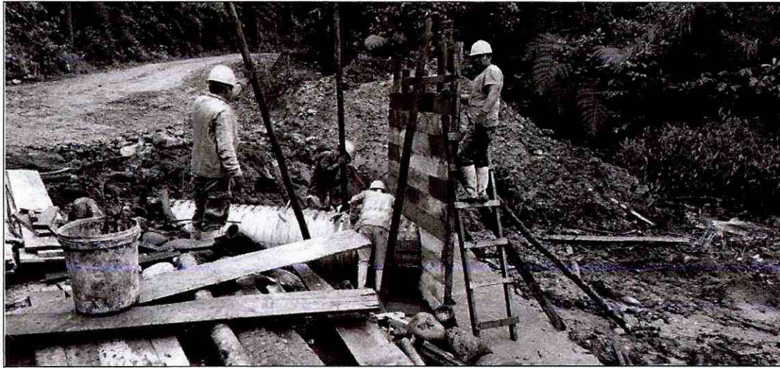
Encofrado cabezal de salida, muro h.s h.s. f'c=180\text{kg./cm}^2 .
