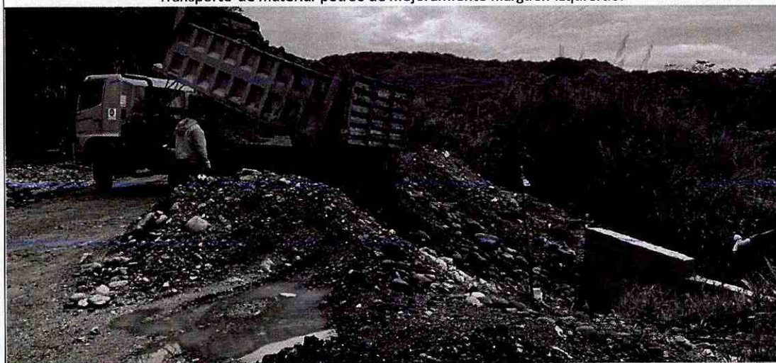
Transporte de material pétreo de mejoramiento.
