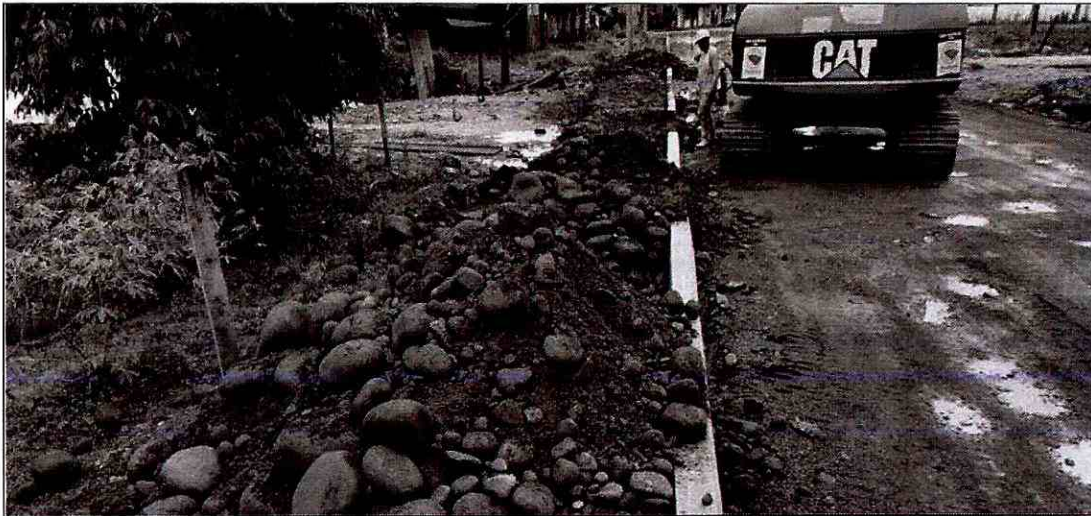
Relleno en capas con material de mejoramiento, base de aceras
