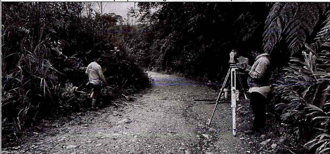
Replanteo y nivelación a nivel de mejoramiento.
