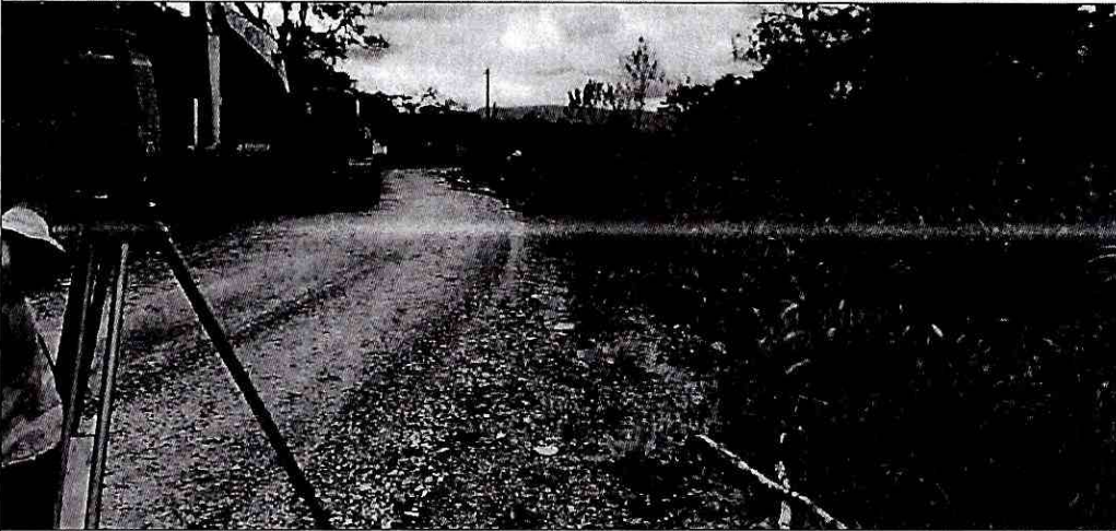
Replanteo y nivelación a nivel de mejoramiento.
