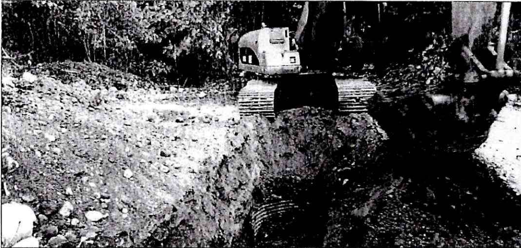
Remoción de alcantarilla D=2.20 M.
