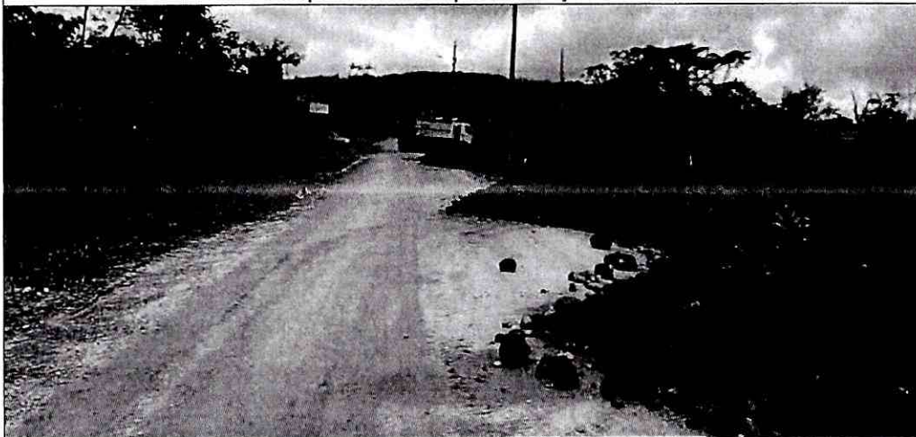
Relleno con material pétreo de mejoramiento en marguen derecho.
