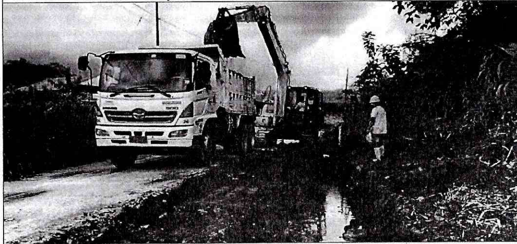
Transporte de material de desalajo margen derecho.
