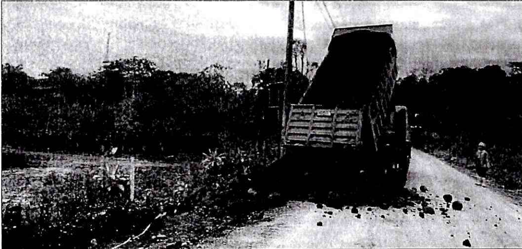
Transporte de material pétreo de mejoramiento.
