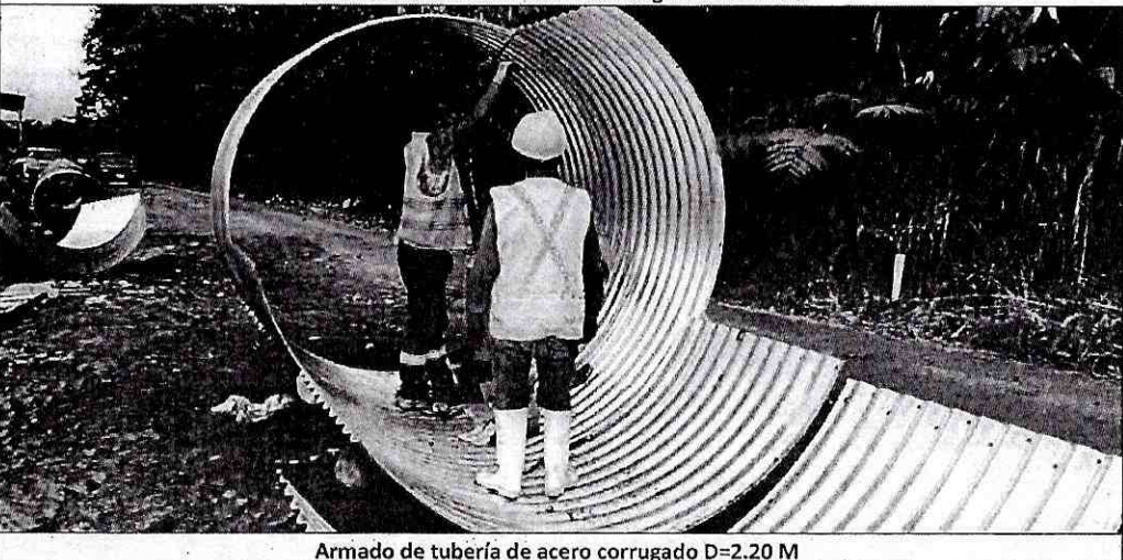
Armado de tubería de acero corrugado D=2.20 M
