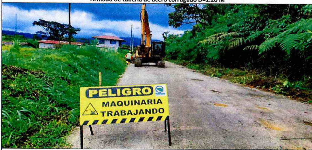
Colocación de señalética móvil tipo barrera.
