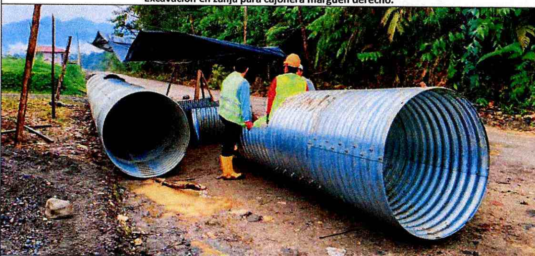
Armado de tubería de acero corrugado D=1.20 M
