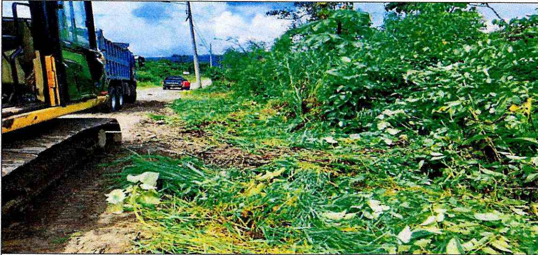
Desbroce y limpieza de márgenes de la vía.
