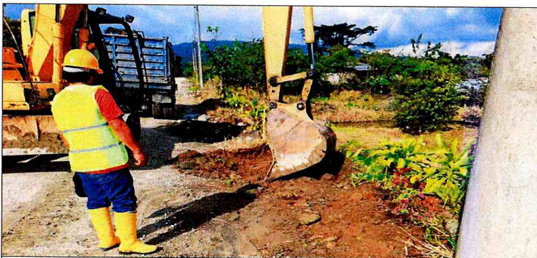
Excavación en zanja para cajonera marguen derecho.
