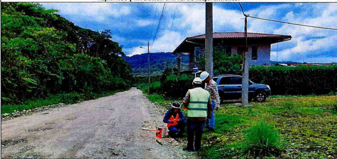
Colocación de estacas de corte y relleno lateral derecho.
