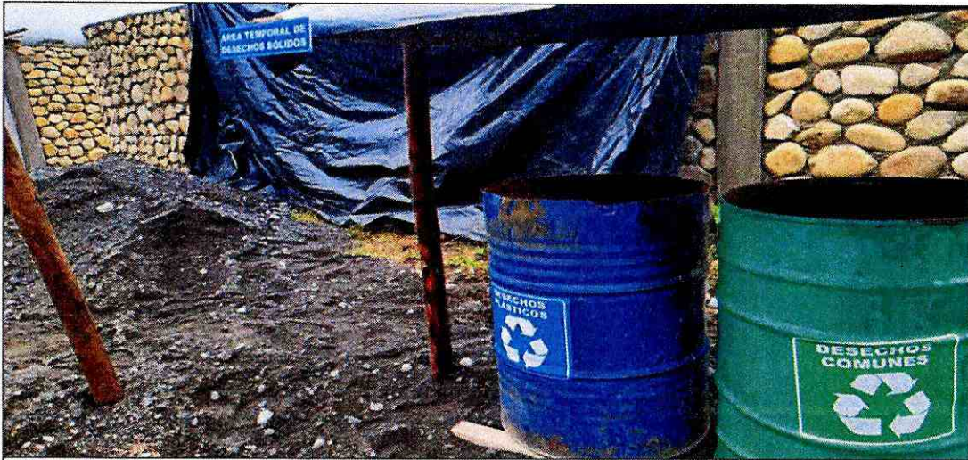
Colocación de contenedores metálicos.
