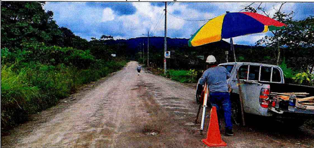
Replanteo y nivelación a nivel de mejoramiento.
