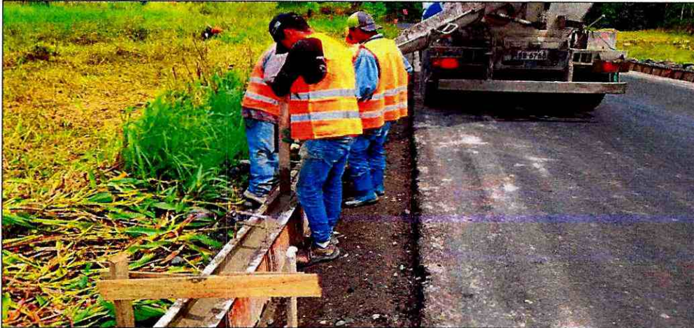
Vertido de Hormigón Simple en bordillo de cuneta
