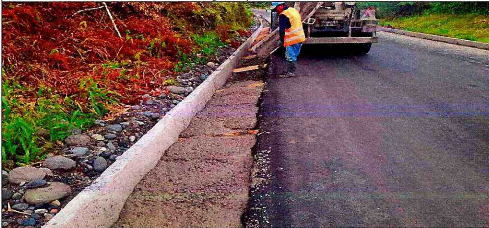
Vertido de Hormigón Simple en espaldón de cuneta
