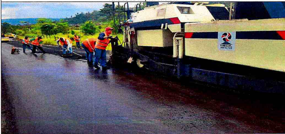
Tendido de carpeta asfáltica con finisher
