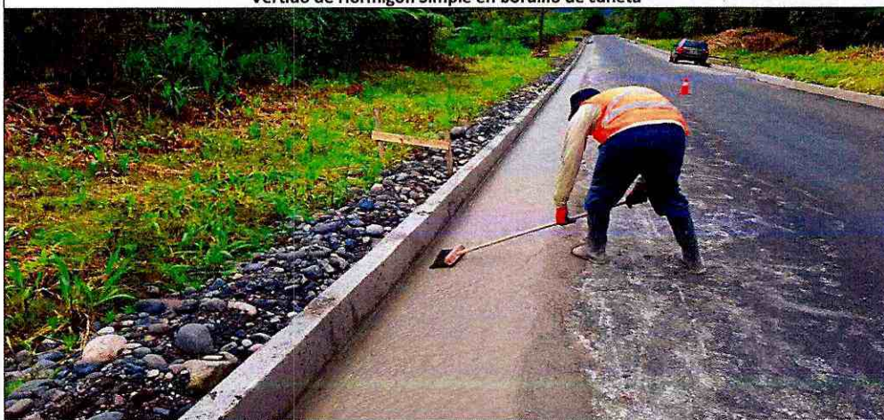
Escobillado de espaldón en cuneta de H.S.
