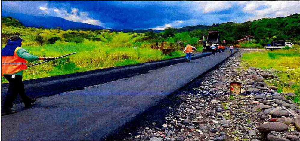
Tendido de carpeta asfáltica
