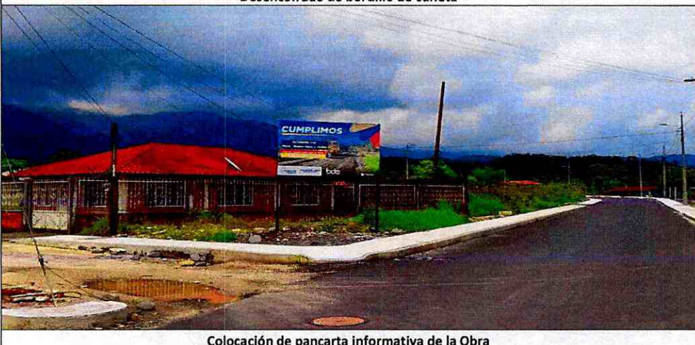
Colocación de pancarta informativa de la Obra
