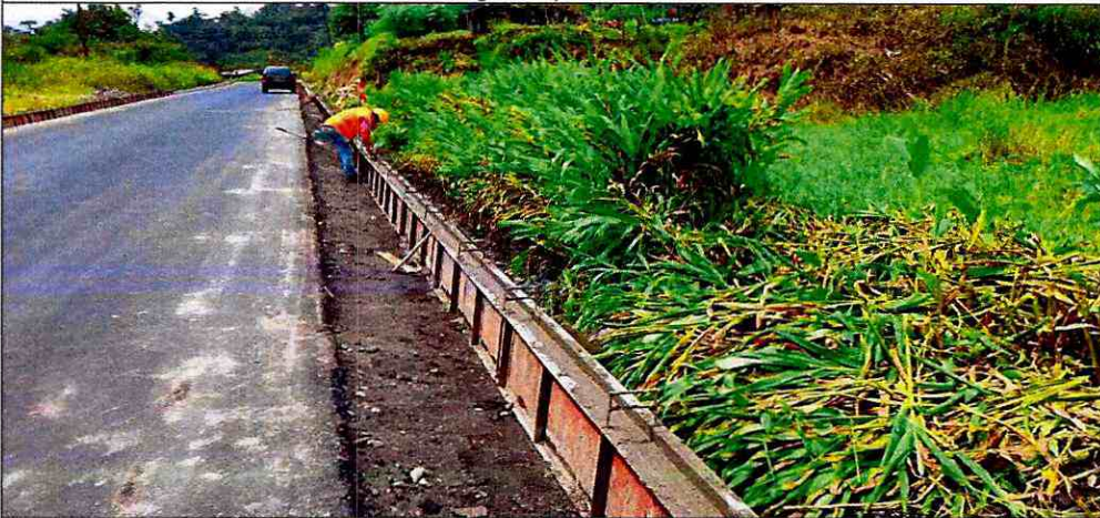
Desenfrado de bordillo de cuneta
