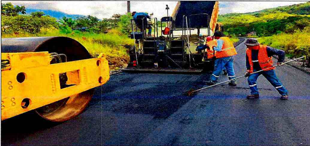
Tendido de carpeta asfáltica con finisher
