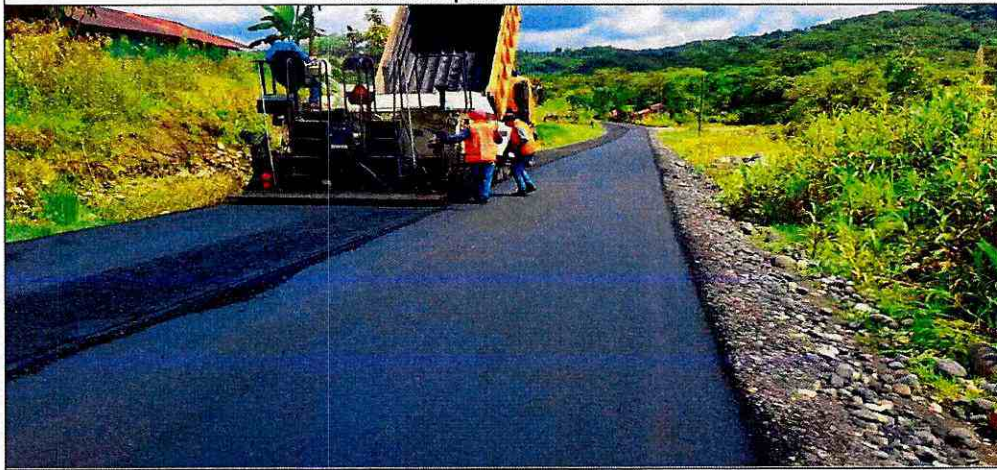
Tendido de carpeta asfáltica con finisher
