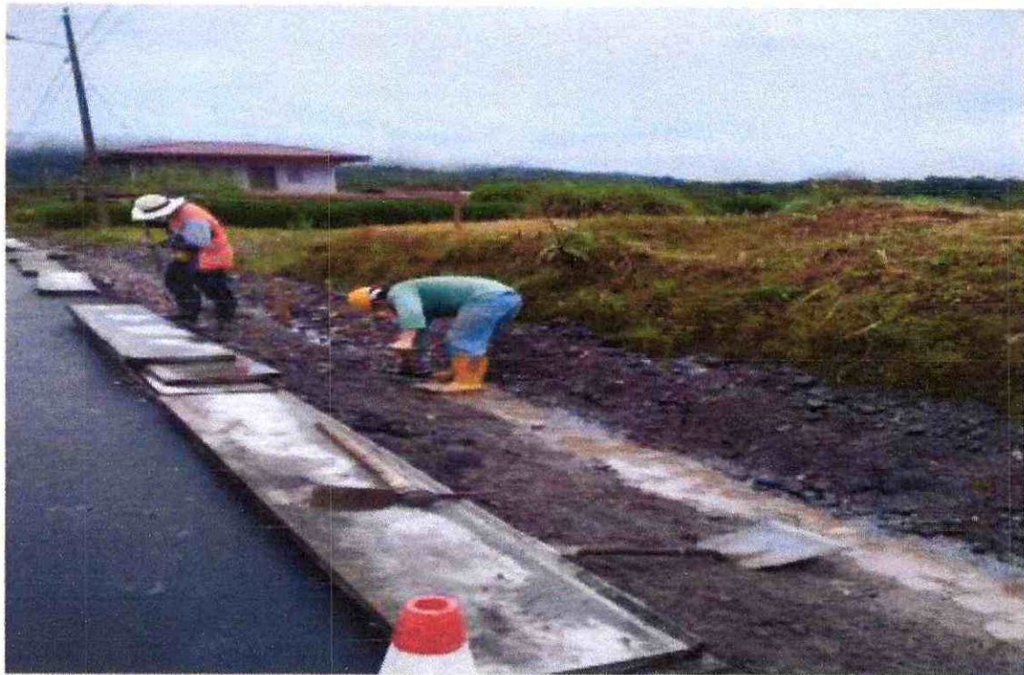
13. CUNETAS LATERALES PARA ESCORRENTÍAS DE AGUA LLUVIA.
