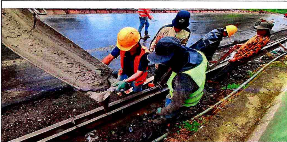
Vertido de Hormigón Simple en bordillo de cuneta
