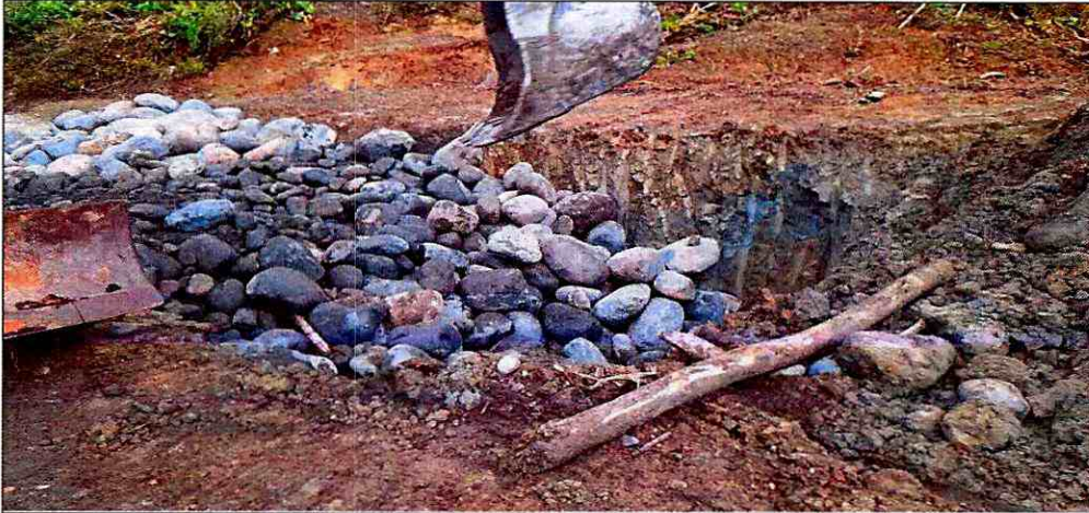
Excavación y relleno en zanja de drenaje y muro de contención en abscisa 3+400
