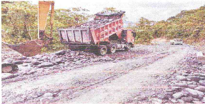
Anexo1. Señalización en el área de trabajo.
