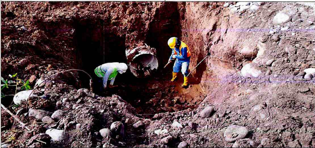
Limpieza de tubería P.V.C D=700
