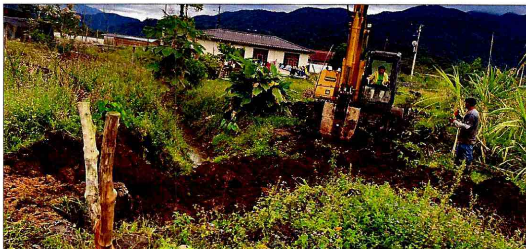
Excavación para colocación de tubería P.V.C D=700
