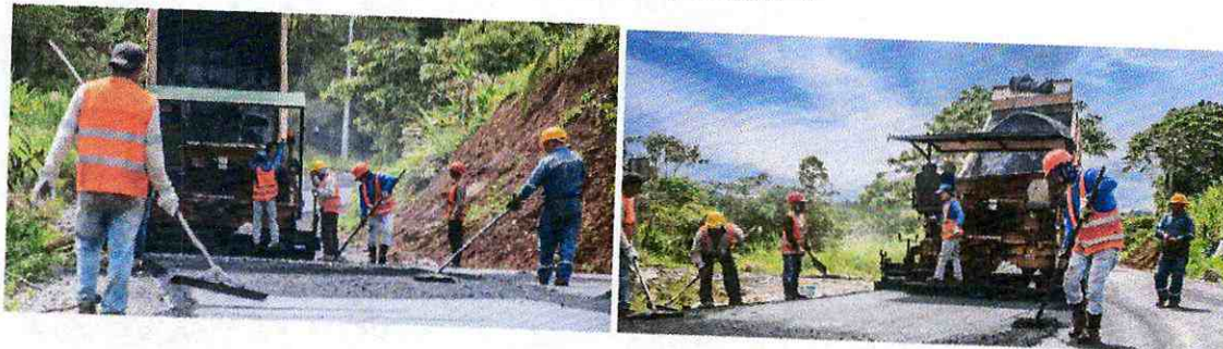
Rubro 15 - C. rodadura hormigon asf. Mezclado en planta, e=2"
