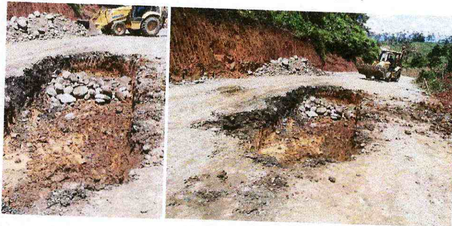
Rubro 7 - Material pétreo de mejoramiento (minada, cargada y regada)
