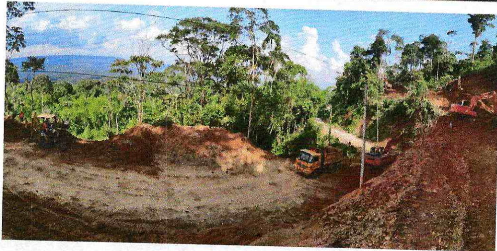
Rubro 4 - Excavación para cunetas y encauzamiento
