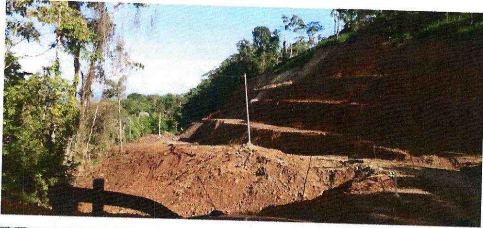
Rubro 3 - Excavación sin clasificar (mov.de tierra)
