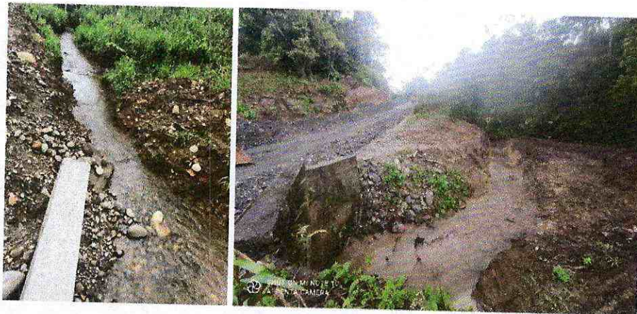
Rubro 4 - Excavación para cunetas y encauzamiento
