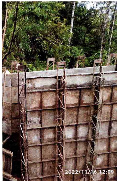
Fotografía 9 y 10. construcción y colocación de armicos y cabezales.
