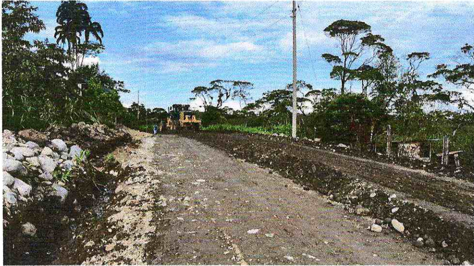
Rubro 9 - Material de base granular de agregados
