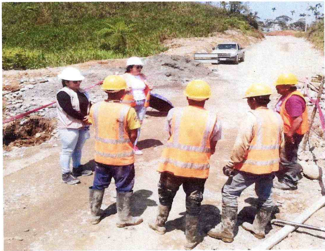
Fotografía 26 y 27. Uso de Equipo de protección personal.
