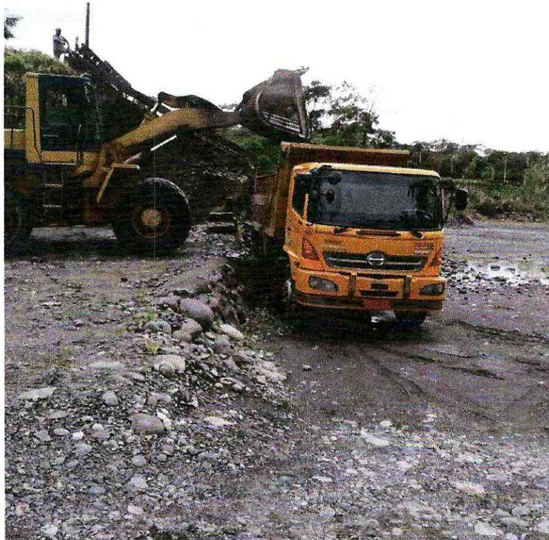
Rubro 11 - Transporte de material pétreo de subbase clase 3
