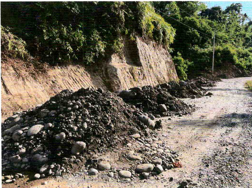
Rubro 7 - Material pétreo de mejoramiento (minada, cargada y regada)
