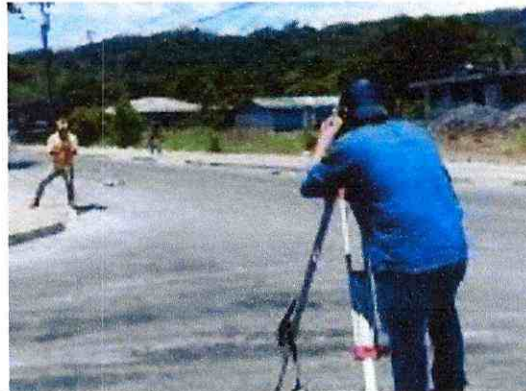
Excavación y relleno de estructuras menores
