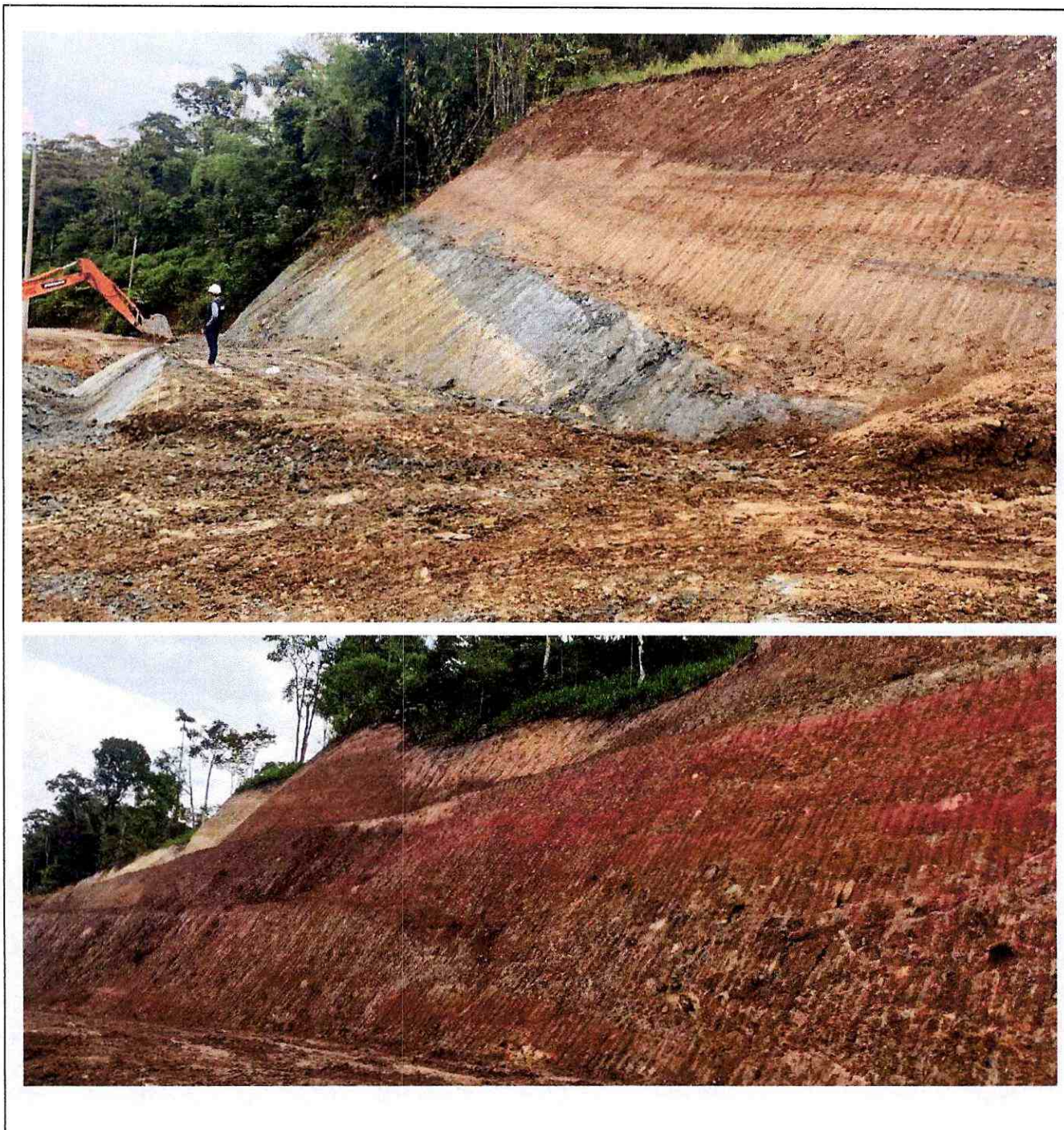
Fotografía 13 y 14. Áreas limpias y despejadas.
