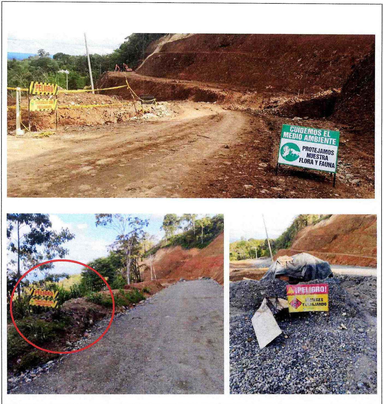
Fotografía 3, 4 y 5. Señalética ubicada en los distintos frentes de trabajo del proyecto.
