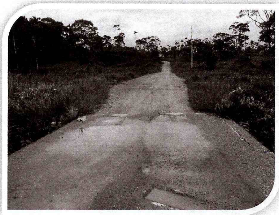
PUENTE EXISTENTE ABS. 0+634
