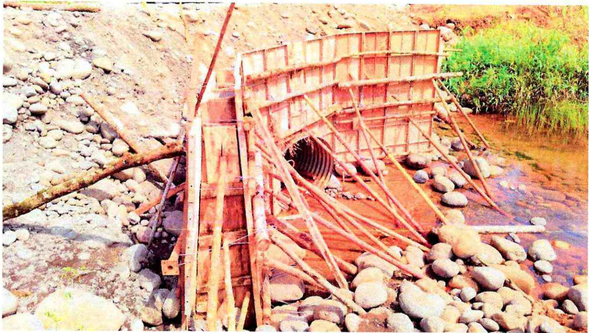
Muro de H.S. f'c=180 \text{ kg/cm}^2 tipo B (Cabezales)
