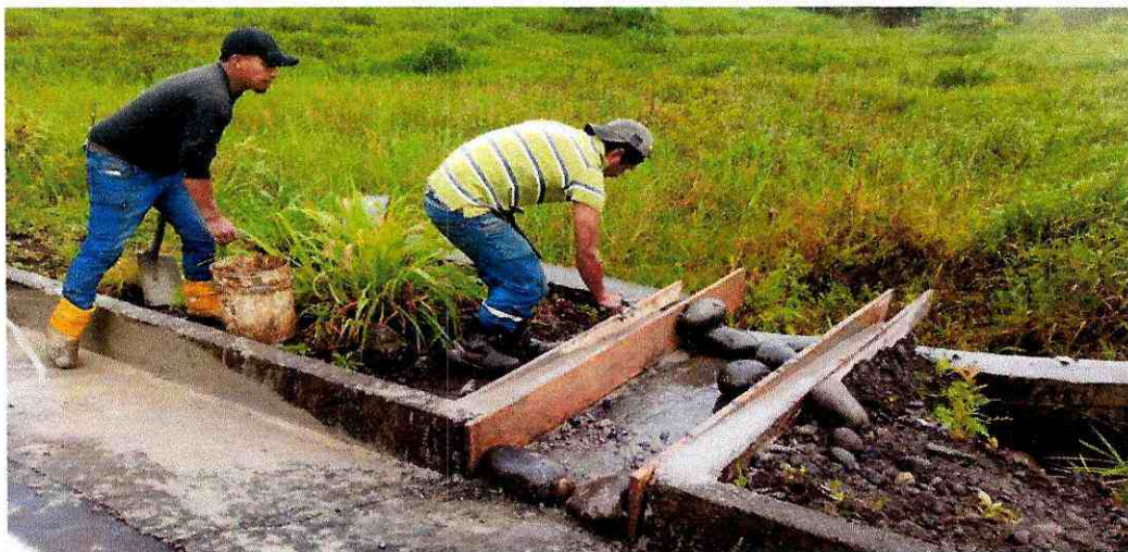
Hormigón para cunetas (F'C=180 KG/CM2)
