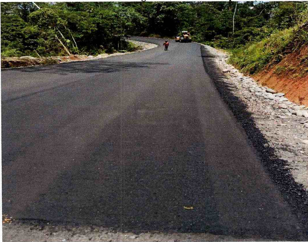
C. rodadura hormigón asf. Mezclado en planta, e=2".
