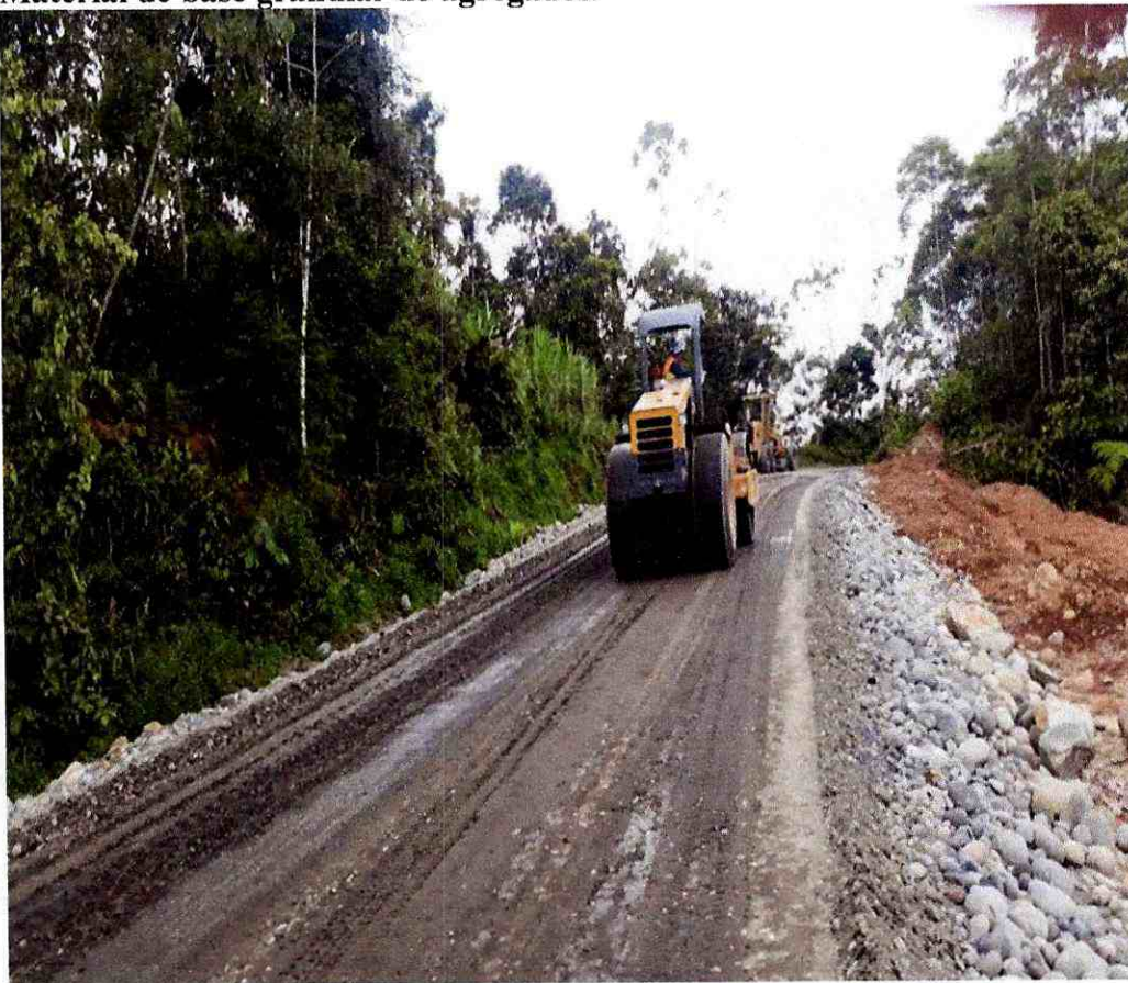
Material de base granular de agregados.
