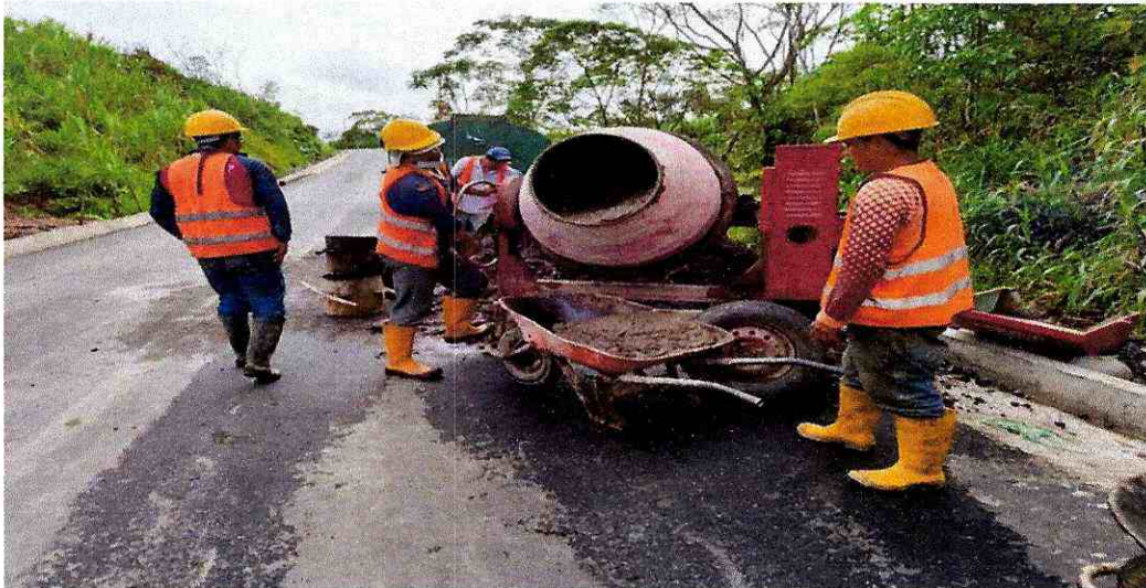
Hormigón para cunetas (F'C=180 KG/CM2)
