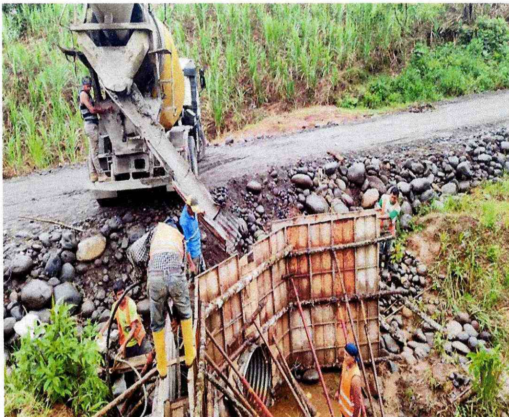
Muro de H.S. f'c=180\text{kg./cm}^2 tipo B(Cabezales)
