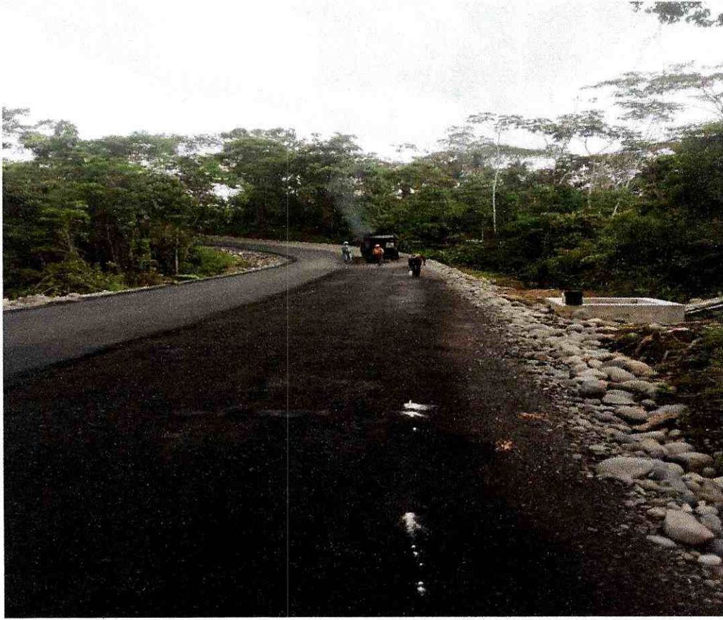
C. rodadura hormigón asf. Mezclado en planta, e=2".
