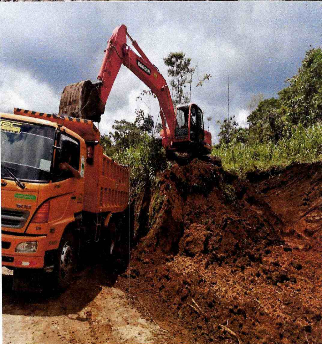
Transporte de material pétreo de mejoramiento.
