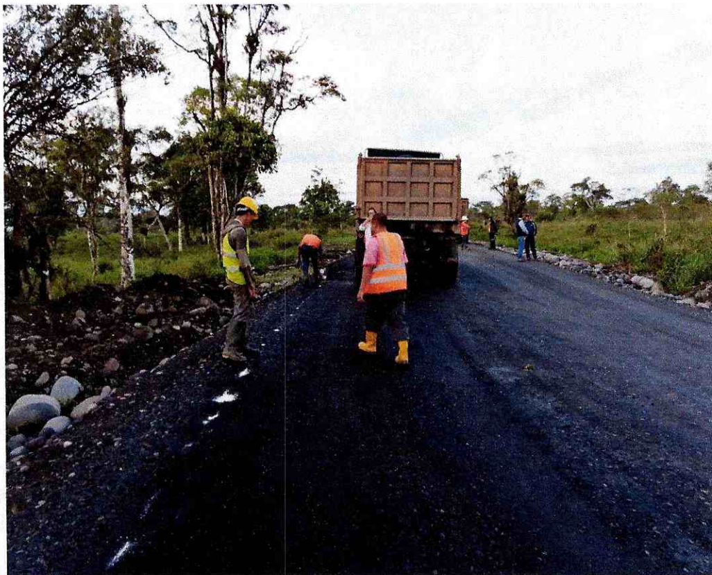
Asfalto RC-250, para imprimación.
