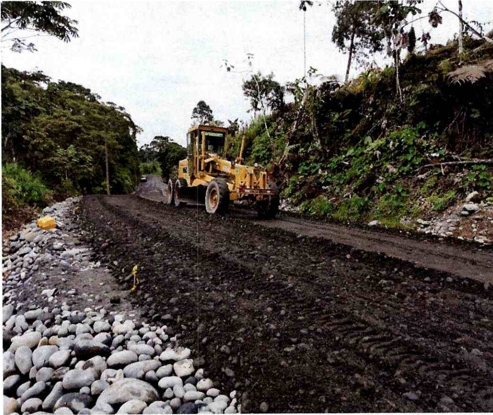
Material de base granular de agregados.
