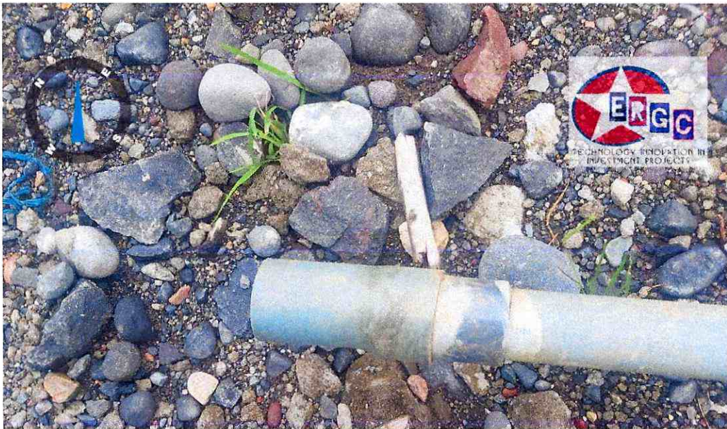
• RUBRO N°4.- SUM. E INST. TUBERIA PVC D=63mm 1MPa U/Z
