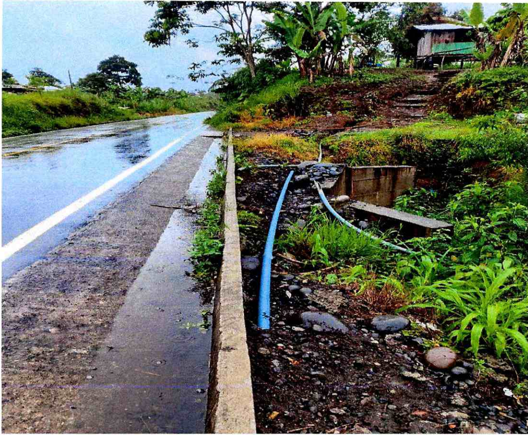
• RUBRO N°4.- SUM. E INST. TUBERIA PVC D=63mm 1MPa U/Z
