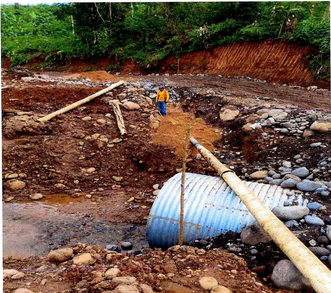
• RUBRO N°5.- ENCAMISADO DE TUBERIA DE D=110mm
