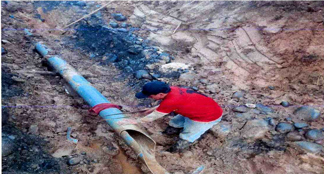
• RUBRO N°15.- SUM. E INST. TUBERIA PVC D=200mm 1MPa U/Z
