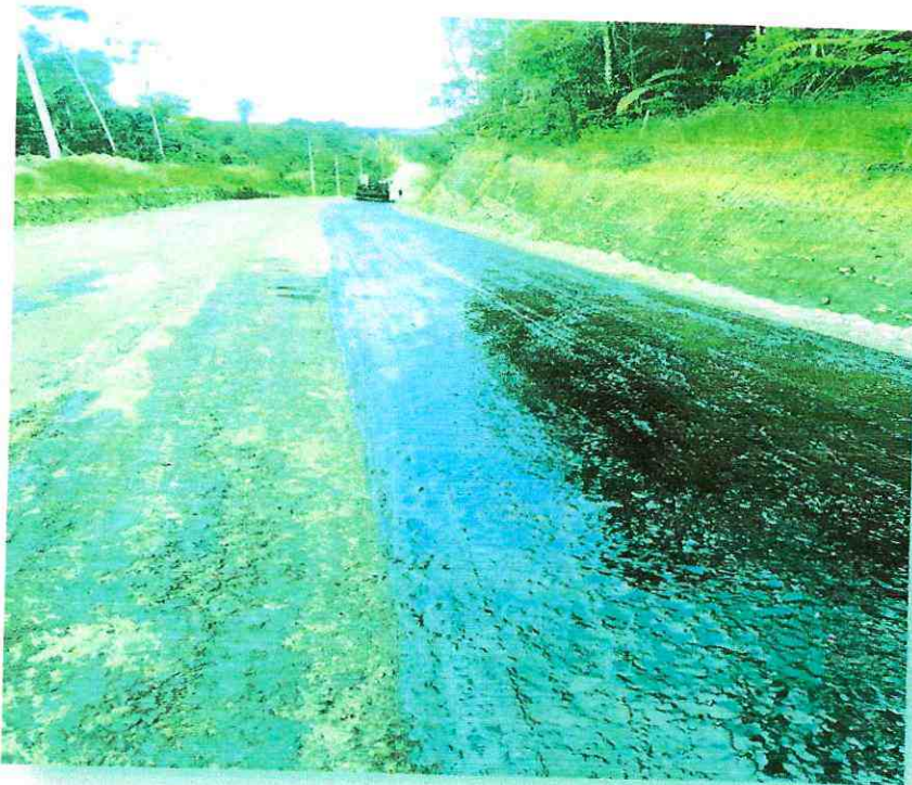
Rubro 20 – Asfalto RC 250, para imprimación
