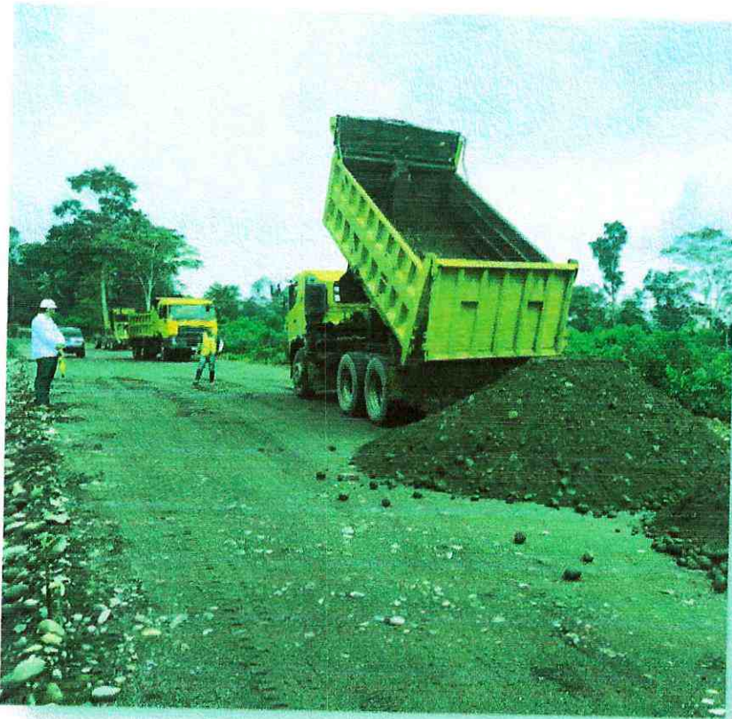
Rubro 19 – Transporte de material base granular de agregados
