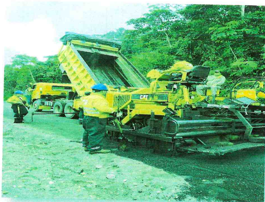
Rubro 21 – C. rodadura hormigón asf. Mezclado en planta, e = 2''
