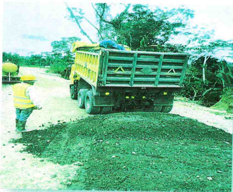
Rubro 19 – Transporte de material base granular de agregados
