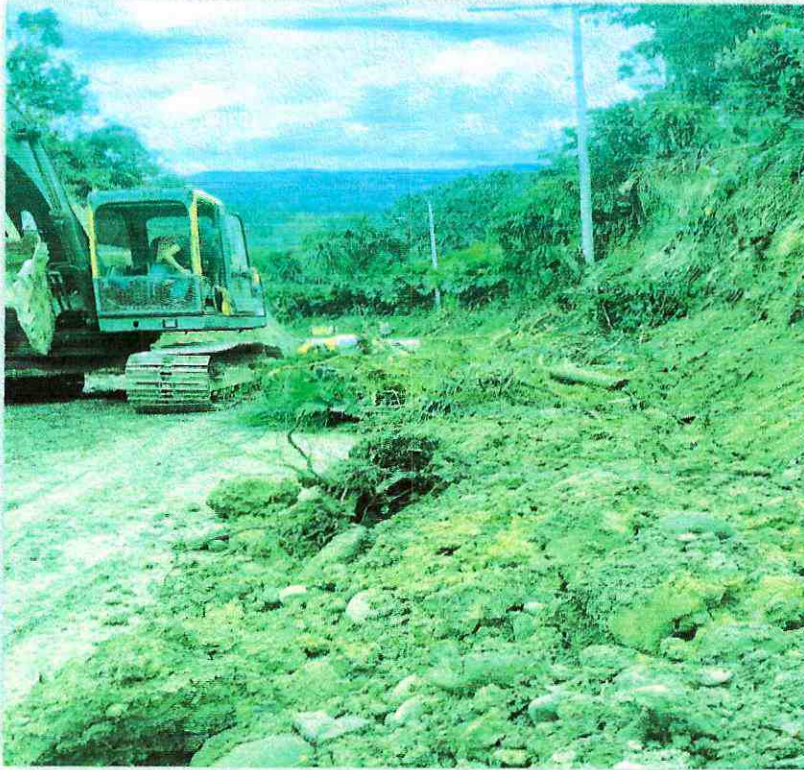
Rubro 11 – Limpieza de derrumbes
