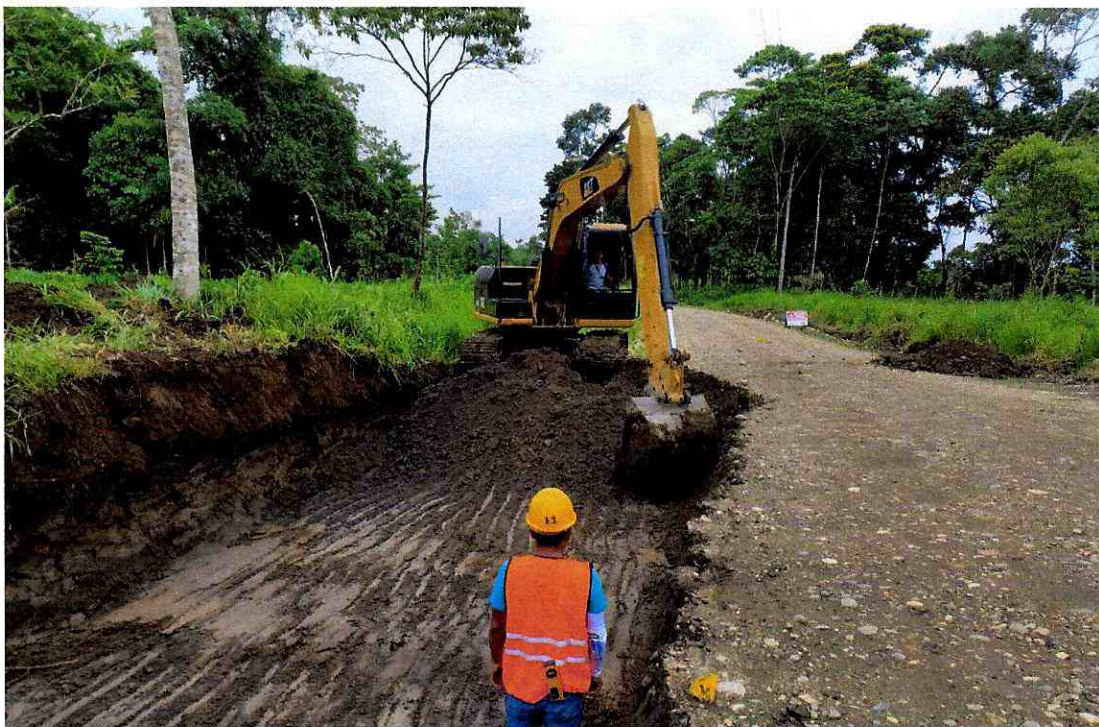
Excavación sin clasificar(mov.de tierra)
