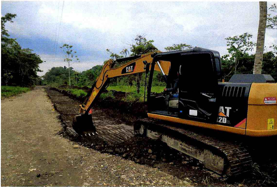
Excavación sin clasificar(mov.de tierra)
