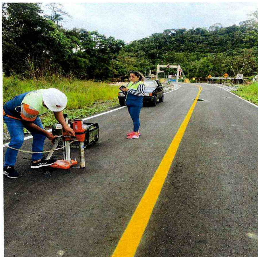
PROYECTO: ASFALTADO C.V. CHINCHAYAKU - PUYOPUNGO, PARROQUIA MADRE TIERRA, CANTON MERA, PROVINCIA DE PASTAZA
