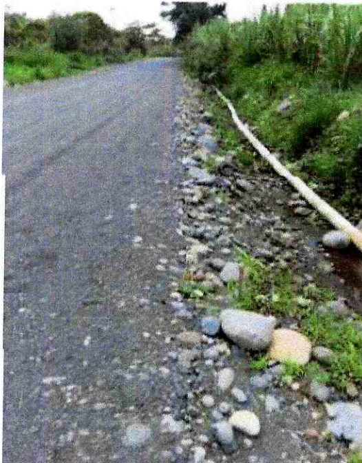
Carretero con subbase de clase 3
