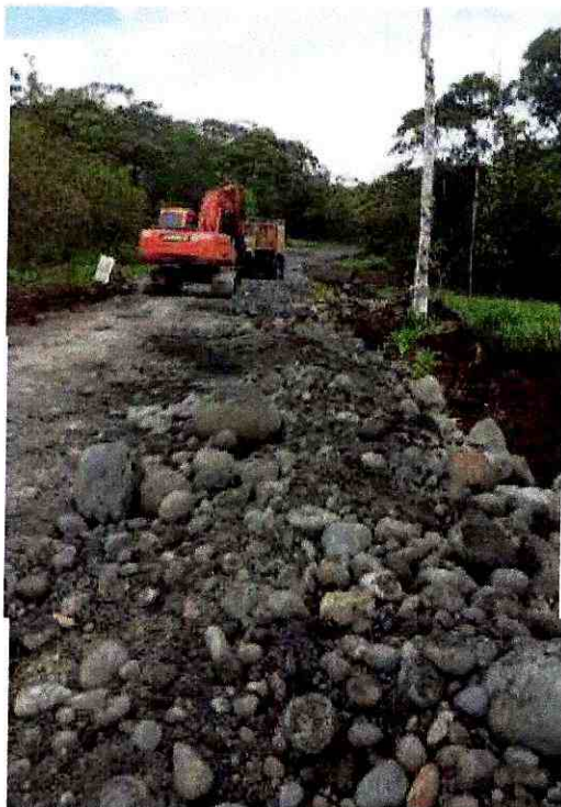
Regada de material de mejoramiento
