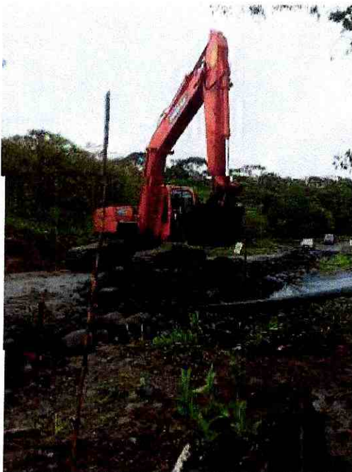
Regada de material de mejoramiento
