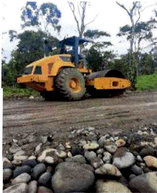
Compactado de mejoramiento con rodillo
