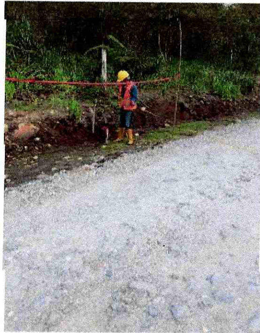
Colocación de Señalización
