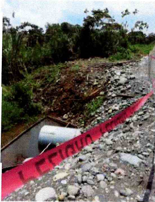
Colocación del ármico
