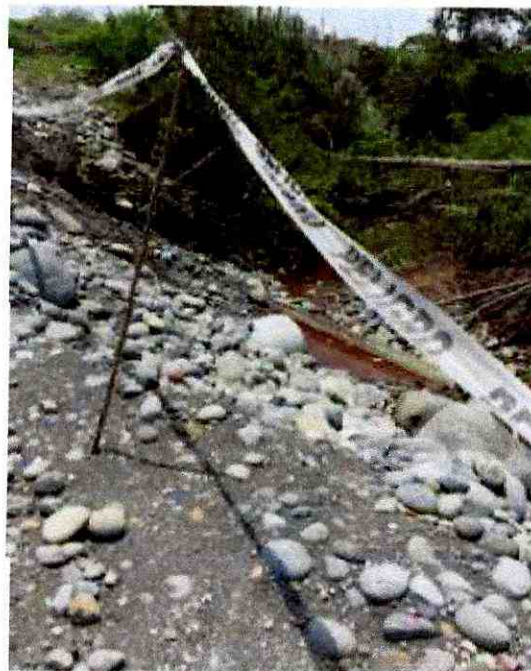
Colocación del armico
