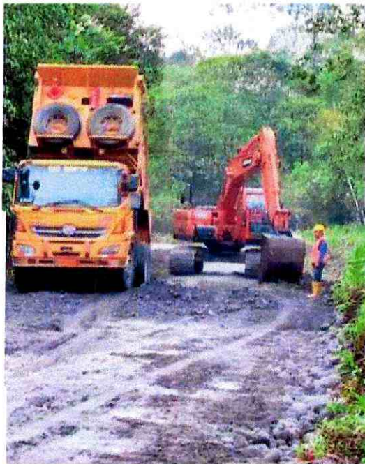
Regada del material de mejoramiento
