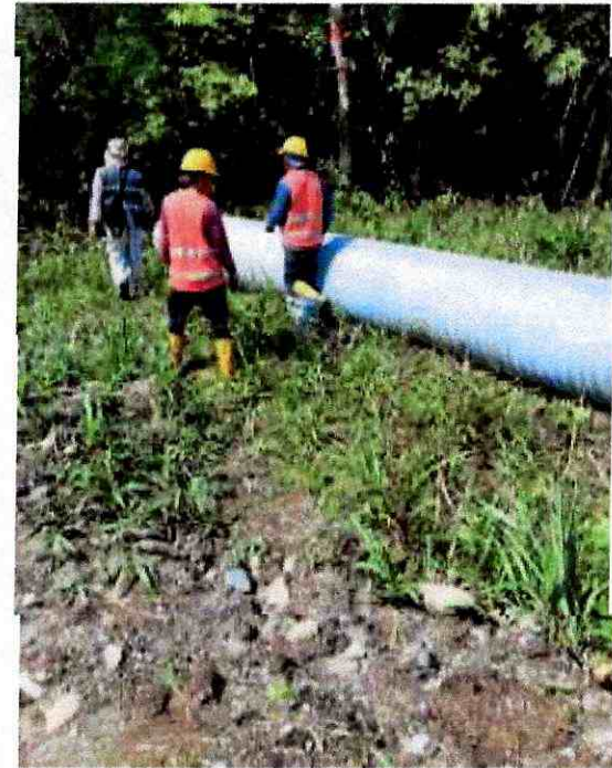
Armado del ármico
