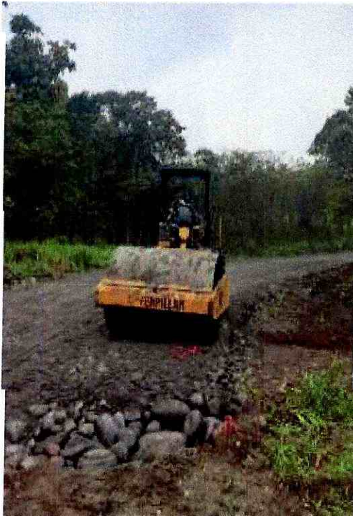
Descarga de material de mejoramiento
