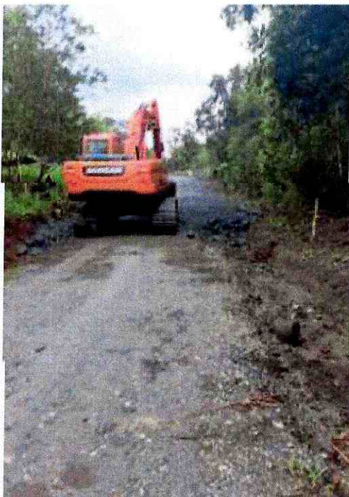
Regada de material de mejoramiento
