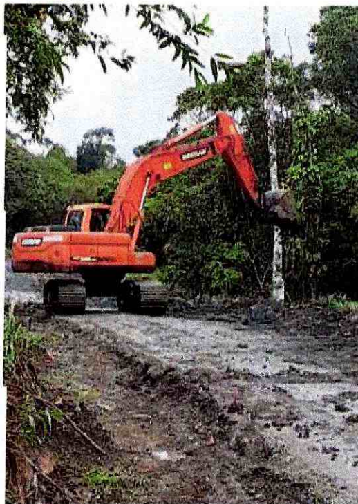
Excavación de cunetas
