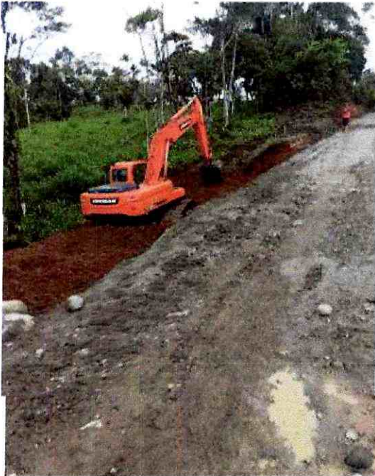
Excavación de cuneta
