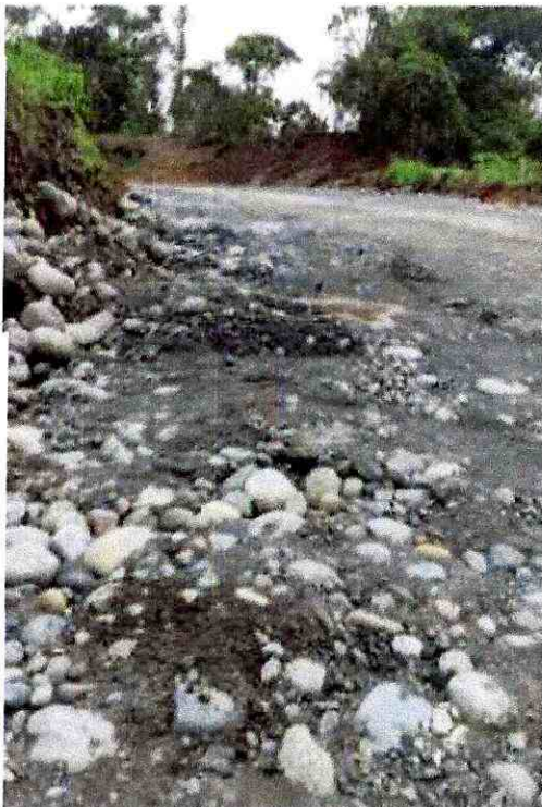
Carretero con material de mejoramiento
