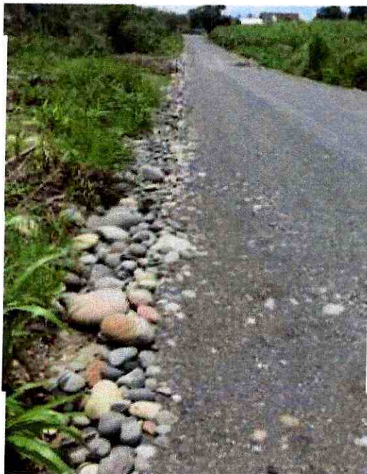
Carretero con subbase de clase 3
