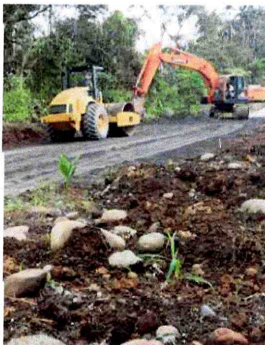
Compactado de material de mejoramiento
