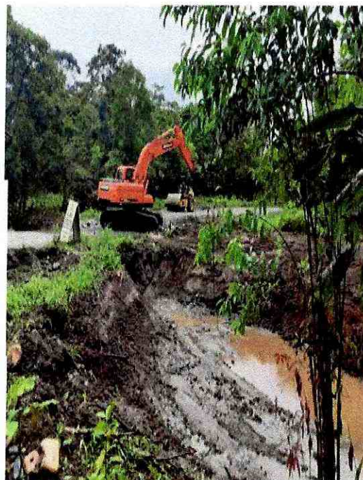
Excavación de canal
