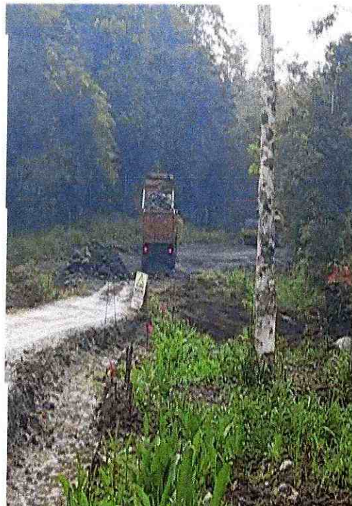
Compactado de material de mejoramiento
