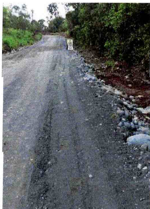
Carretero con material de mejoramiento
