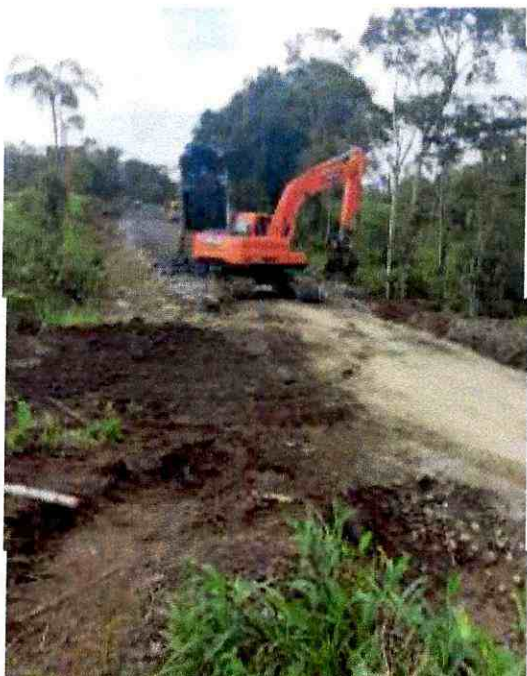
Descarga de material de mejoramiento
