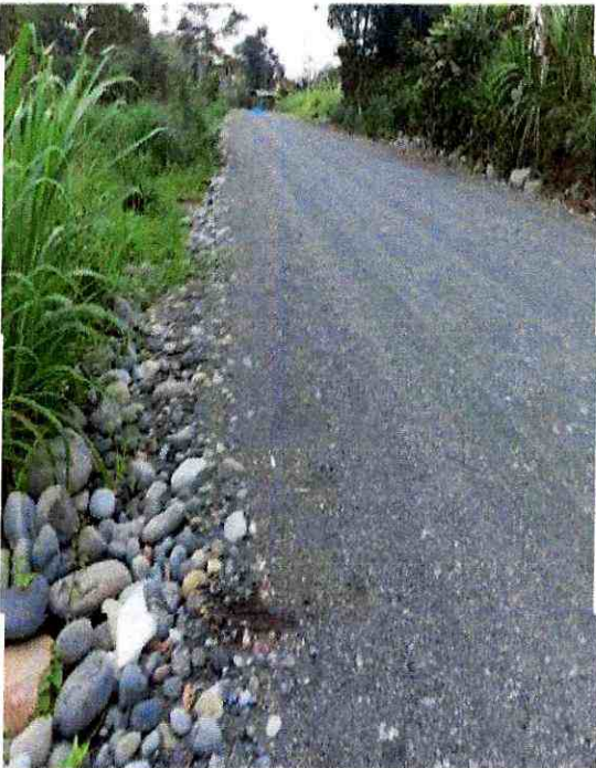
Carretero con subbase de clase 3
