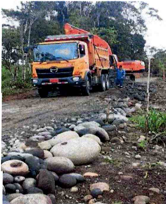
Descarga del material de mejoramiento
