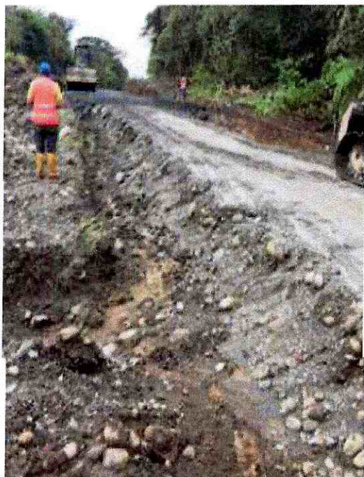
Compactado de material de mejoramiento
