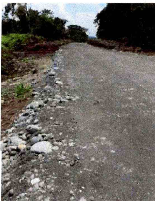
Carretero con material de mejoramiento
