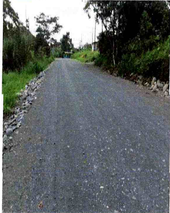
Carretero con material de mejoramiento
