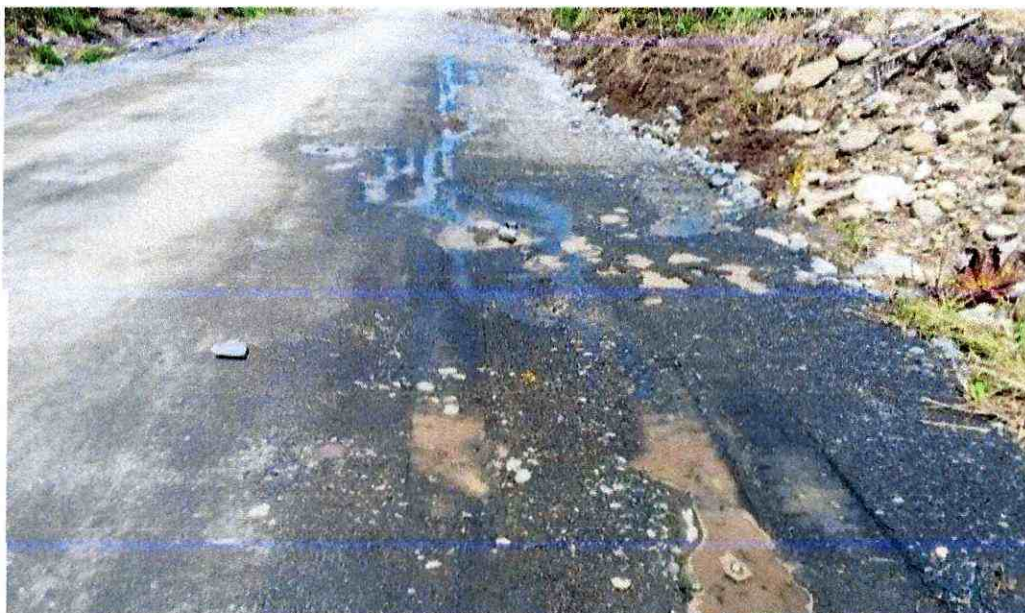
Fotografía 19 y 20. Vías despejadas en los distintos frentes del proyecto.
