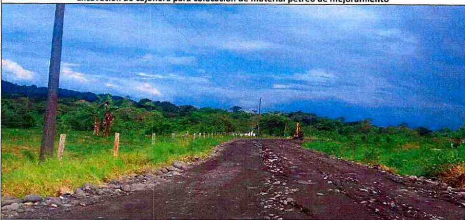
Tendido de material pétreo de mejoramiento
