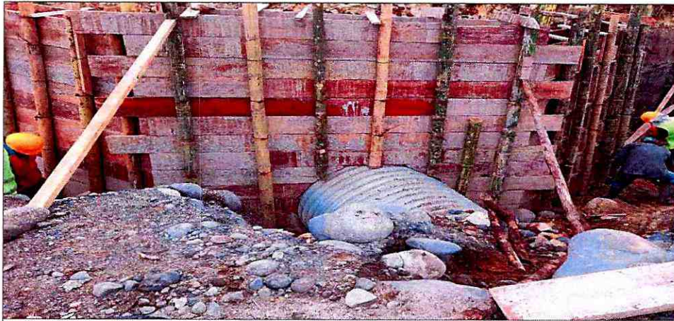
Encofrado de cabezales
