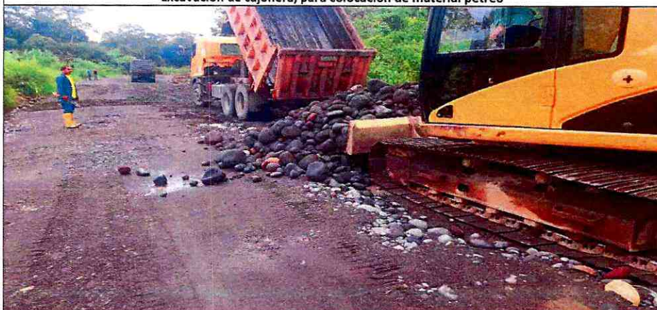
Transporte de material pétreo de mejoramiento
