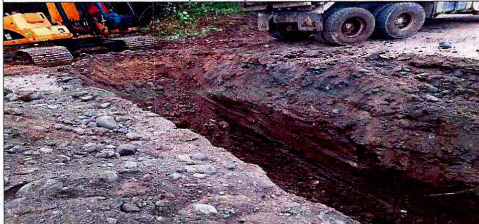
Excavación para tubería metálica D=1.20m
