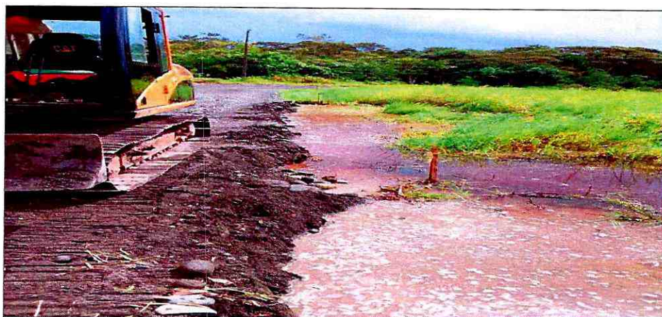
Tendido de material pétreo de mejoramiento
