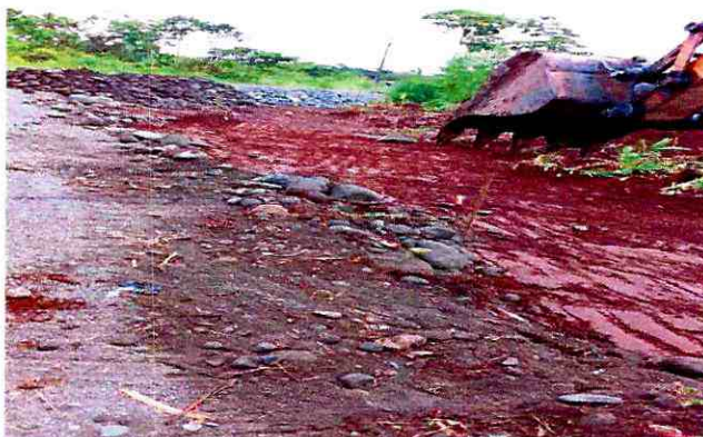
Excavación de cajonera, para colocación de material pétreo
