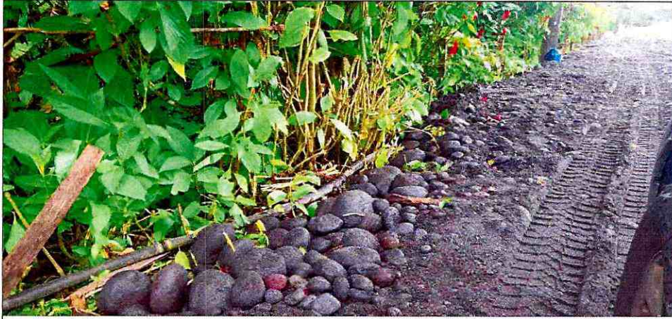
Relleno con material pétreo de mejoramiento
