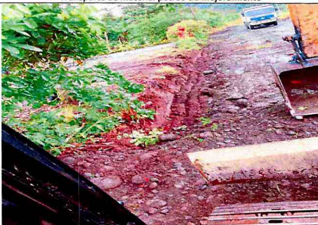
Excavación de cajonera para colocación de material pétreo
