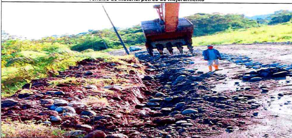
Excavación de cajonera para colocación de material pétreo de mejoramiento
