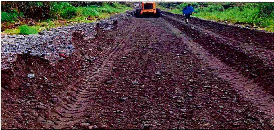
Tendido y compactado de sub base
