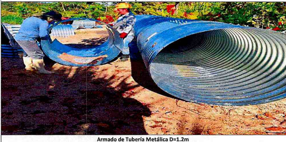
Armado de Tubería Metálica D=1.2m
