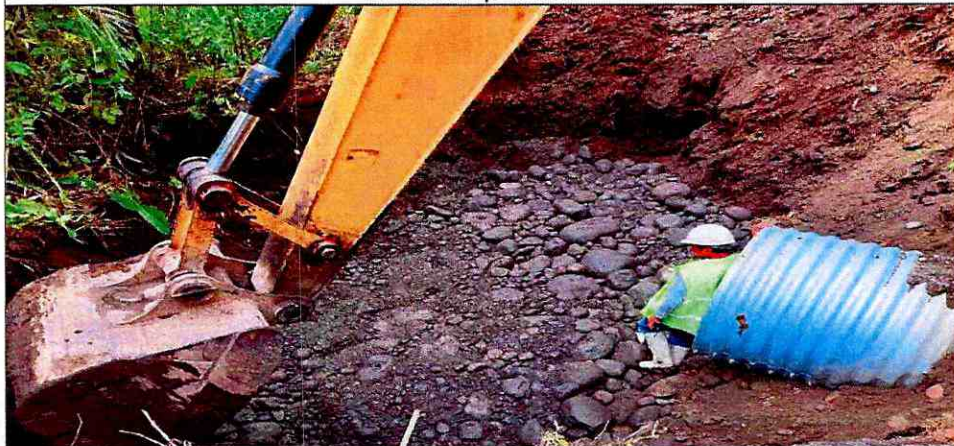
Relleno con material pétreo de mejoramiento en base para cabezal
