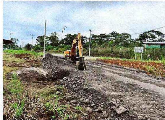
Material petreo de mejoramiento( minada , cargada y .regada)
