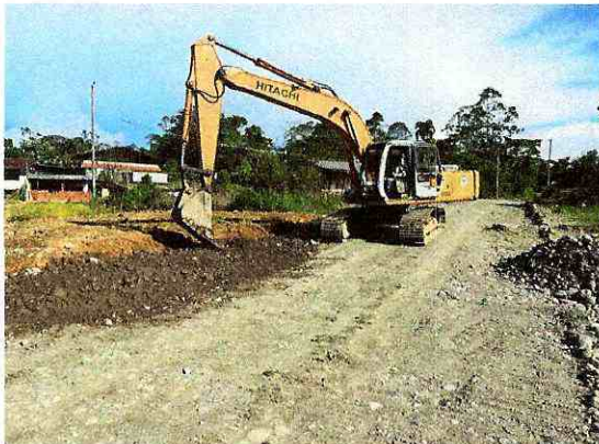
Material petreo de mejoramiento( minada , cargada y .regada)
