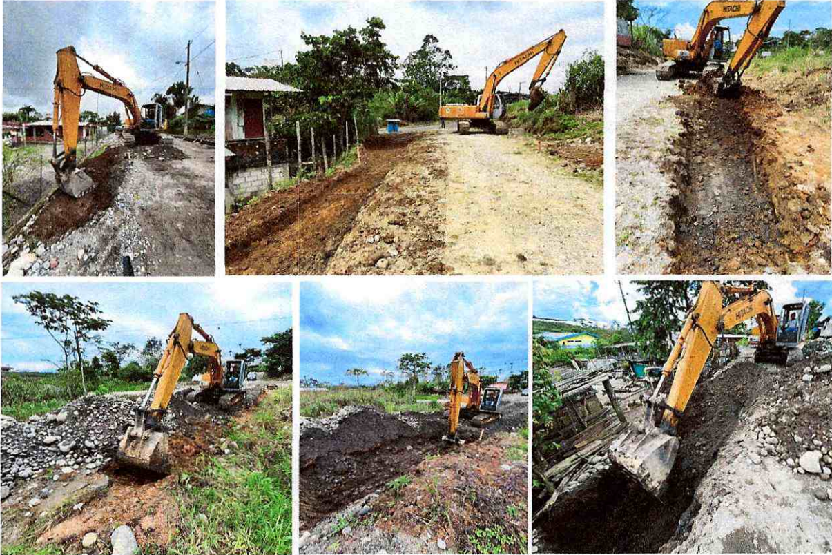
Excavación sin clasificar(mov.de tierra)
