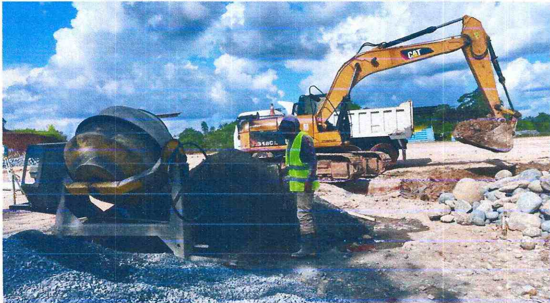
OBRA EN CONSTRUCCION
