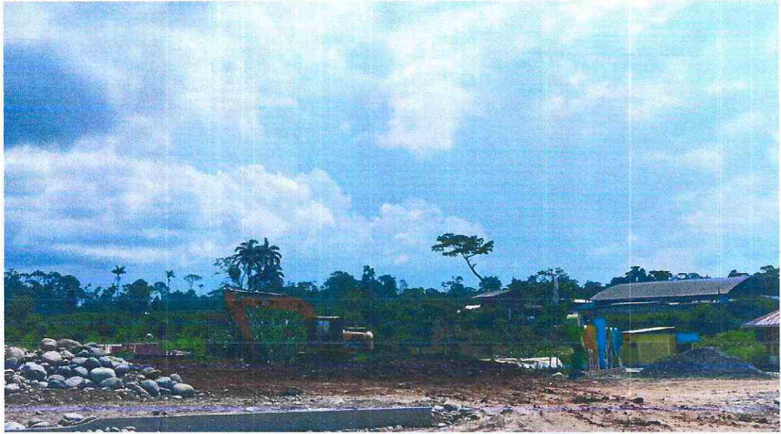
SITUACION ACTUAL DE LA ESCOMBRERA
