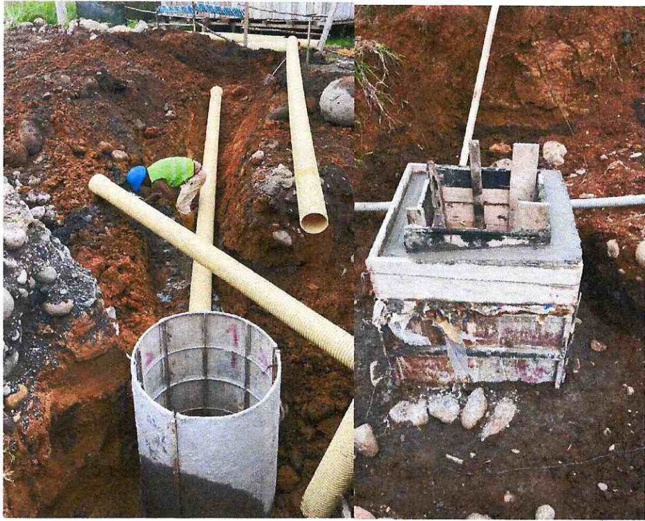
OBRA EN CONSTRUCCION
